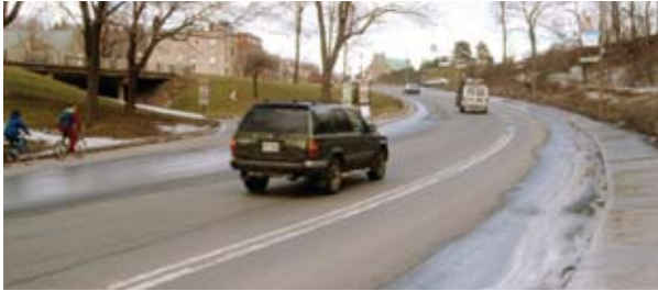
On Chemin de la Côte-des-Neiges where it meets Chemin Remembrance
