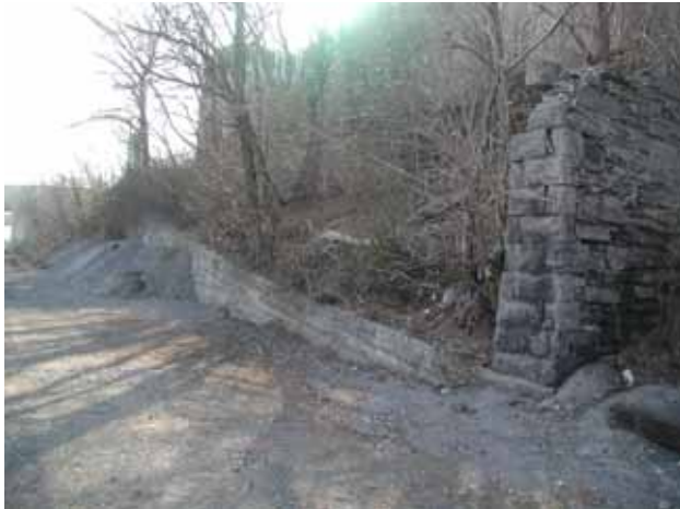
mur de soutènement en pierre
