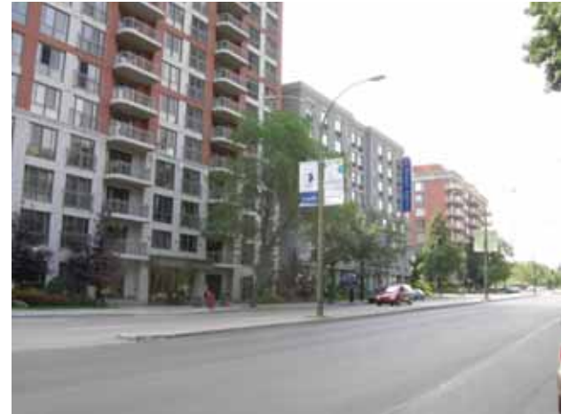
logements multifamiliaux sur René-Lévesque Ouest côté sud
