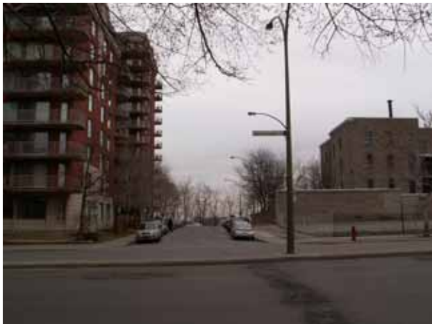
rue Joseph-Manseau vue sud
