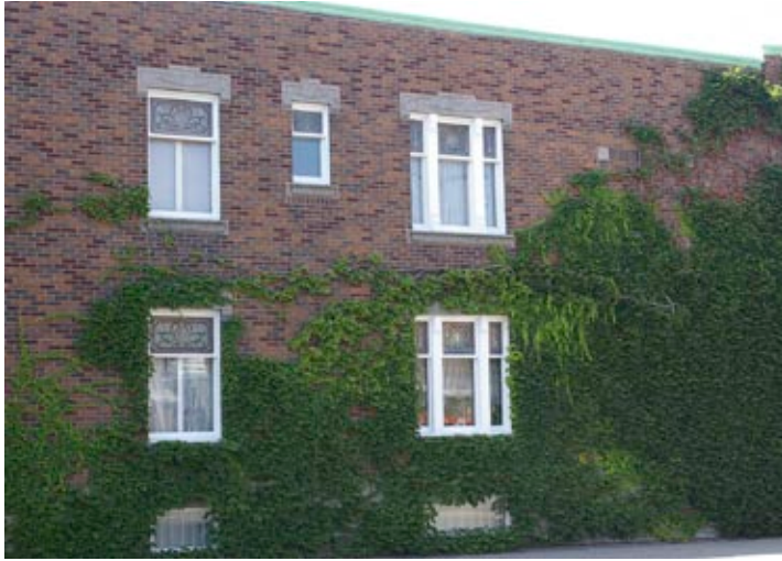
Mur partiellement végétalisé
