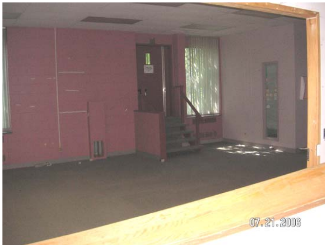
État actuel de l'intérieur de l'annexe. Vue vers l'accès aux constructions temporaires (roulottes de chantier)
