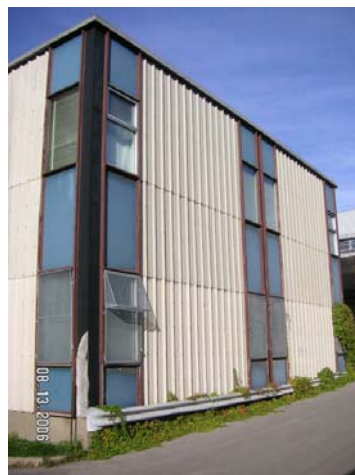
Façade ouest de l'annexe
