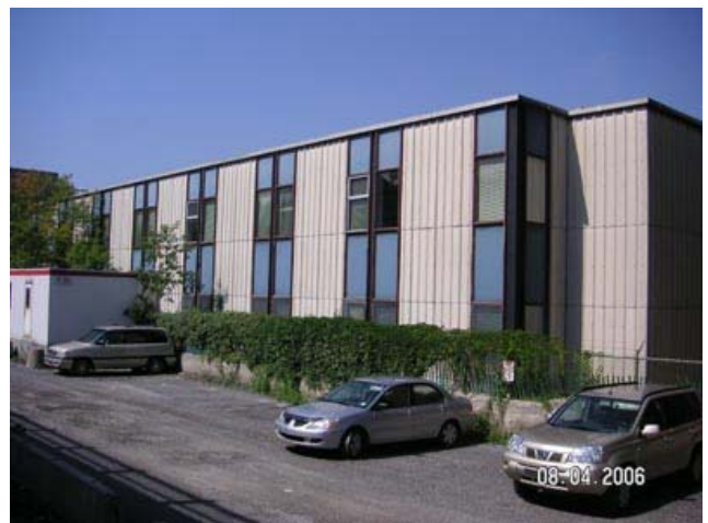
Façade sud de l'annexe
