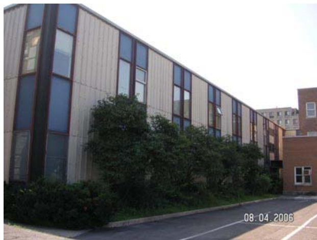
Façade nord de l'annexe
