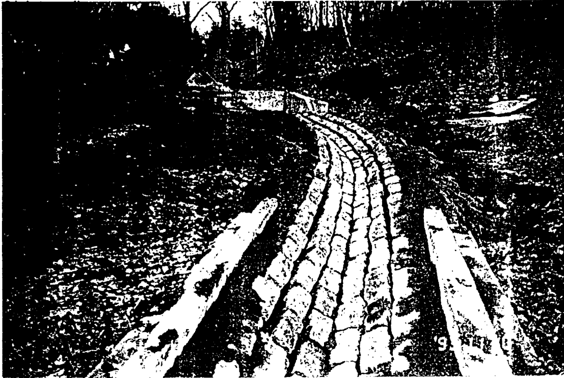
FOSSÉ D'ÉPURATION: EN CONSTRUCTION
