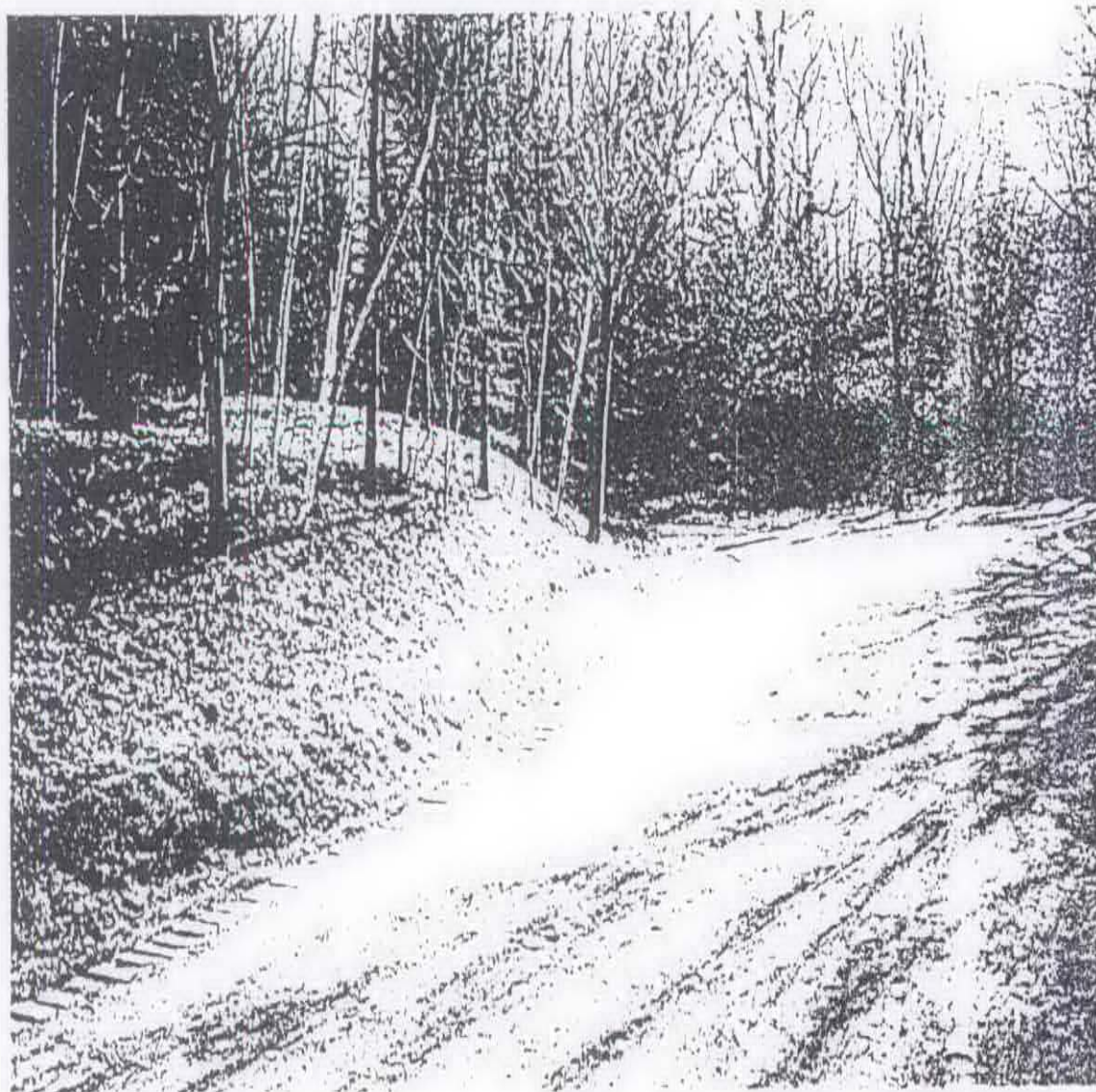
CANIVEAUX : TRAVAUX ACHEVÉS
