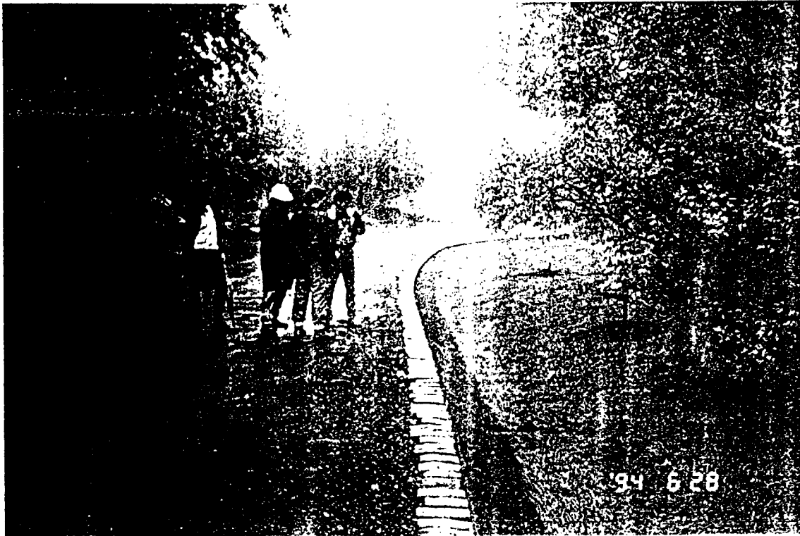
VÉRIFICATION DES TRAVAUX
