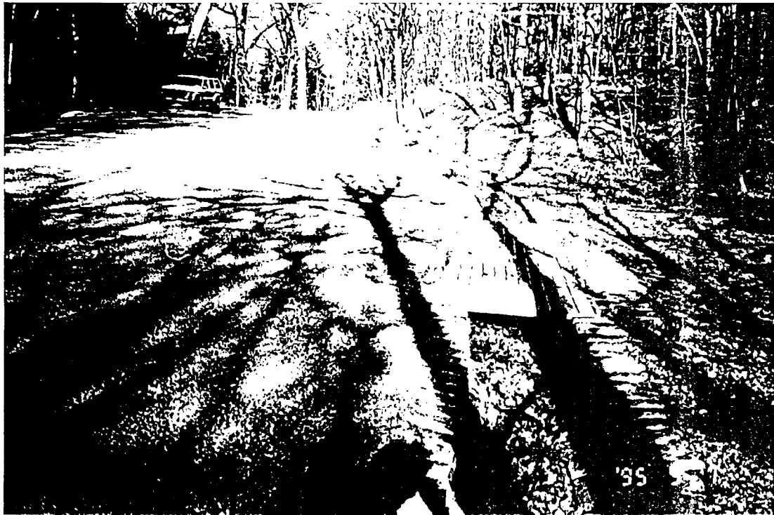
CANIVEAUX : TRAVAUX ACHEVÉS
