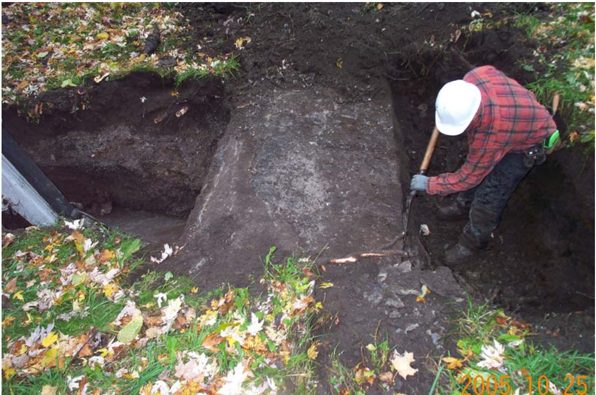
Photo 5 Couronne du réservoir proche de la chambre mécanique
