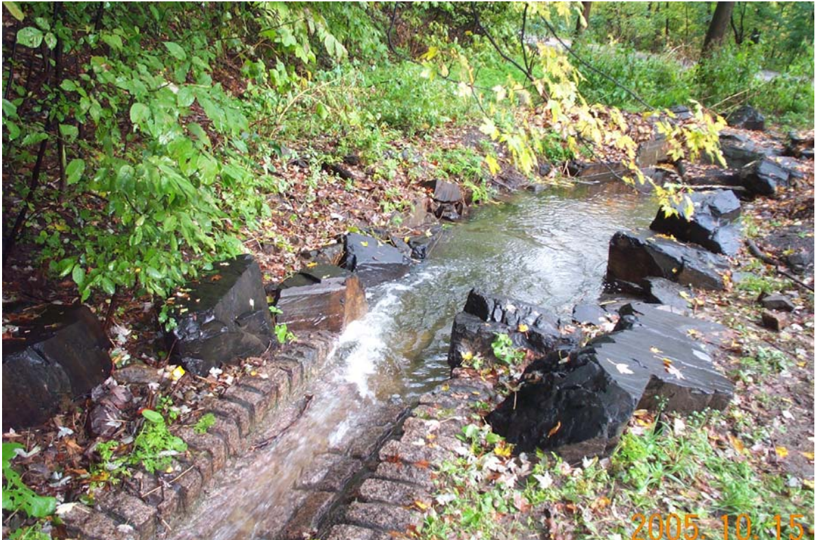
Photo 2 Caniveau du chemin Olmsted (caniveau rempli d'eau pluviale)
