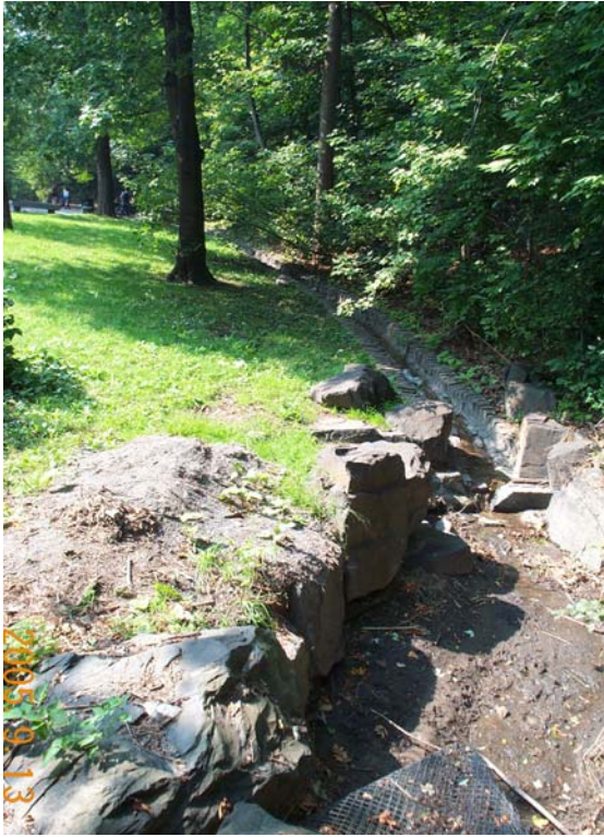
Photo B Caniveau le long du chemin Olmsted –sédimentation importante
