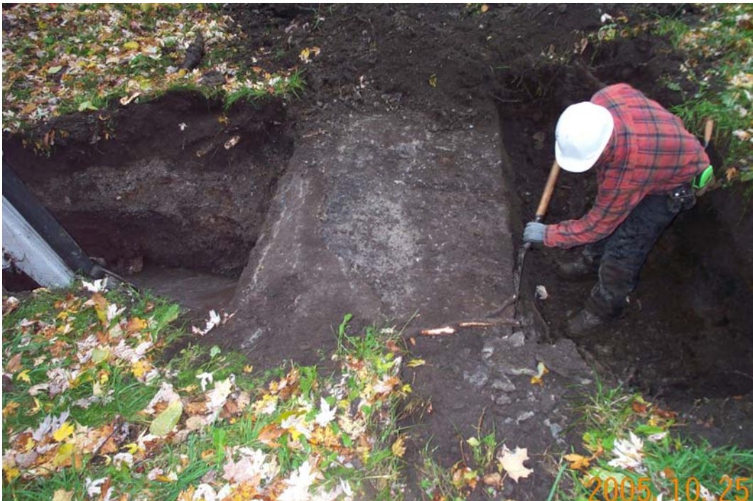
Photo H Couronne du réservoir proche de chambre mécanique
