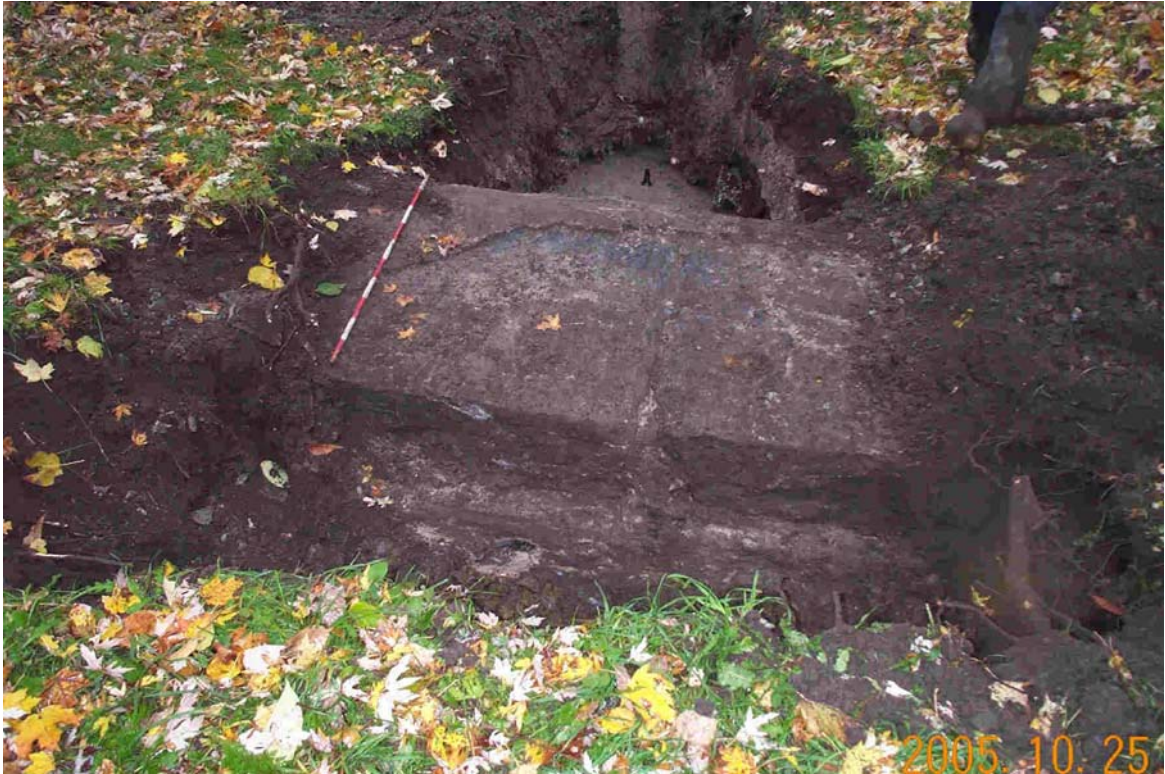
Photo E Couronne du réservoir – côté sud-est
