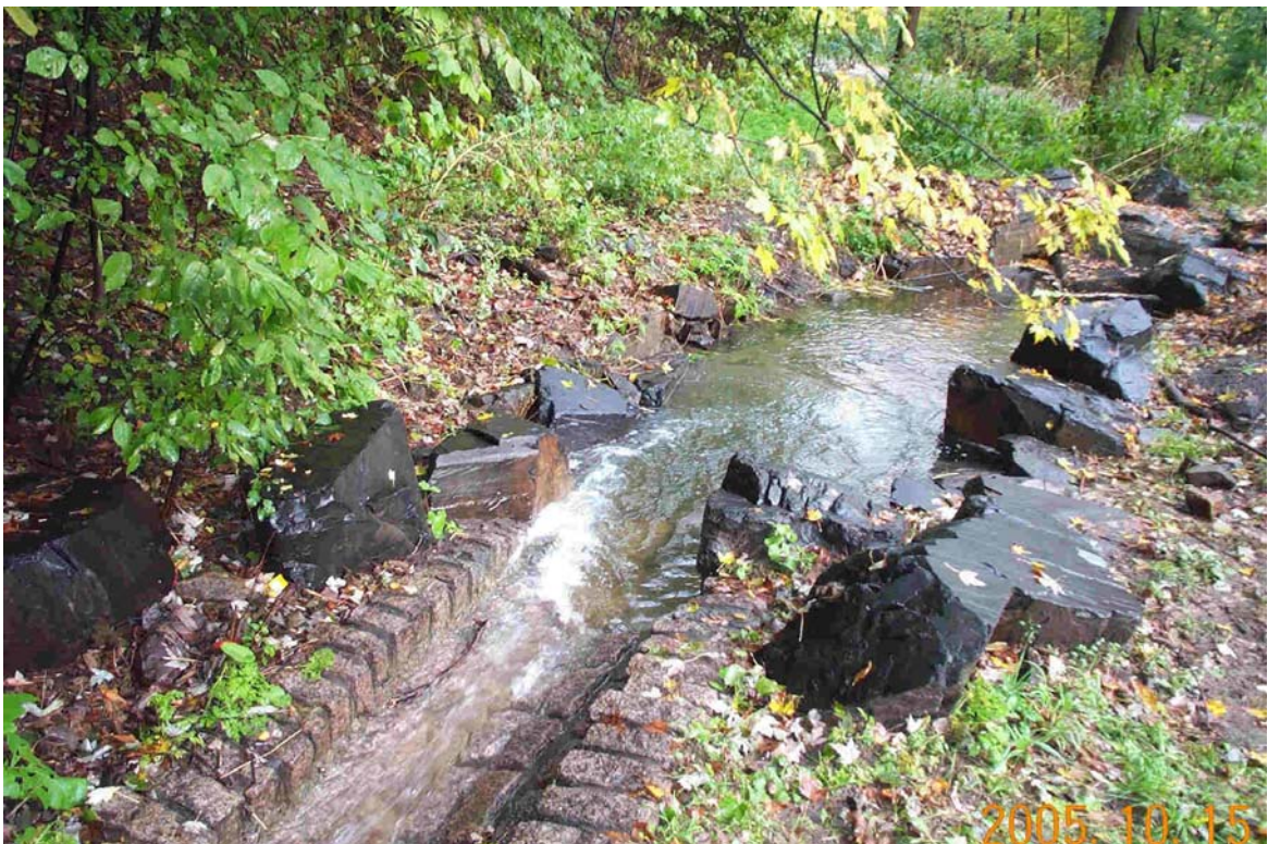
Photo A Caniveau le long du chemin Olmsted –quantité abondante des eaux pluviales, débit à caractère instable
