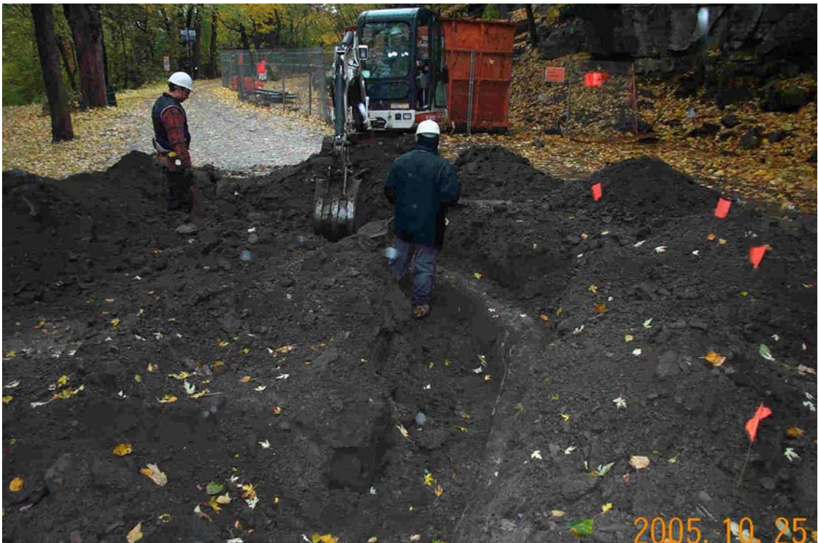
Photo F La couronne arrondie du réservoir arasé sous le chemin Olmsted
