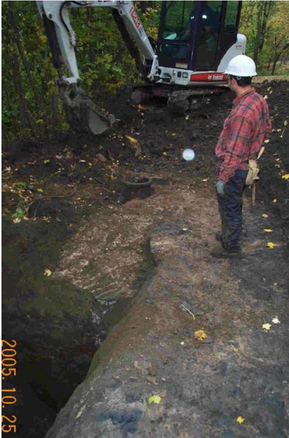
Photo G Exploration de la surface de chambre mécanique (côté sud de réservoir)
