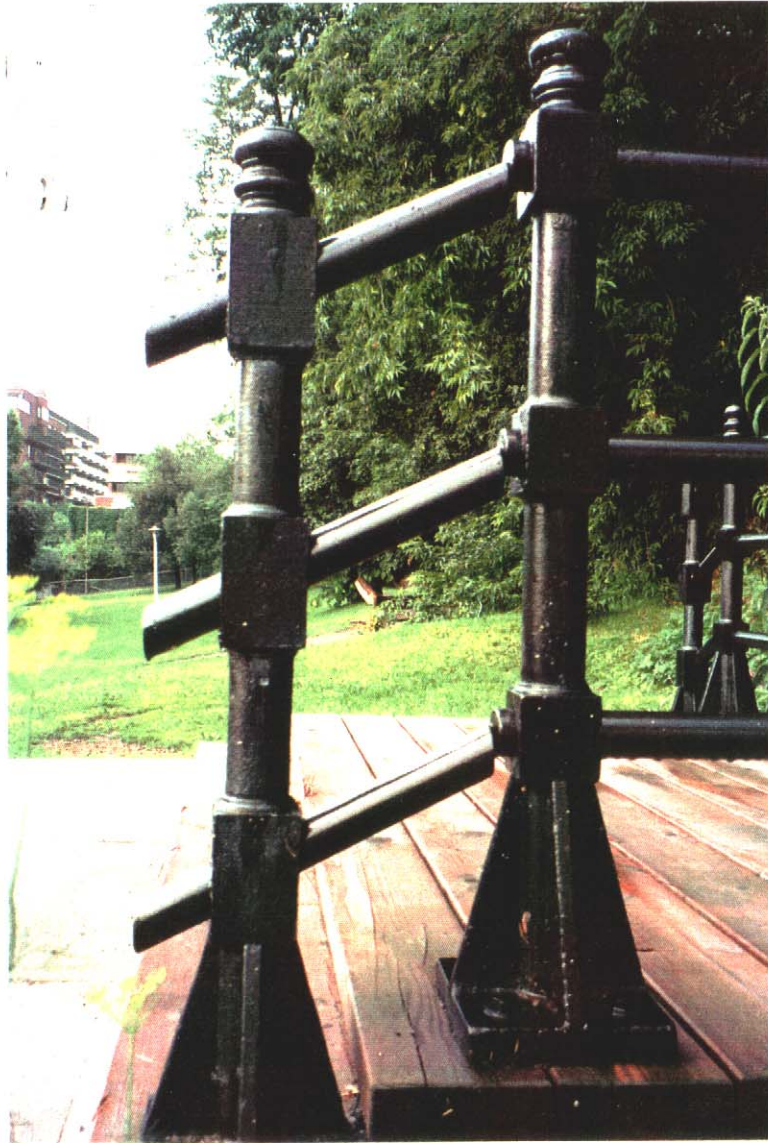
Escalier Redpath, détail du garde-corps
