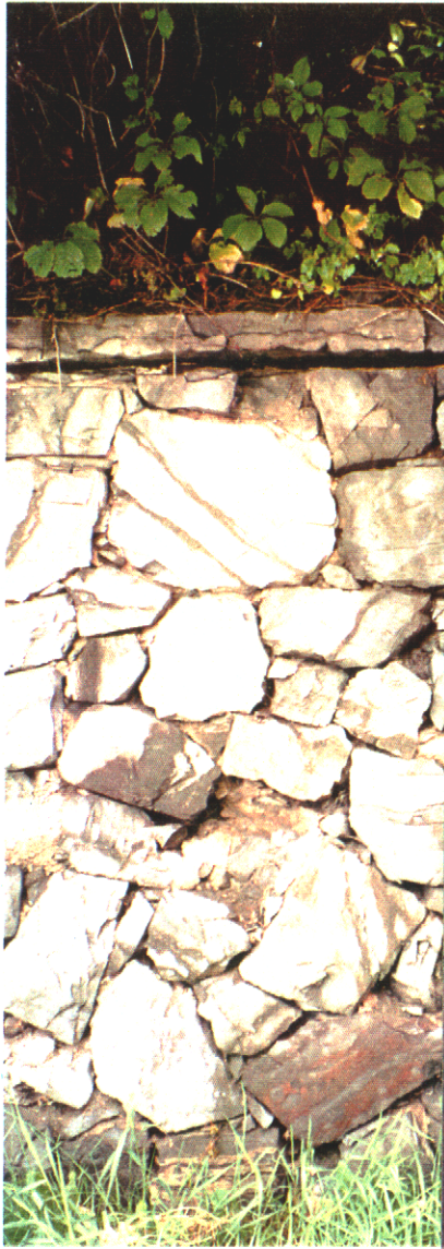
Mur de soutènement en pierre naturelle
