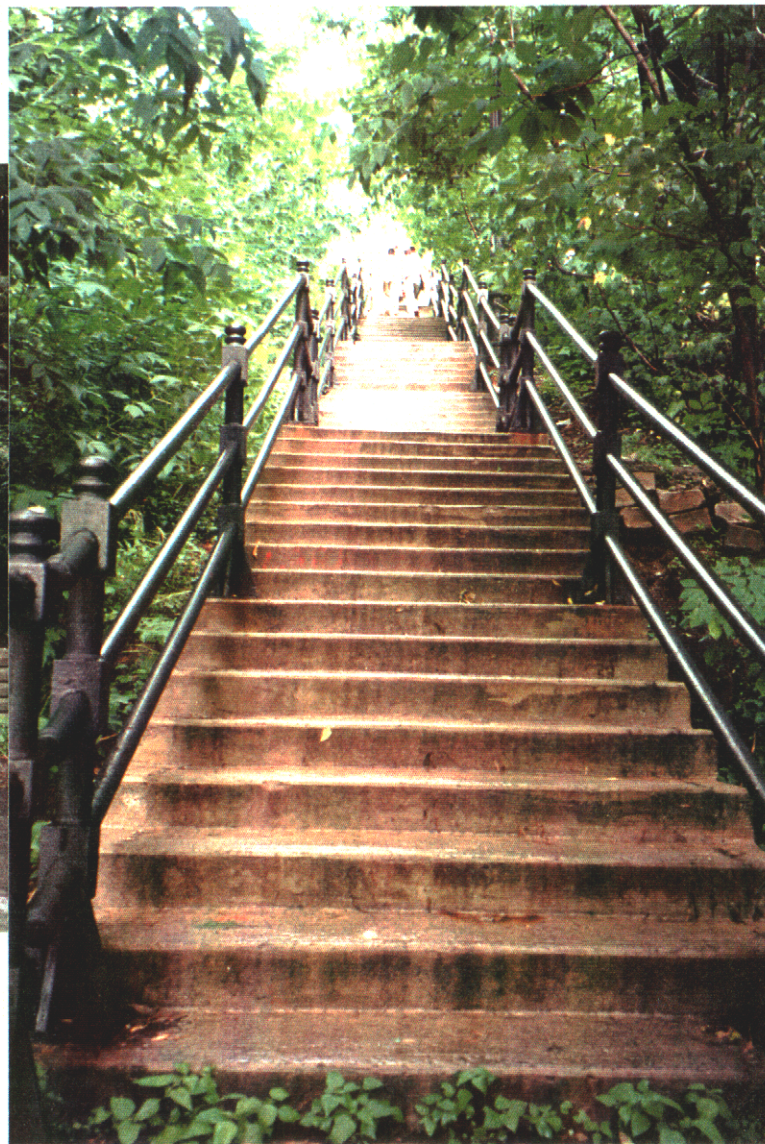
Escalier Drummond, vue du premier palier vers le haut
