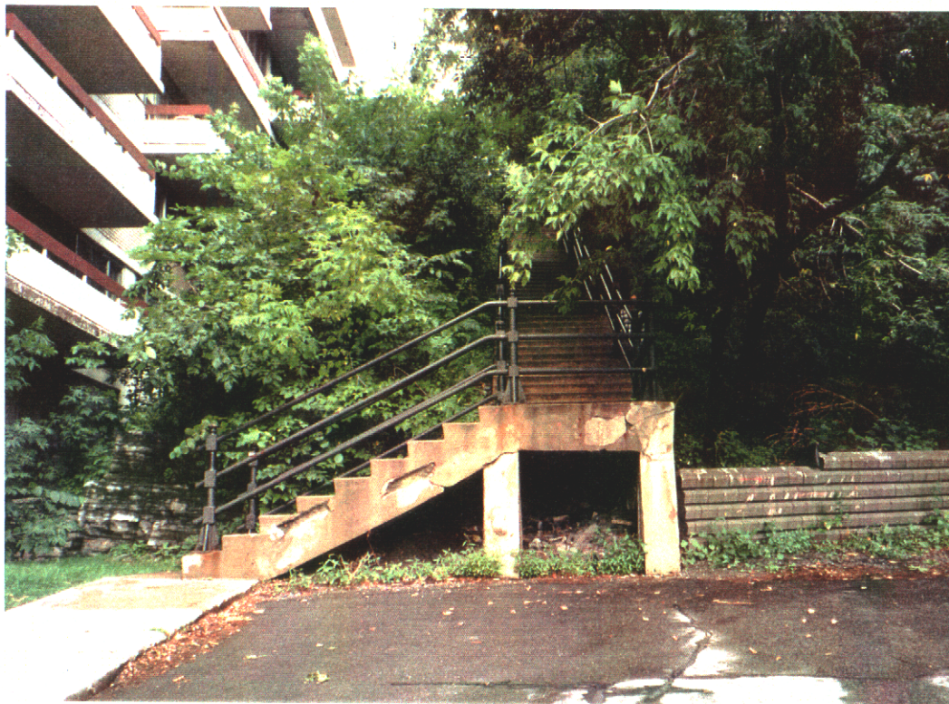
Escalier Drummond, vue de la rue Drummond, première volée en équerre, interface avec la rue peu esthétique et peu invitante.
