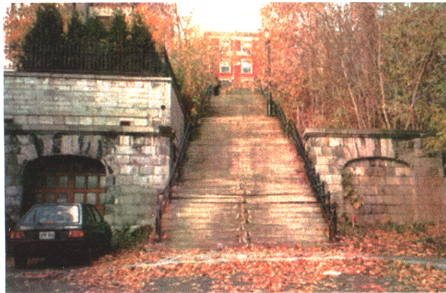
Escalier du Musée, vue de la rue du Musée
