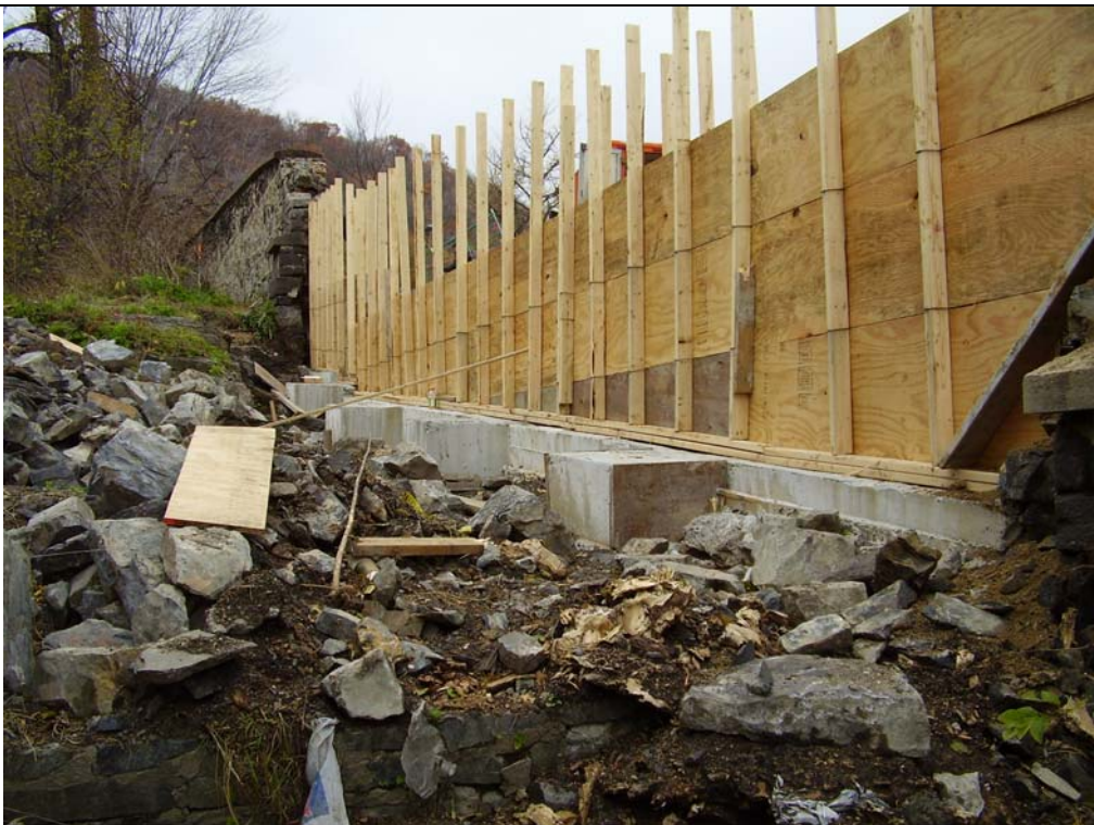
Reconstruction du mur de l'escalier McTavish
