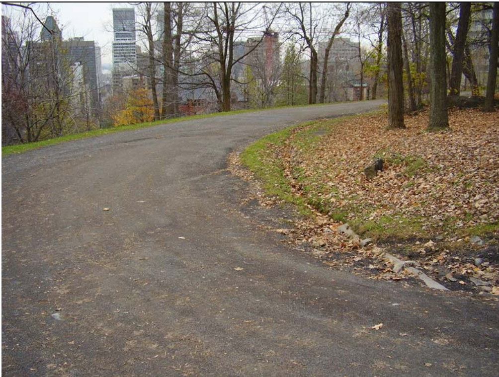
Écoulement dans le gazon et dans le chemin
