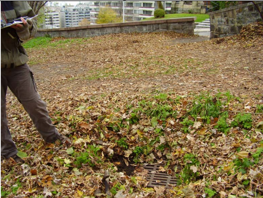
Regard relié à la canalisation de derrière l'abreuvoir
