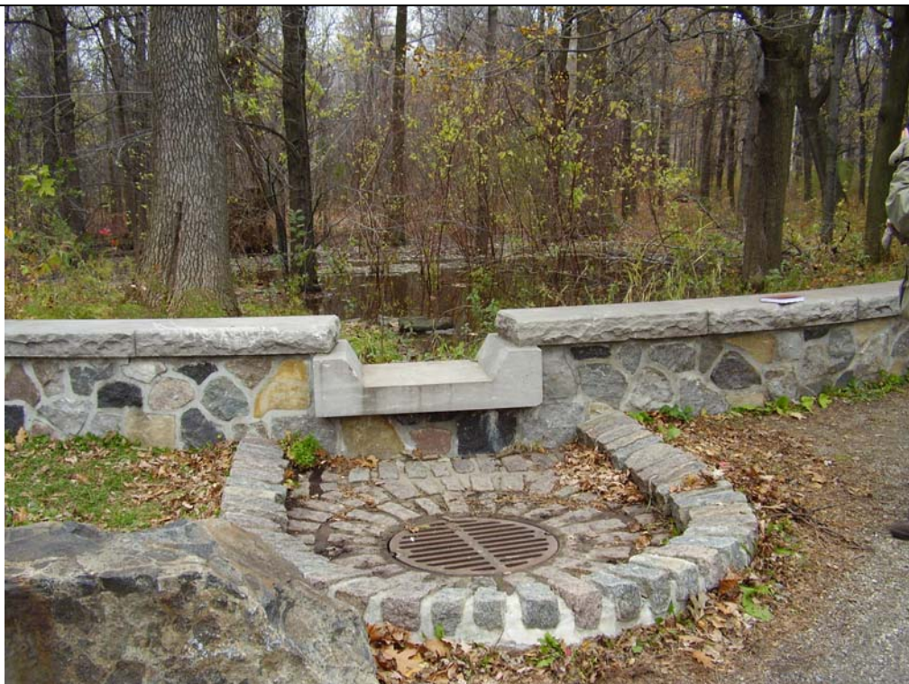
Muret, trop plein et caniveau situé devant le milieu humide derrière le chalet
