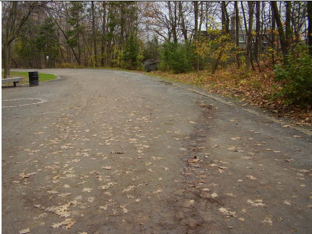
Trace de ravinement sur le chemin Olmsted
