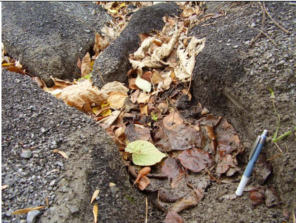
Gravité du ravinement dans l'escalier McTavish
