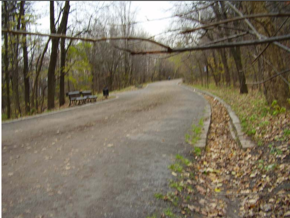
Fin du deuxième caniveau de briques
