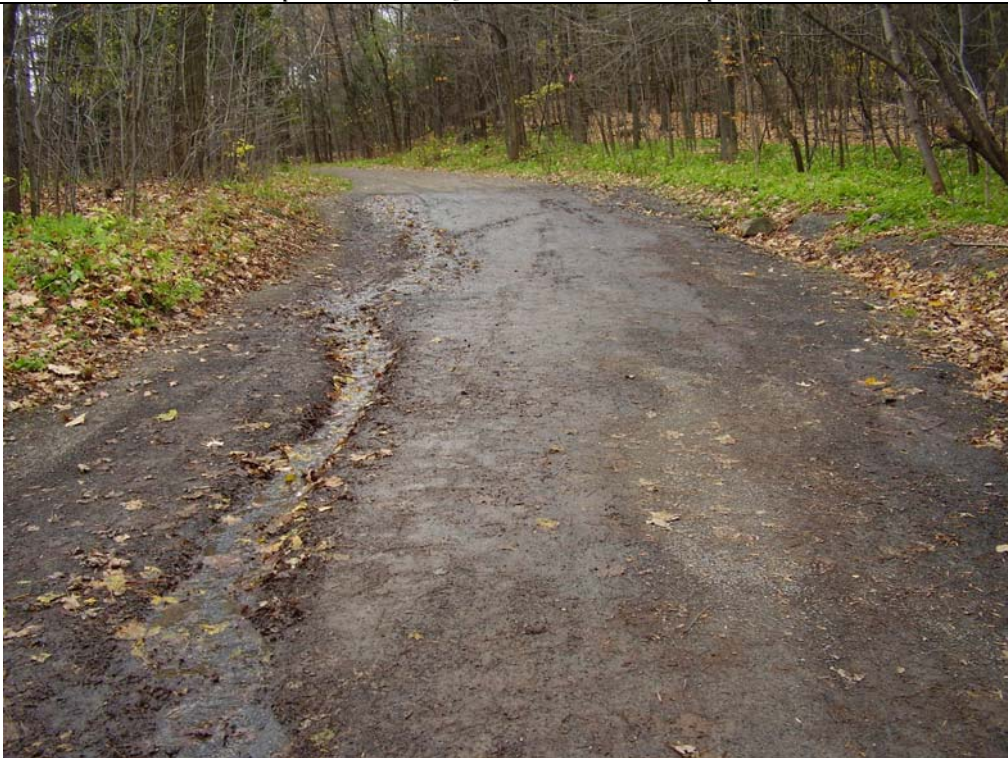
Ravinement sur le cinquième tronçon du chemin Serpentin
