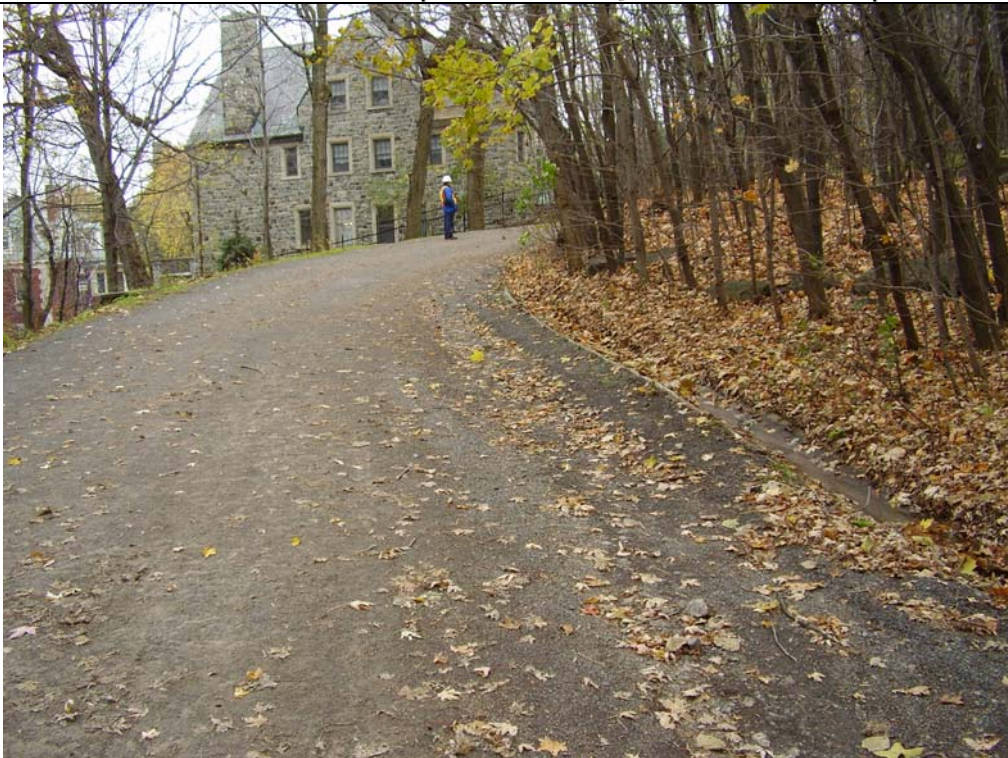
Fin du quatrième tronçon du chemin Serpentin avec le caniveau en béton
