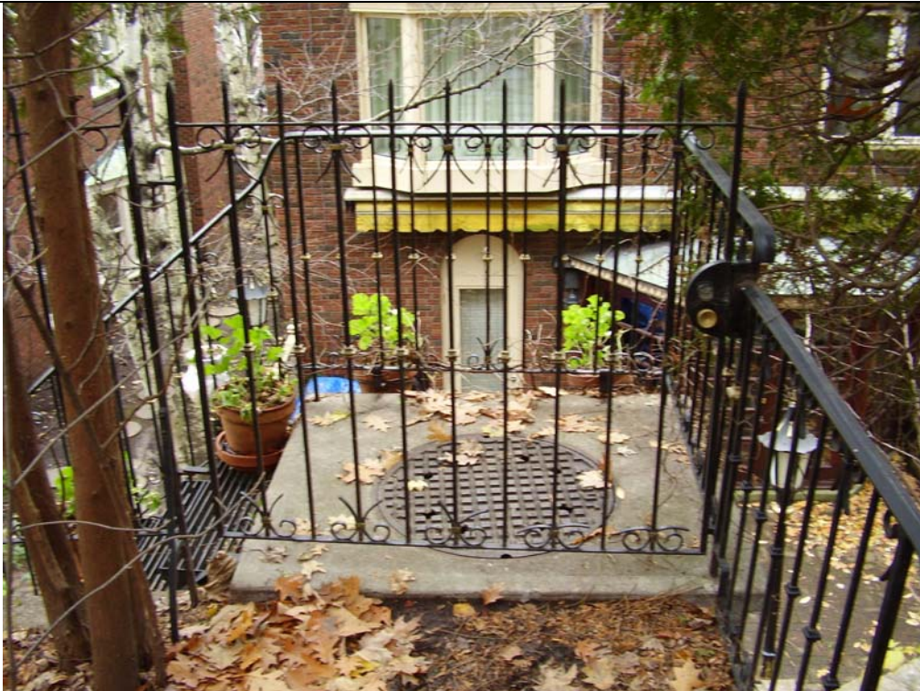
Regard des écoulements provenant de la canalisation située derrière l'abreuvoir
