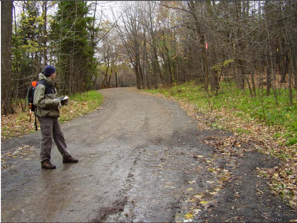
Résurgence dans le cinquième tronçon du chemin Serpentin
