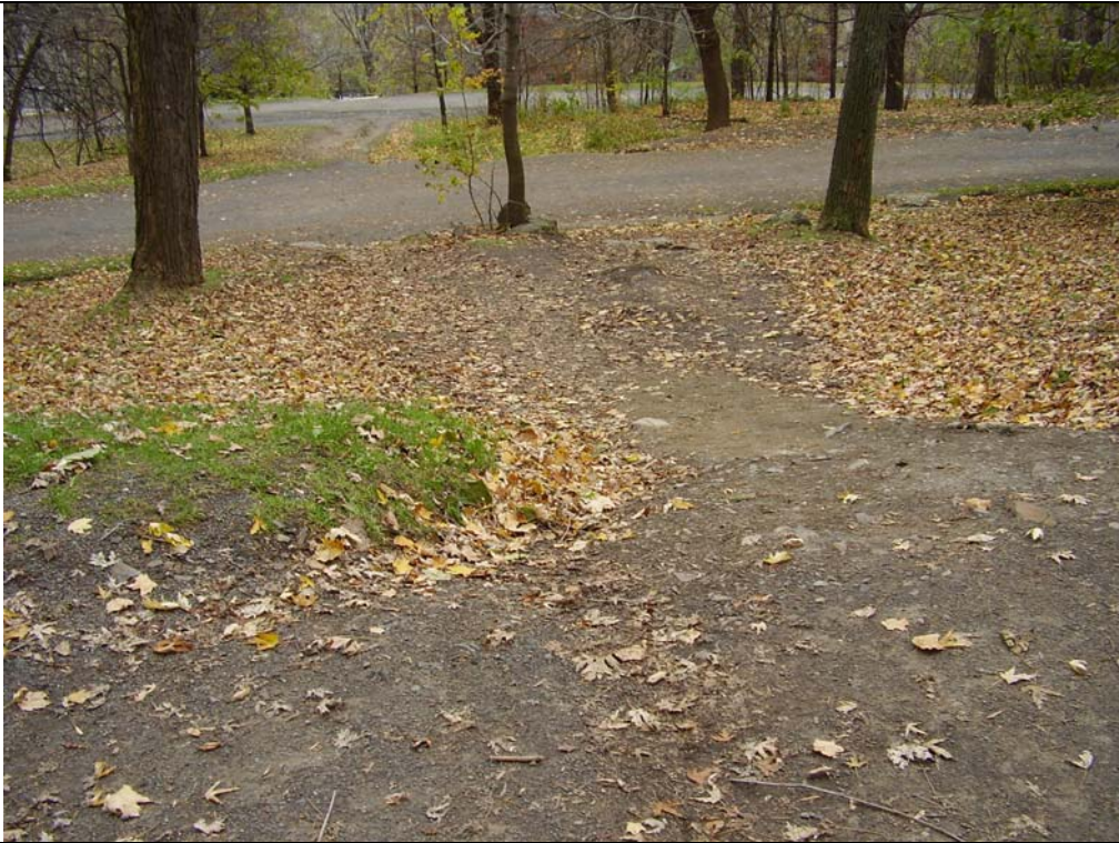
Deuxième partie du chemin transversal entre le deuxième et le troisième tronçon du chemin Serpentin : Surface en érosion et en ravinement
