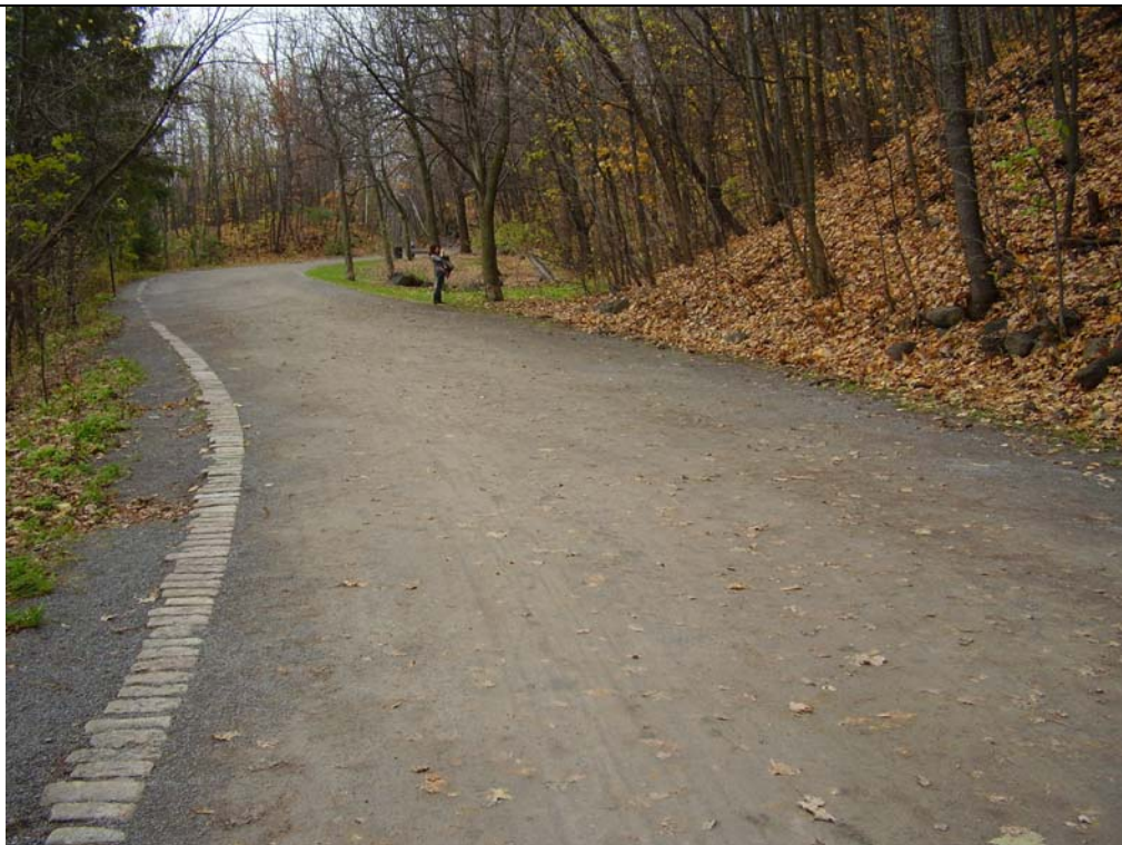
Partie du chemin Olmsted sans caniveau structuré
