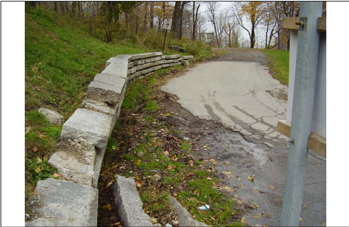
Caniveau en terre et partie du chemin Serpentin en asphalte
