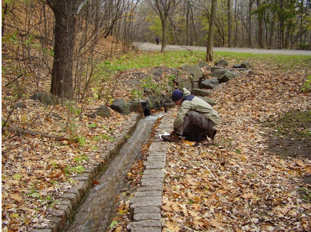
Caniveau en brique et début de la canalisation souterraine situé derrière l'abreuvoir
