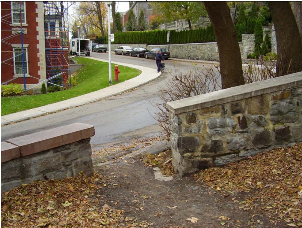
Entré dans le parc par la rue Redpath Crescent
