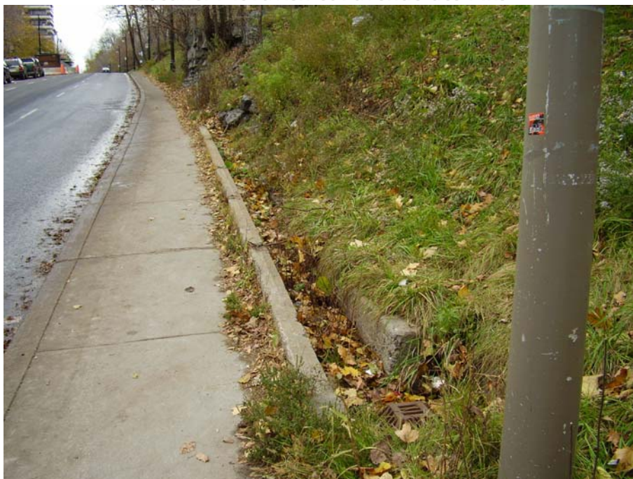
Caniveau de béton avec regard en bas de l'escalier McTavish
