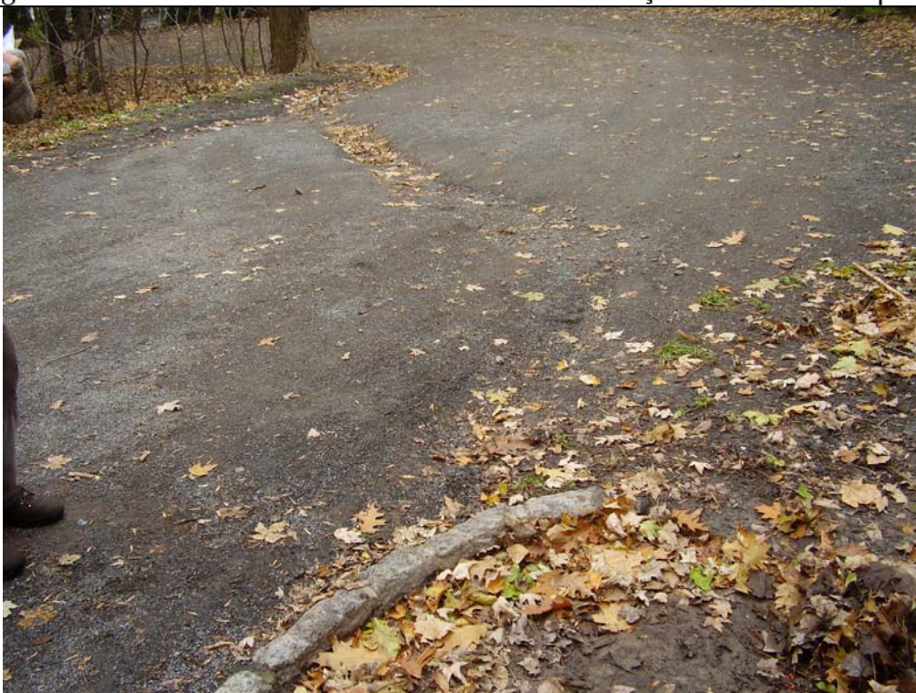
Ravinement provoqué par le comblement du regard
