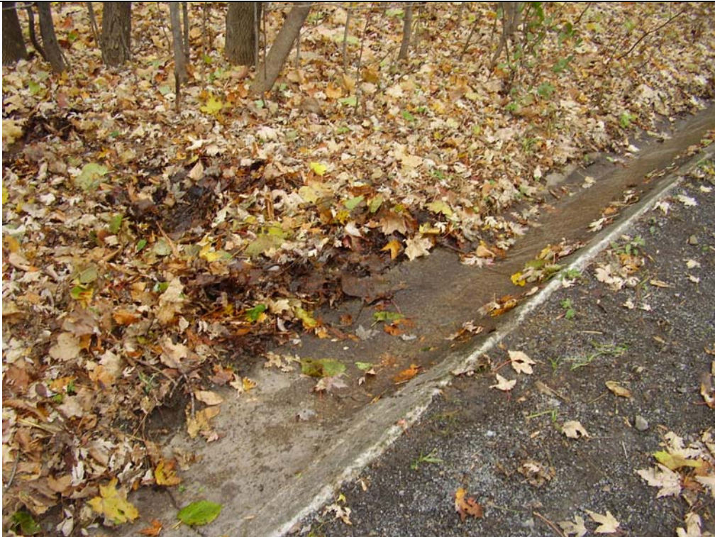
Exutoire du ruisseau intermittent 1
