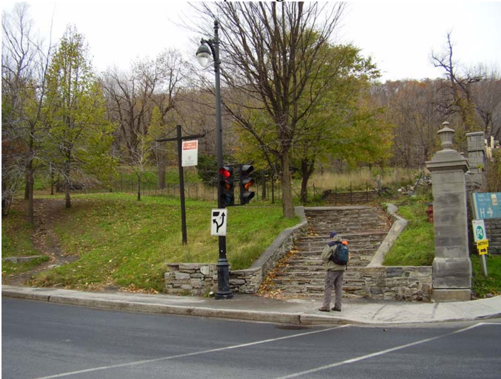
Escalier McTavish et l'avenue des Pins
