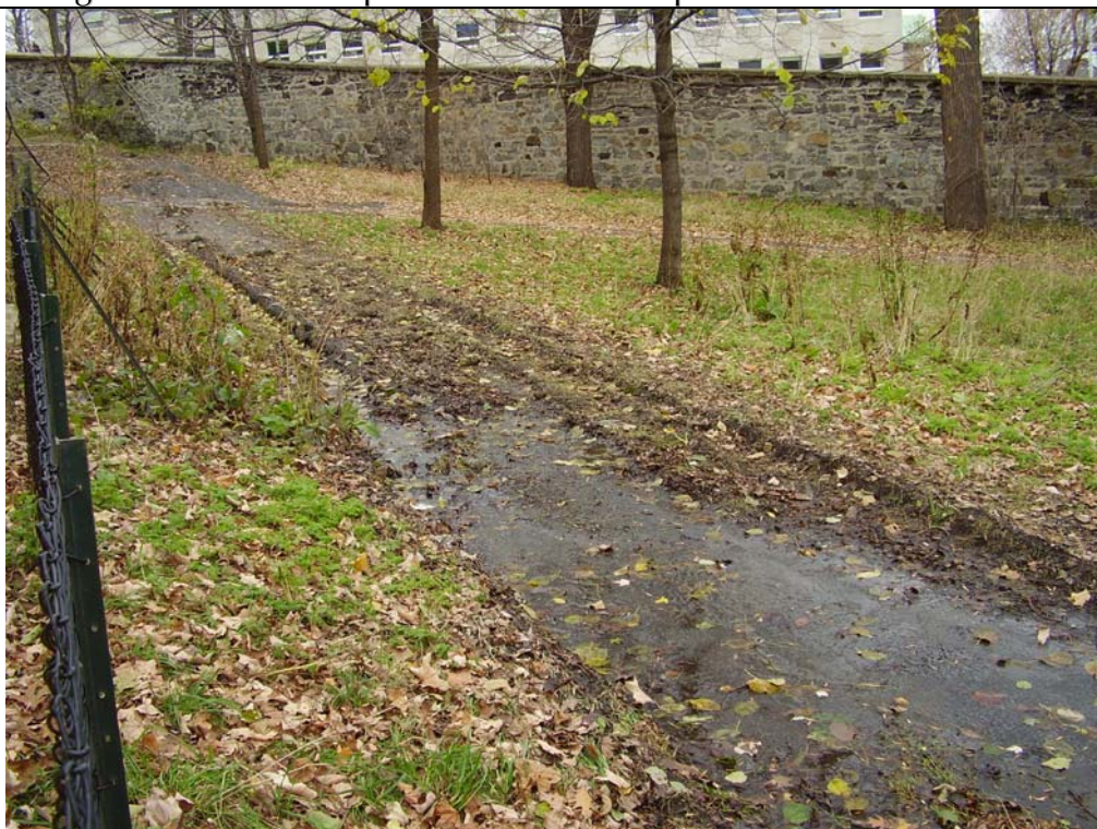
Accumulation d'eau sur le chemin McTavish
