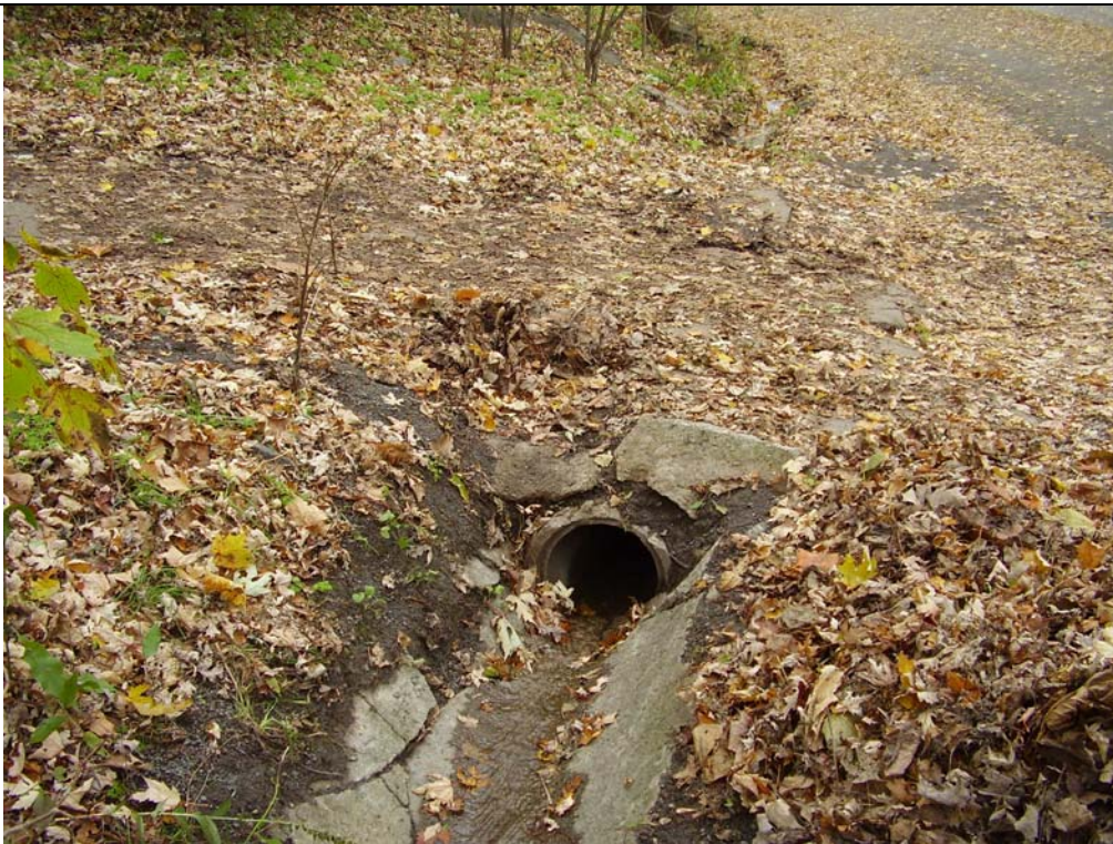
Ponceau de béton sous le chemin transversal
