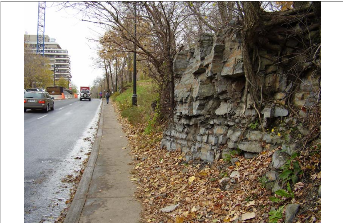
Affleurement rocheux de la partie ouest de la zone d'étude primaire
