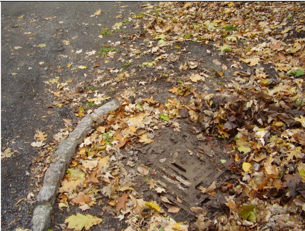
Regard comblé de sédiment au début du sixième tronçon du chemin Serpentin
