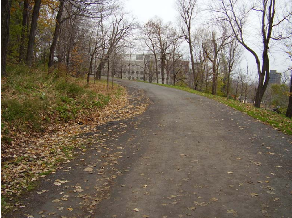
Premier tronçon du chemin Serpentin avec le ravinement et le caniveau en terre
