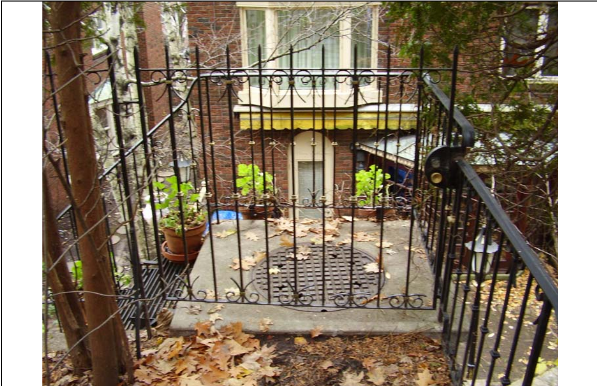
Regard des écoulements provenant de la canalisation située derrière l'abreuvoir
