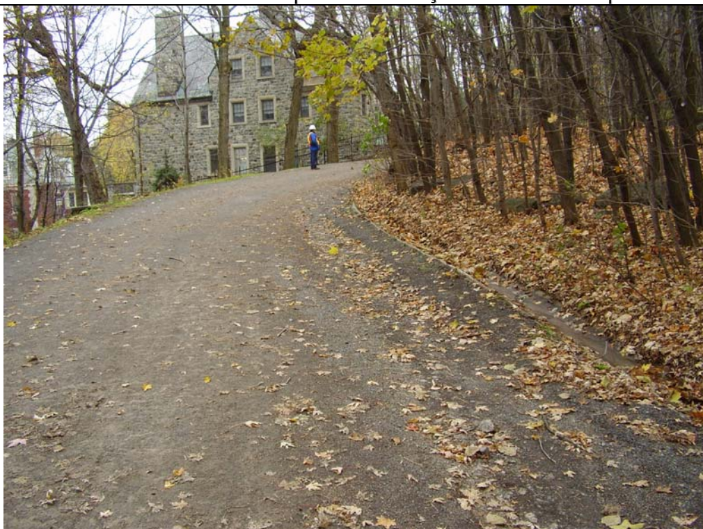
Fin du quatrième tronçon du chemin Serpentin avec le caniveau en béton
