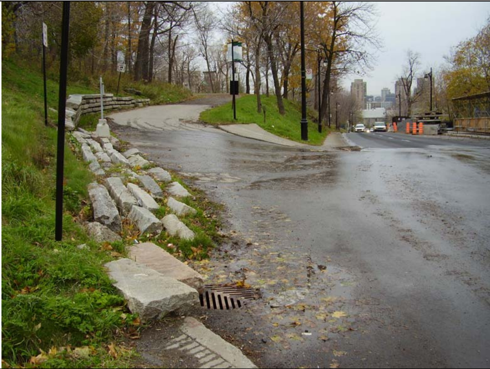
Mur de brique écroulé dans le caniveau qui se jette dans le regard de l'avenue des Pins
