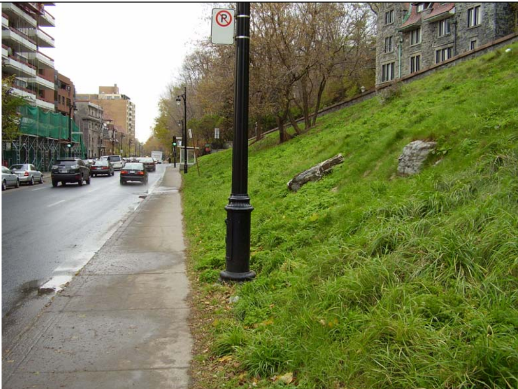
Talus entre le chemin Serpentin et la rue Redpath Crescent
