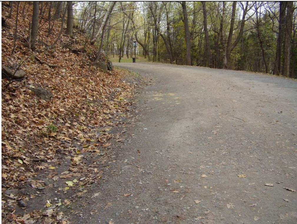
Secteur sans caniveau structuré du chemin Olmsted
