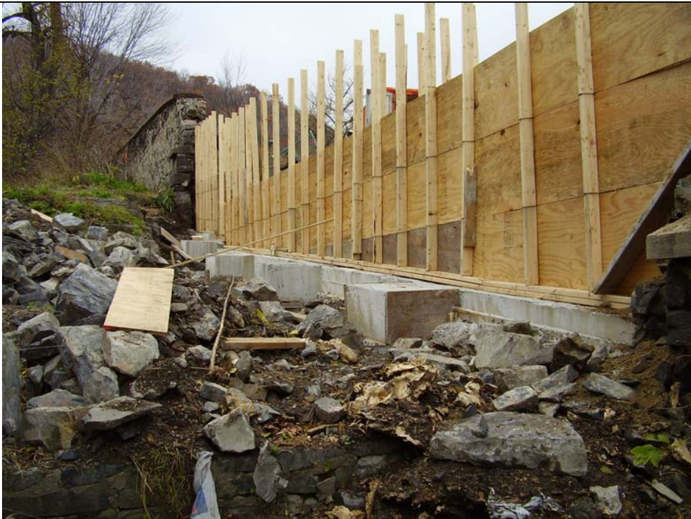
Reconstruction du mur de l'escalier McTavish
