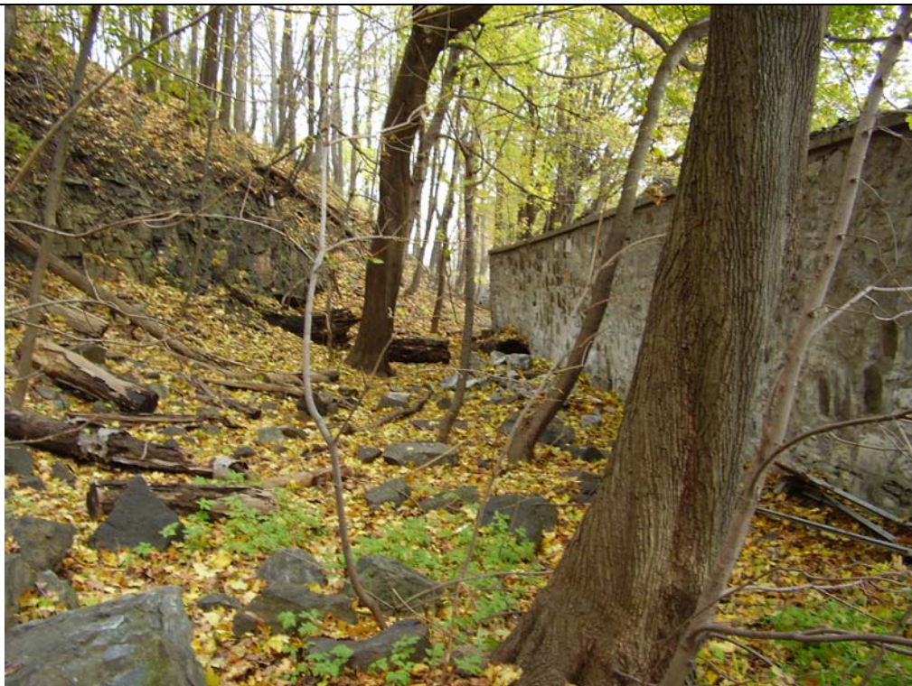
Accumulation probable d'eau près du mur du stationnement de l'hôpital Royal-Victoria
