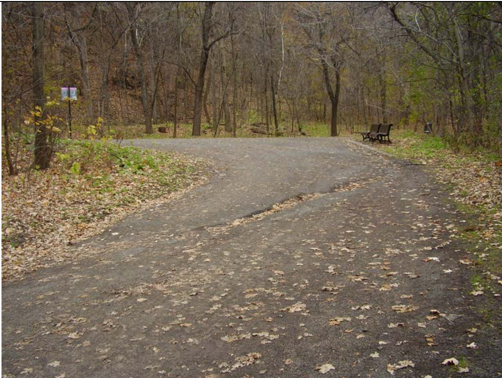
Ravinement transversal, l'eau provient du chemin de Olmsted
