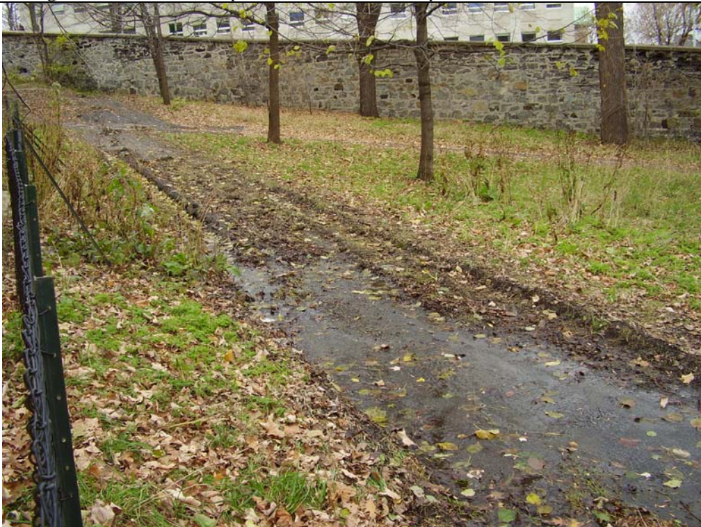
Accumulation d'eau sur le chemin McTavish
