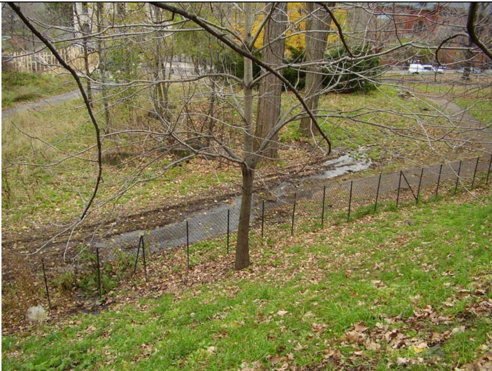
Accumulation d'eau sur le chemin McTavish
