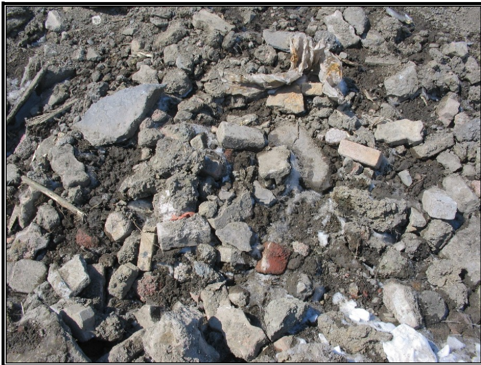
Photo 4 : Mélange de blocs de béton, pavé uni et brique.
