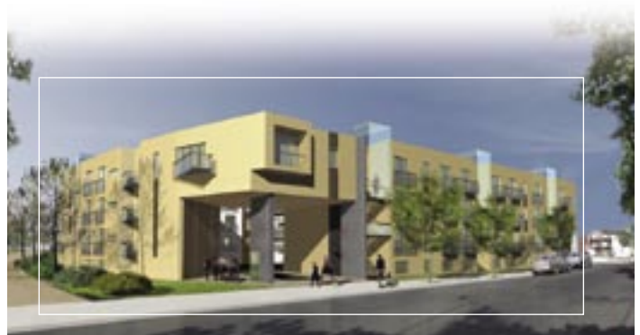
La valorisation du site Lavo, dans le quartier Hochelaga-Maisonneuve, est un exemple de concertation et d'inclusion. Grâce à l'appui financier du gouvernement du Québec, l'entreprise a pu être relocalisée. La configuration du site garantira une mixité sociale. À terme, 204 logements y seront construits.
