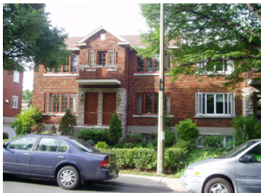
Duplex jumelé sur la rue McShane
