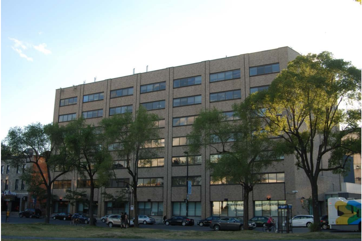
L'aspect actuel de l'ancien entrepôt J.-B. Baillargeon, juillet 2012.
