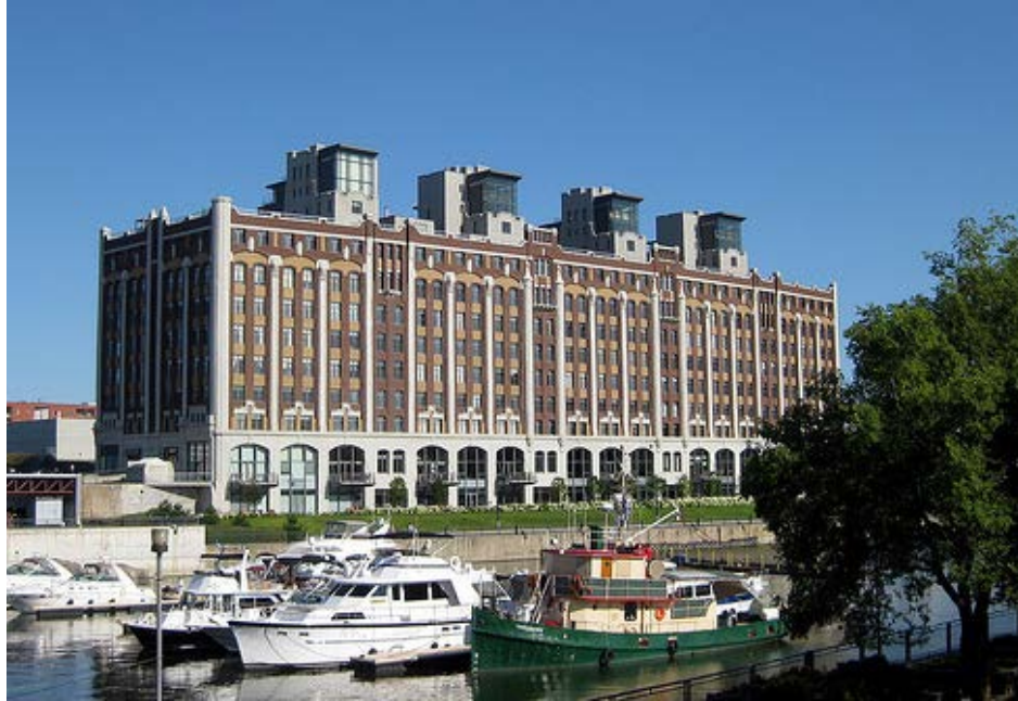
Entrepôt frigorifique du Port de Montréal après les travaux de recyclage. Source : Flickr @wallyg.
