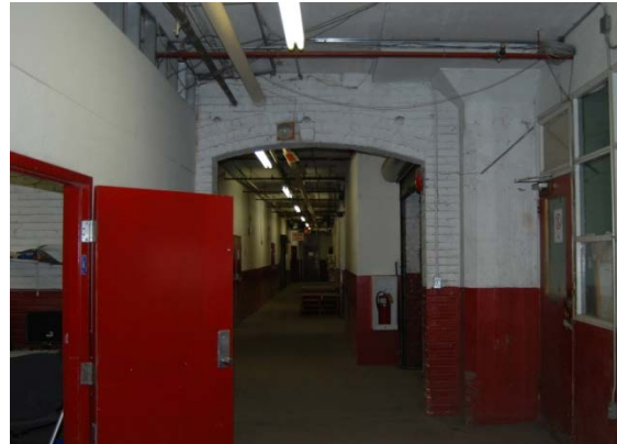
Cloisonnement au niveau du rez-de-chaussée, mai 2012.
