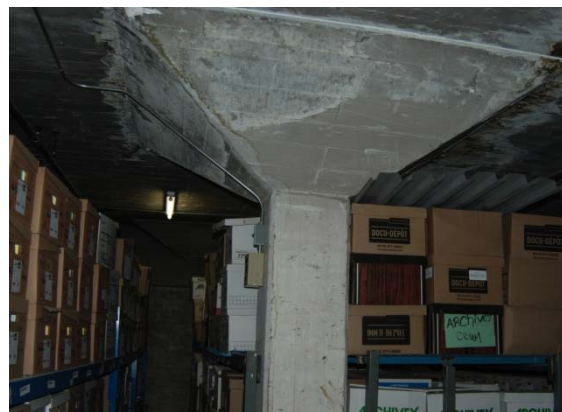
Structure de dalle sur colonne champignon au dernier niveau, juin 2012.
