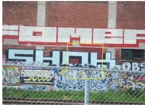
Porte de quai obturée de la façade nord. En liséré jaune, un exemple, juin 2012
