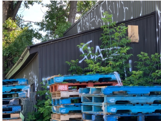
Appentis sur la façade ouest, juin 2022.
