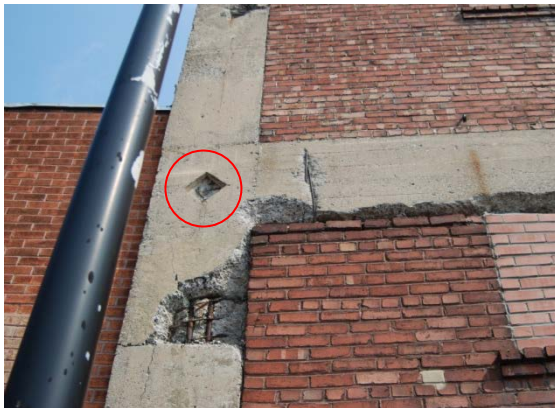
Armature apparente et absence de l'élément décoratif (encerclé en rouge), juin 2012.
