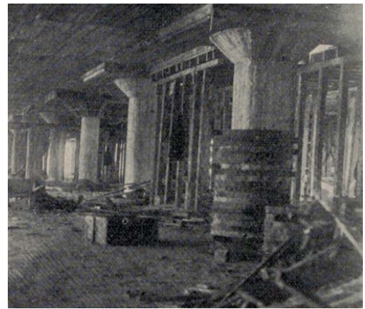
Intérieur de l'entrepôt frigorifique. Source : "A Massive Cold Storage Warehouse", Contract Record and Engineering Review , vol. 36, no 52, 27 décembre 1922, p. 1233-1240.
