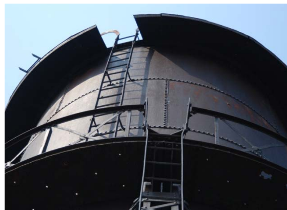
Château d'eau du St. Lawrence Warehousing, juin 2012.
