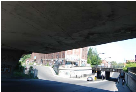
Environnement de viaducs (ferroviaire et routier), juin 2012.
