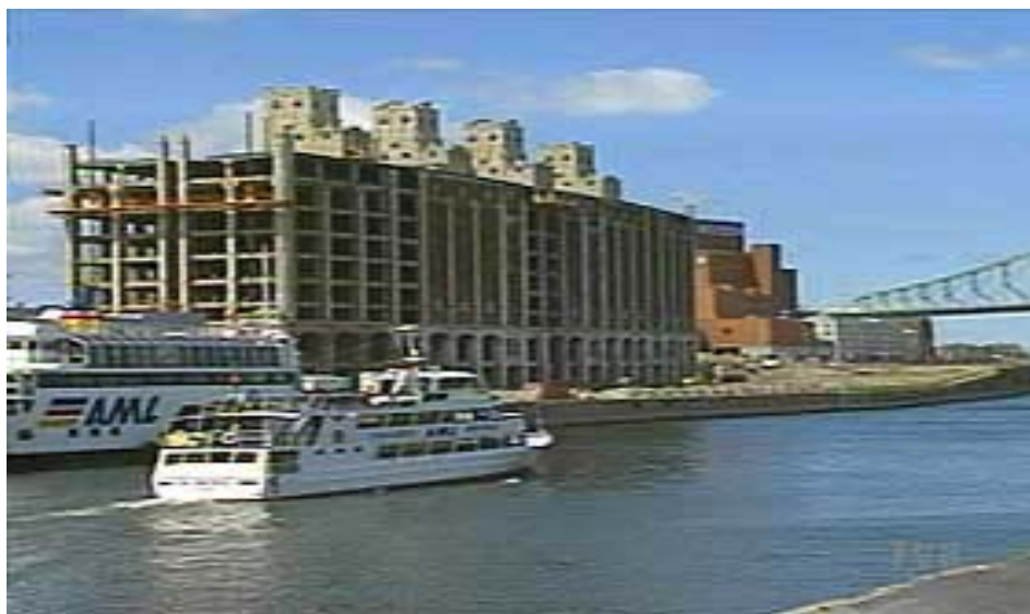
Entrepôt frigorifique du Port de Montréal lors des travaux de recyclage. Source : TVA nouvelles.
