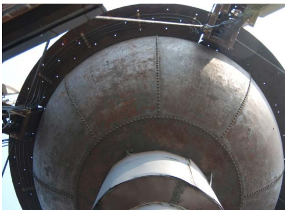
Château d'eau du St. Lawrence Warehousing, juin 2012.
