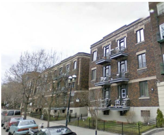
Les Appartements Roxy (3655-3681, rue Sainte-Famille) – Propriétaire constructeur : J. T. Z. Patenaude, 1928. Source : Google Street View, 2012.
