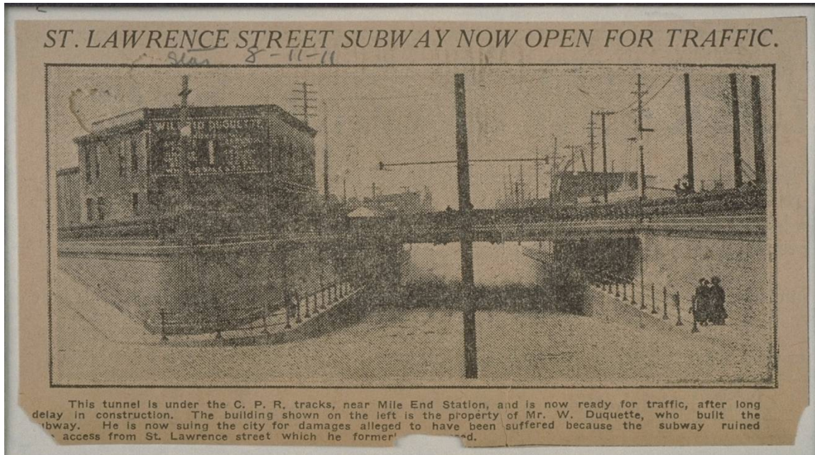
Le lieu avant la démolition de l'immeuble de Duquette et la construction du St. Lawrence Warehousing. Source : The Montreal Star, 8 novembre 1911, collection des albums de rues Massicotte de Bibliothèque et Archives nationales du Québec.
