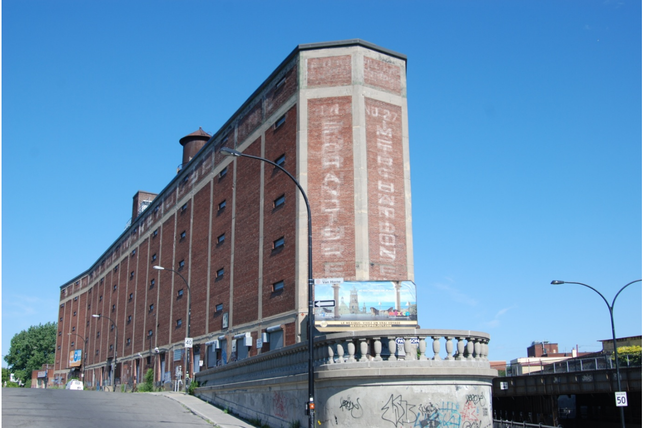
Façades est et sud, juin 2012.
