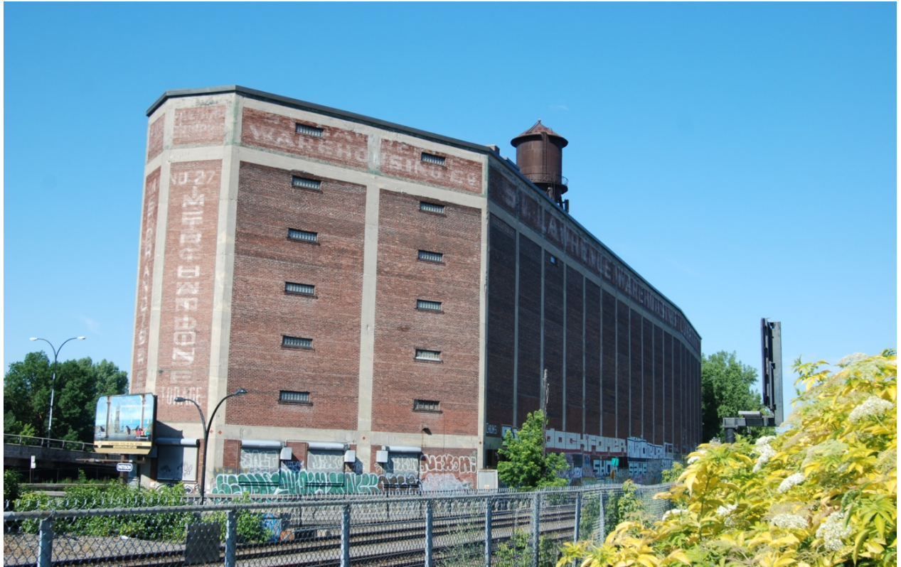
Façades est et nord, juin 2012.
