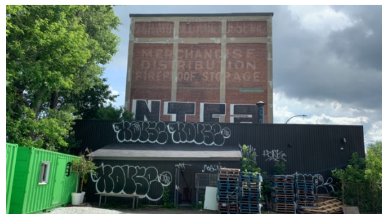
Façade Ouest du 55, av. Van Horne, juin 2022.
