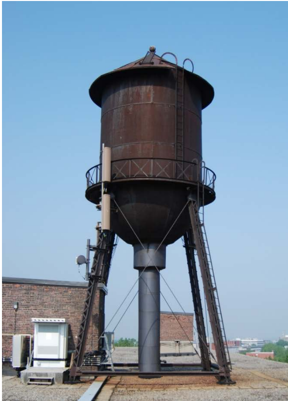
Château d'eau du St. Lawrence Warehousing, juin 2012.
