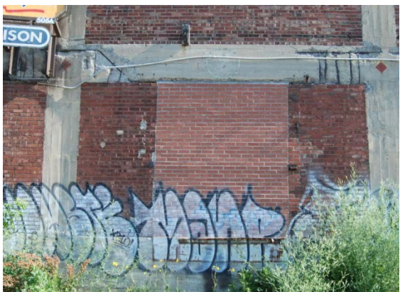
Porte de quai obturée de la façade sud, juin 2012.
