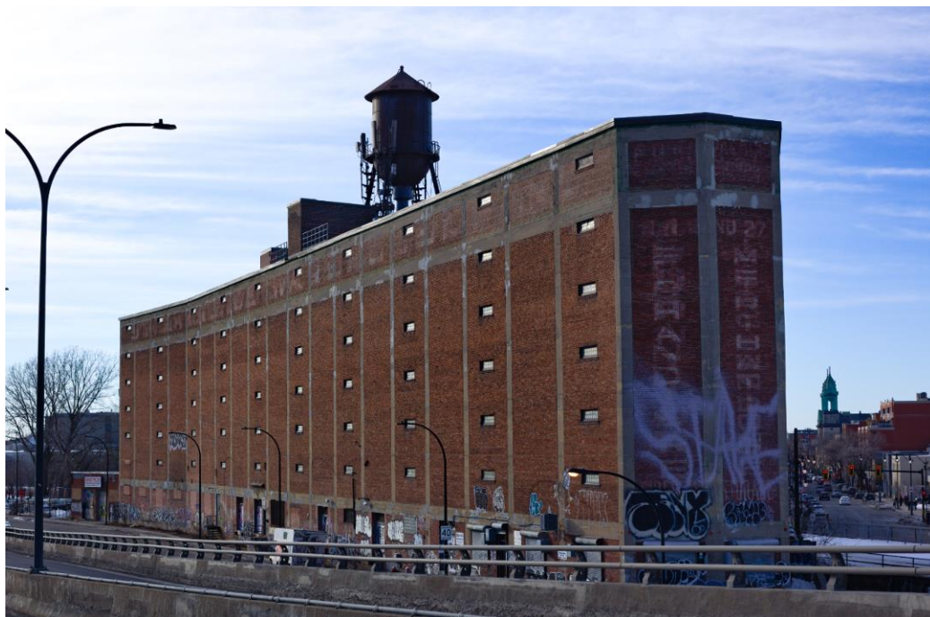
Le bâtiment situé au 1, avenue Van Horne (source : JBouchez, Wikimedia)
