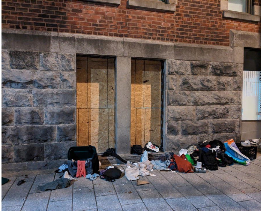
Derrière le cpe, endroit insalubre
