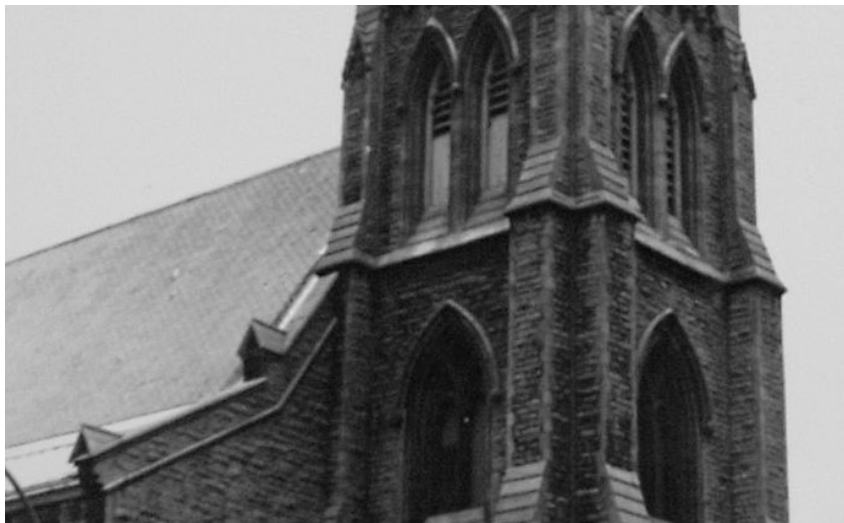
Photo illustrant la toiture recouverte de tuiles en fibro-ciment, 1975. Archives de la CUM.
