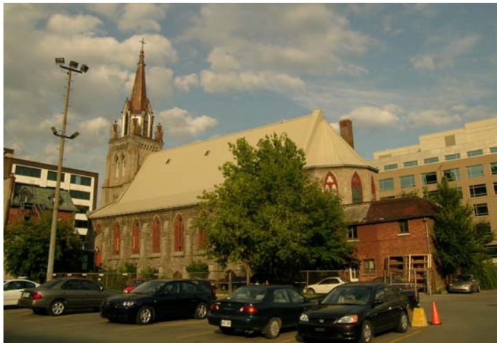
Recouvrement de toiture actuel, 2004.
