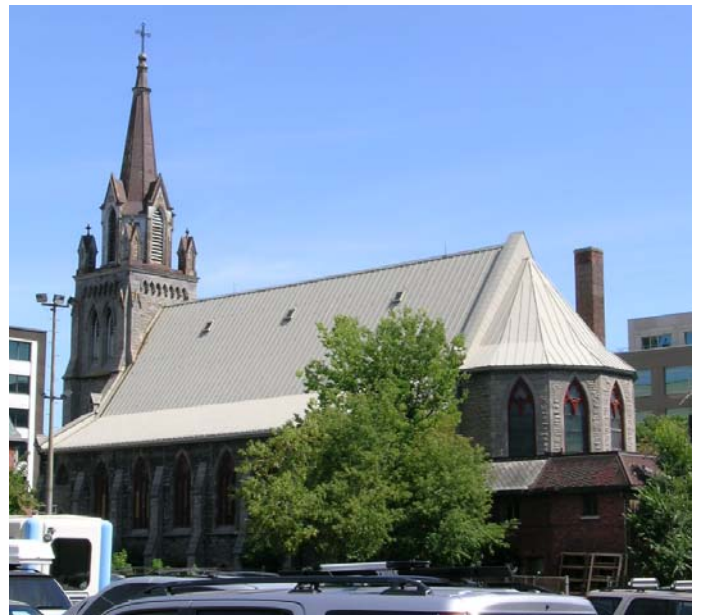
Toiture en tôle (2004).
