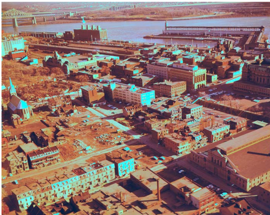
Photographie de 1965 illustrant le début des démolitions liées à la construction du métro. Fonds Armour Landry, ANQ.
