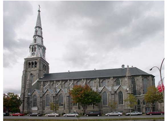
Église Saint-Pierre-Apôtre, 1851-53, Victor Bourgeau architecte (2004).
