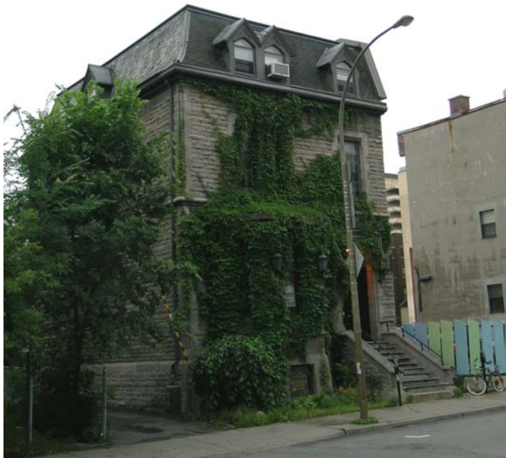
Façade de la maison Garth (2004).
