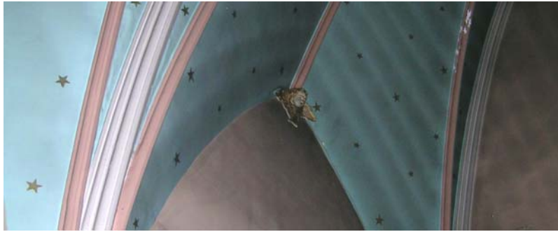
Angelot de plâtre inséré à l'arête d'une voûte, 2004
