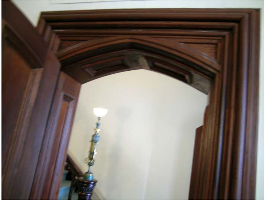
Détail d'un cadre de porte au rez-de-chaussée (2004).
