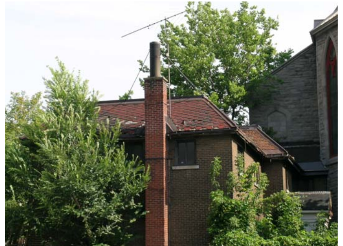
Façade ouest du presbytère, 2004
