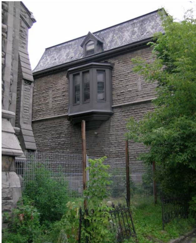
Façade latérale de la maison Garth (2004).
