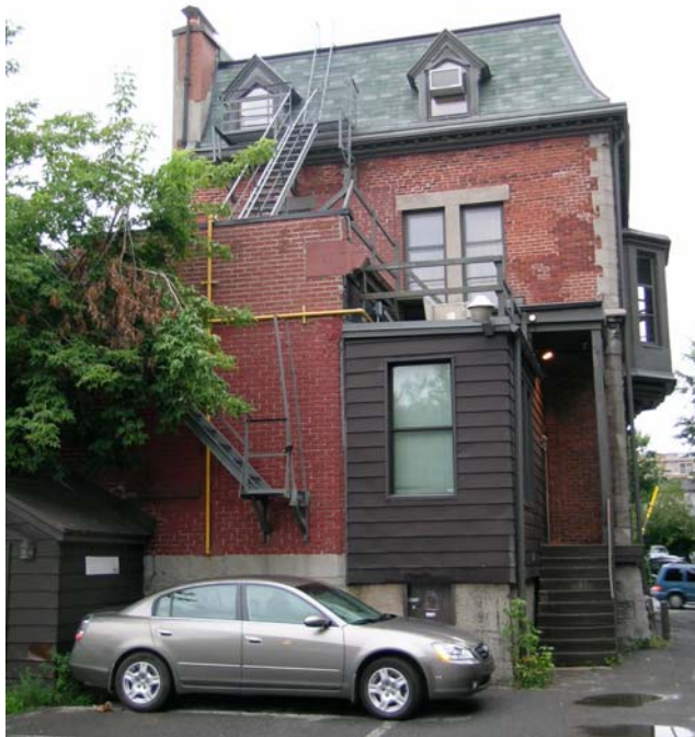
Façade arrière montrant le volume de briques original et l'ajout en clin d'aluminium (2004).
