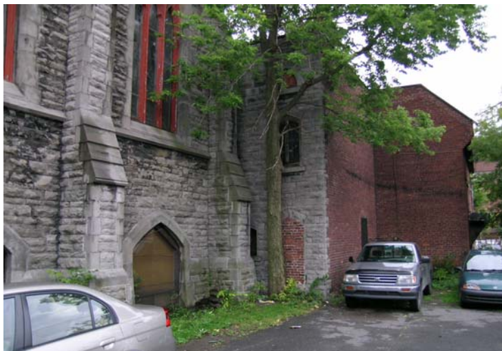
Façades nord et est du presbytère (2004).
