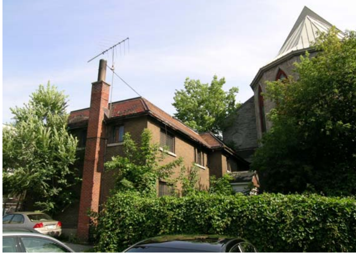
Façades sud et ouest du presbytère (2004).
