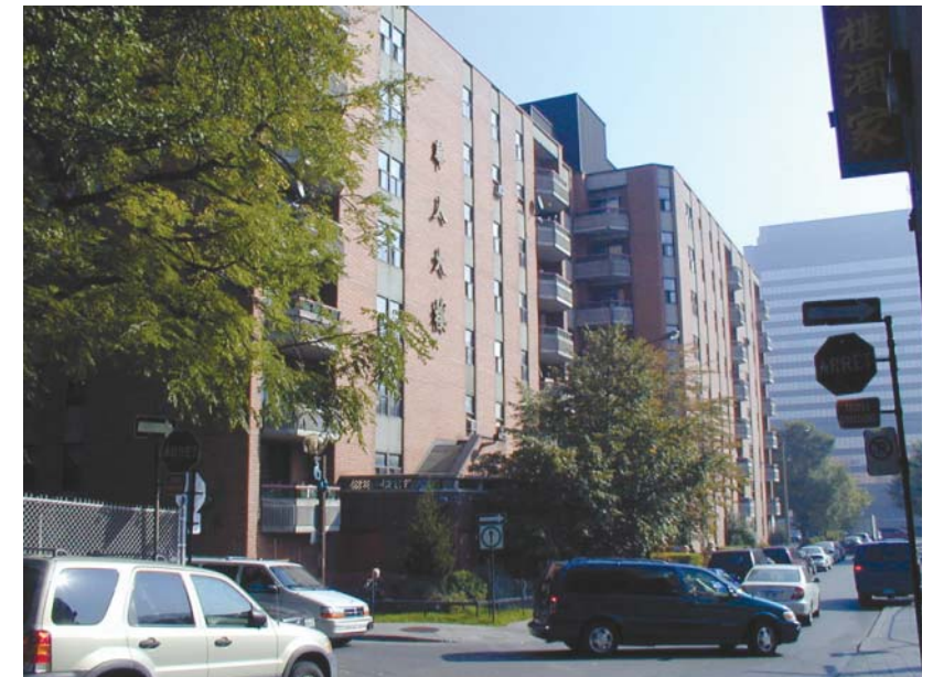
Rue St-Dominique Immeuble d'habitation / 8 étages
