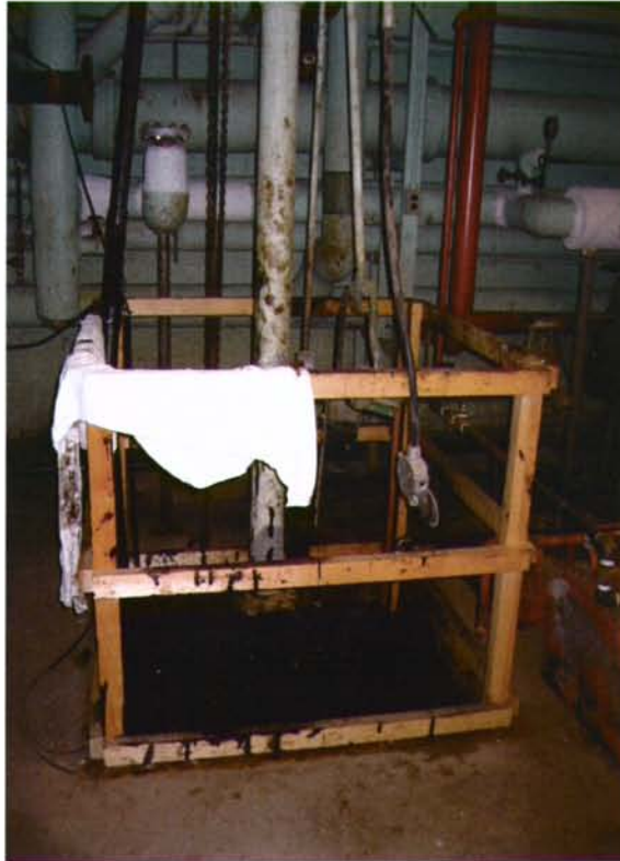
Photo 3: Hôpital Saint-Luc – Buanderie : fosse de récupération d'un mélange d'eau et d'huiles usées dans le sous-sol du bâtiment
