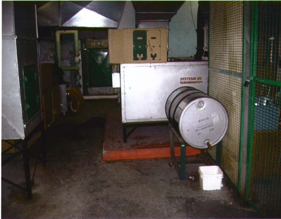
Photo 7: Hôpital Saint-Luc - Centrale thermique : réservoir de produits pétroliers avec traces d'huiles au sol en arrière-plan
