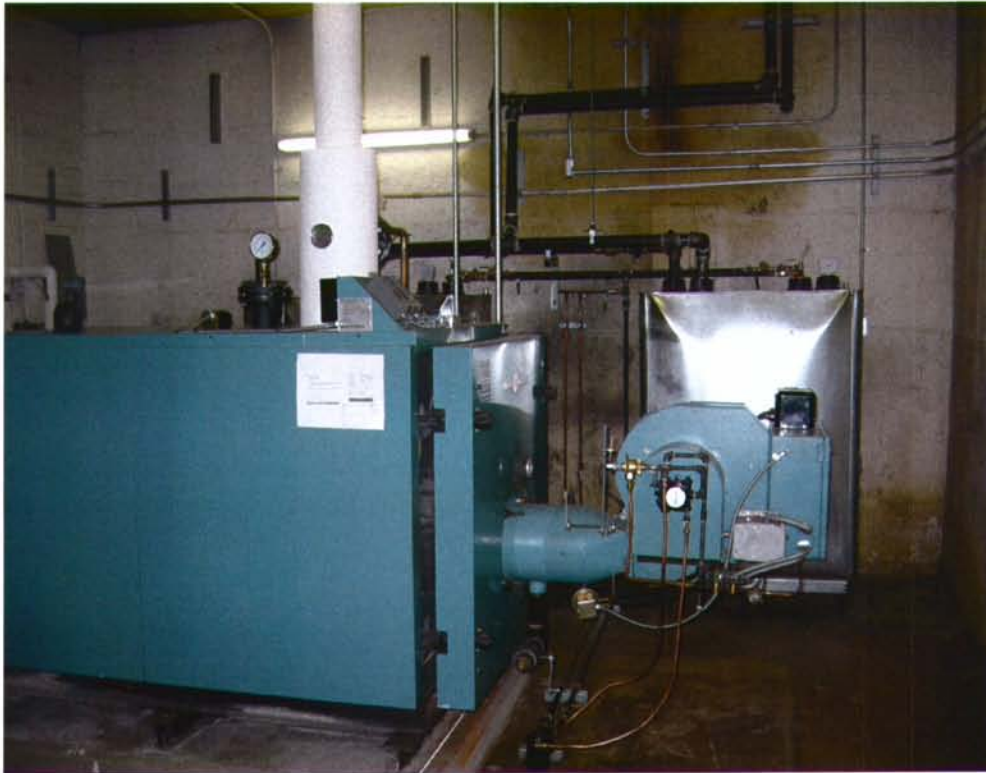
Photo 9: Hôpital Saint-Luc - 1001 Saint-Denis : réservoir hors-sol de 1 000 L alimentant la fournaise du bâtiment
