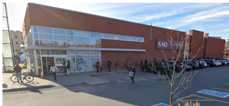
Figure 3 – Photographies des bâtiments existants
