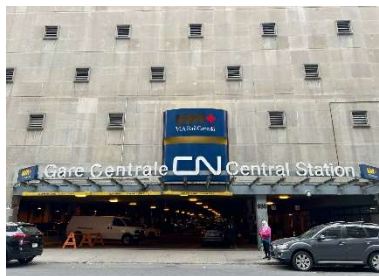
Photo – Entrée de la Gare sur de la Gauchetière
