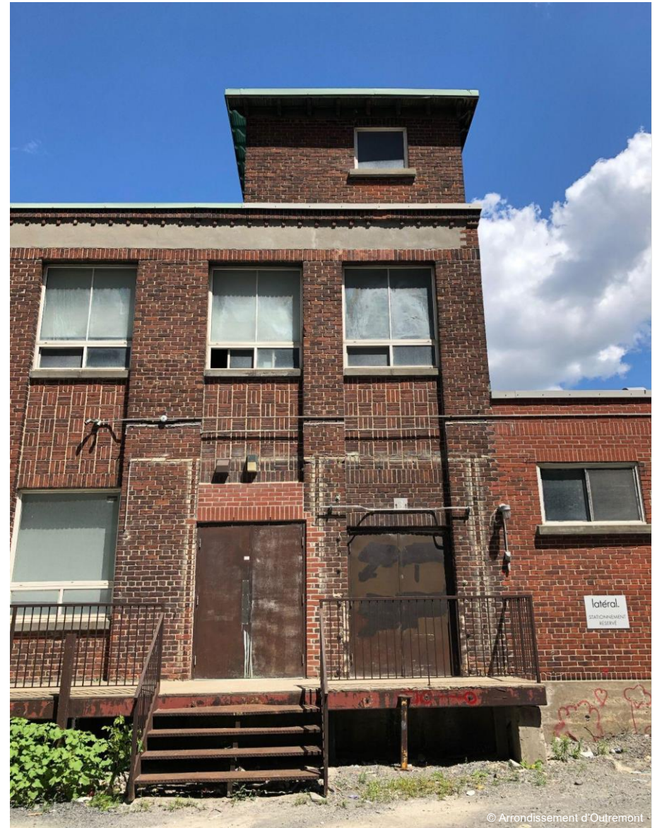
Photo 4-12 Façade du 6600, rue Hutchison – Arrondissement d'Outremont
