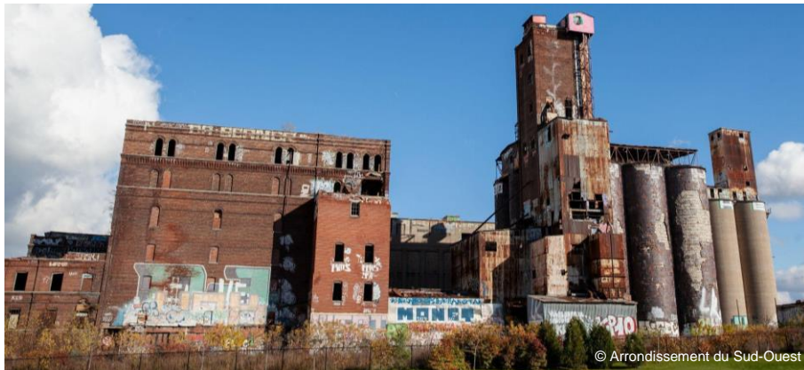
Photo 4-5 Vue sur les bâtiments de la compagnie Canada Malting située au 5022, rue Saint-Ambroise Arrondissement du Sud-Ouest
