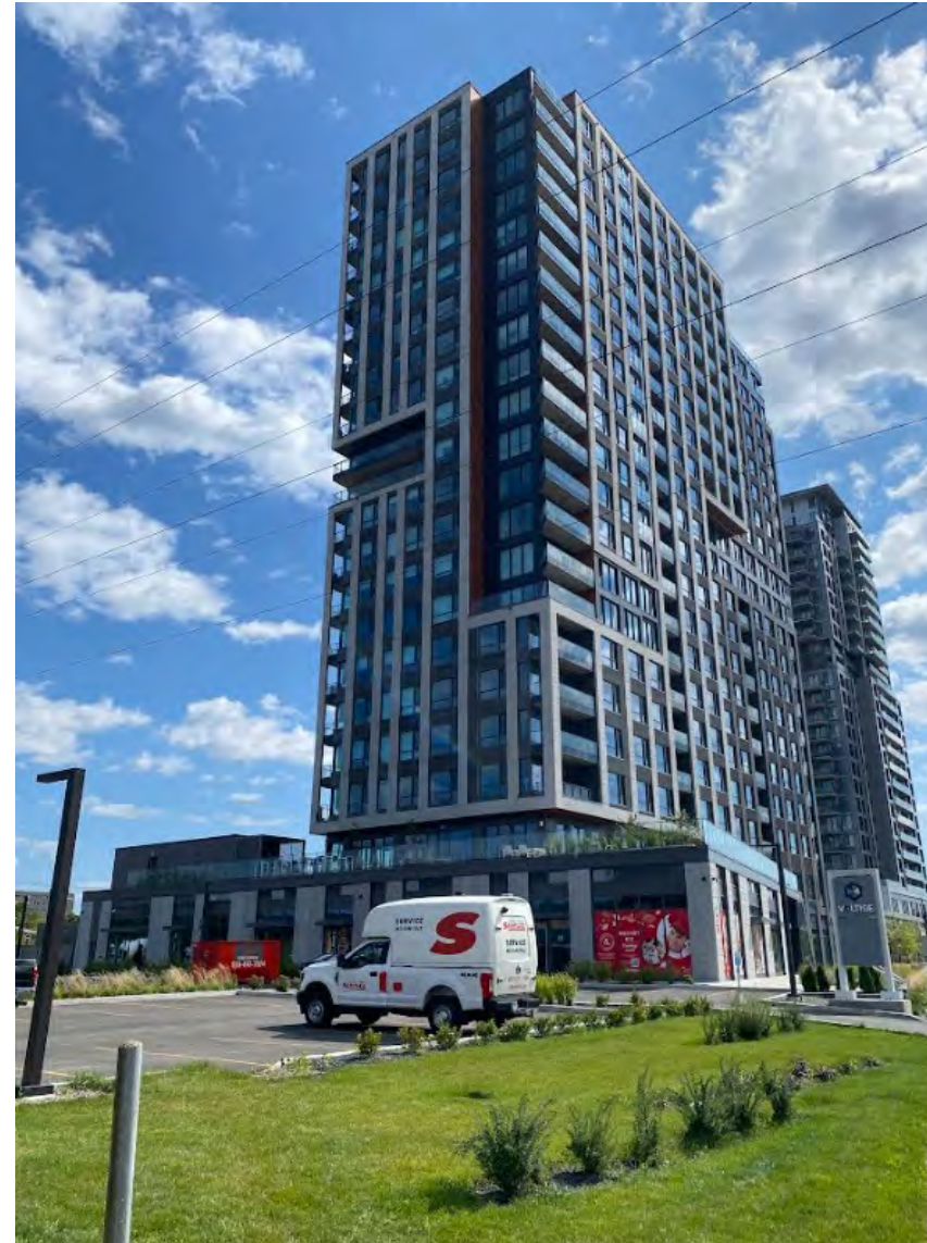
Image 13. Tour Voltige (2020, rue Sauvé Ouest)
