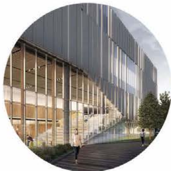
École secondaire LaSalle - en construction (Lemay / Vincent Leclerc / Leclerc architectes)
