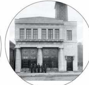
Caserne de pompiers No. 21 (Archives de Ville de Montréal)
