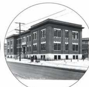
Édifice administratif CN sur rue Bridge en 1932 (www.lapointe.ca, gracieuseté de Roger Agness)
