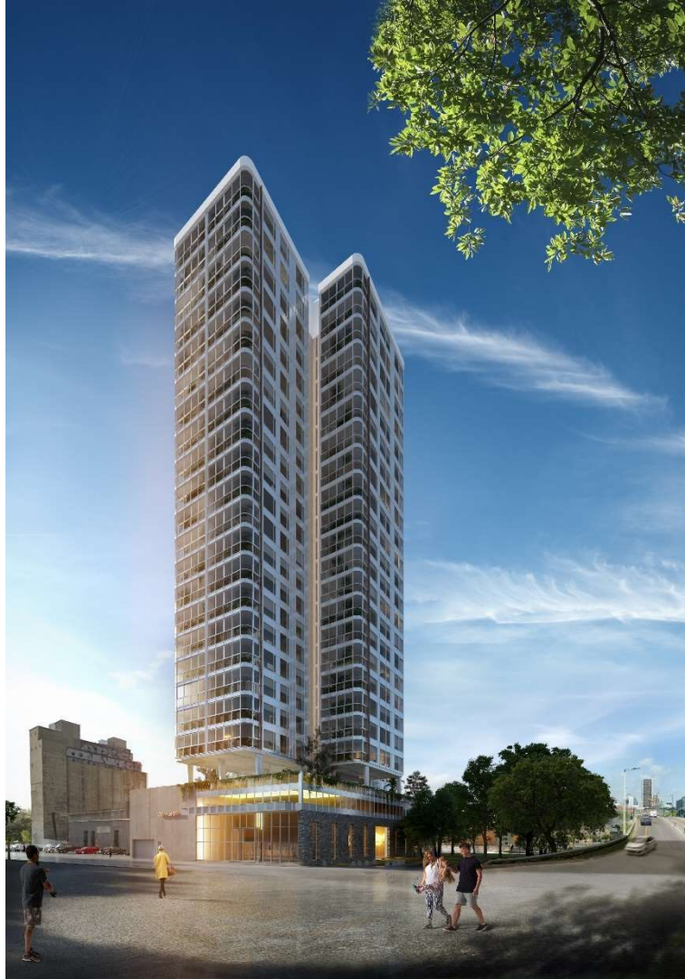
785 Mill – Image Neuf architectes
