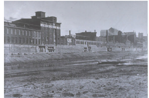
Front bâti continu de la pointe du Moulin et pertuis (prises d'eau) dans le canal à sec pour fins d'inspection et d'entretien, 1910. Parcs Canada dans Répertoire du patrimoine culturel.
