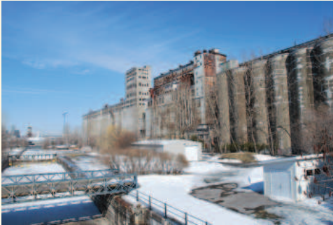
L'ensemble formé par les trois parties du silo n° 5 et le canal de Lachine. Photo : Ville de Montréal, 2020
