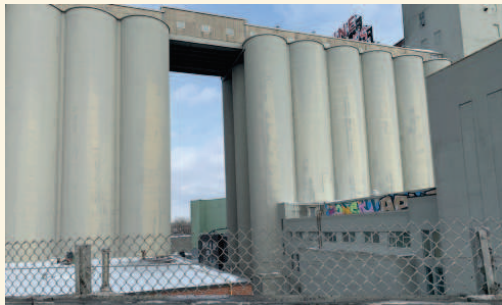
La massivité des silos de béton. Photo : Fahey et Associés, 2020
