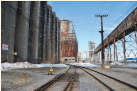
Plusieurs composantes fonctionnelles : les tours marines, les convoyeurs, les silos et les voies ferrées. Photo : Ville de Montréal, 2020
