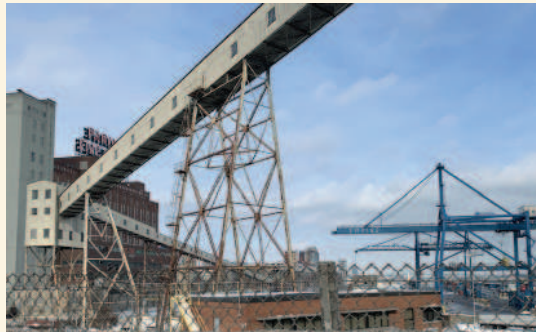
Les diagonales légères et aériennes des équipements du port et des convoyeurs. Photo : Fahey et Associés, 2020
