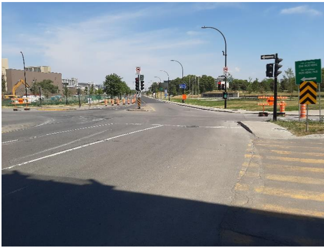
Photo 2-1 Transverse piétonne non protégée à l'angle de l'avenue Pierre-Dupuy et du chemin des Moulins
