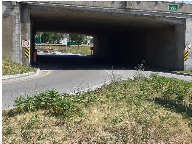
Photo 2-2 Traverse existante sous l'autoroute Bonaventure, interdite aux piétons
