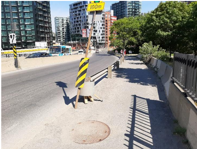
Photo 2-20 Fin des trottoirs, à la sortie nord du pont Wellington
