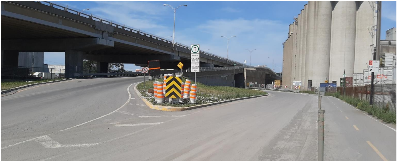
Photo 2-8 Bretelle d'accès à l'autoroute Bonaventure réservée aux autobus en période de pointe du matin
