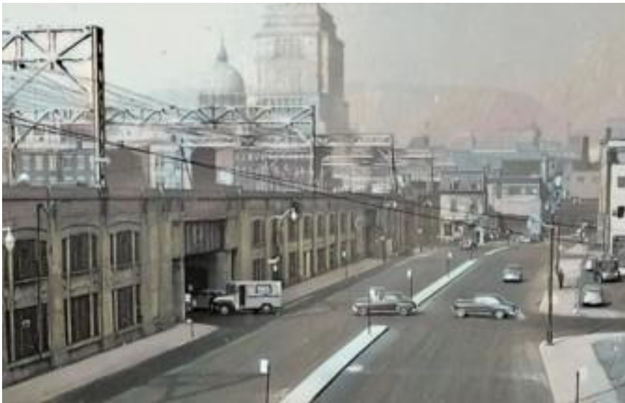
Le bâtiment-pont ferroviaire du CN en octobre 1953 source : AVM. VM94-2513-24
