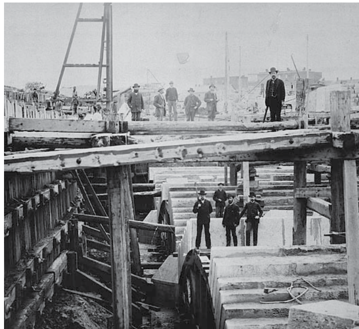
(ci-haut) Construction des bassins NO3 et NO4 de Saint-Gabriel.
