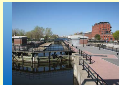
Le mécanisme d'éclusage et l'utilisation du sol adjacent ont été réhabilités.
