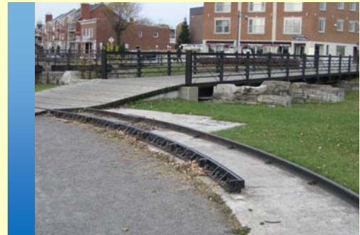
Les vestiges du mécanisme de tournage de pont à l'écluse 5 sont intégrés à l'espace.
