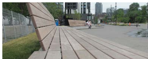
Promenade Smith | banc en béton préfabriqué avec assise en bois et dossiers ponctuels
