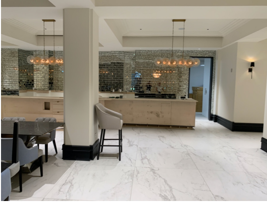
Le futur restaurant du 2 e étage, le 15 juillet 2022.
