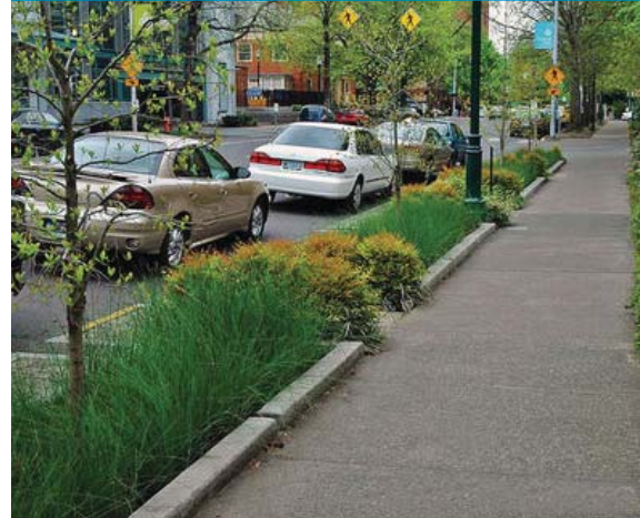
8 - Traitement de rue/ jardin de pluie
