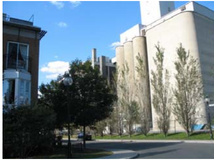
Condo de 3 étages sur l'ancien site de la Stelco (Petite-Bourgogne). À droite l'imposante structure de la Robin Hood.
