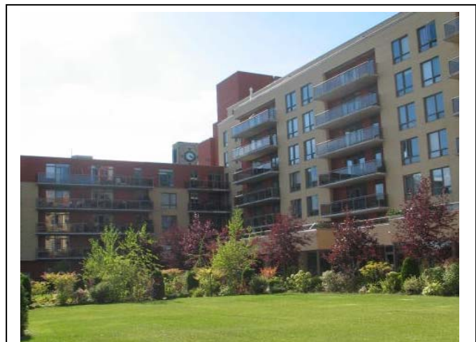
La façade de ce bâtiment de 8 étages près du marché Atwater est largement dégagé jusqu'au Canal-de-Lachine. Derrière un autre dégagement sur rue existe et un parc public est situé immédiatement à l'Est du bâtiment. Les façades vers le marché Atwater sont de 5 étages.
