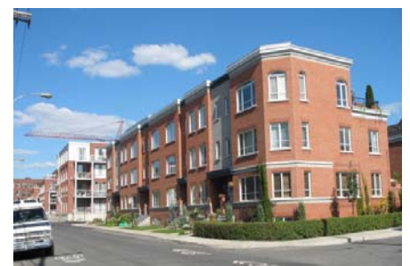
Bâtiments d'habitation de 3 et 4 étages donnant sur la rue Saint-Ambroise vers l'intérieur du quartier Saint-Henri.
