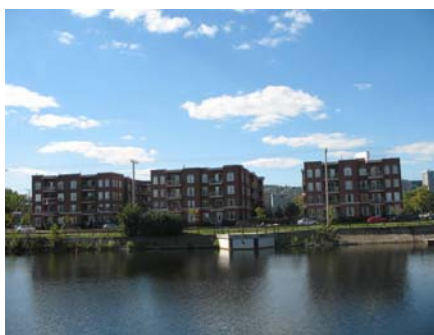
Bâtiments d'habitation nouvellement construits de 4 étages, situés rue Saint-Ambroise, directement à l'ouest du marché Atwater, à Saint-Henri.
