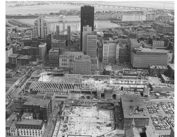
Fig. 29 Construction of Palais des Congrès in 1981 (Source: Bibliothèque et Archives Nationales du Québec)
