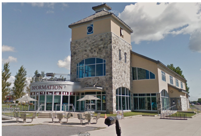
Photo du bâtiment de l'écluse no 5 (fermé)
