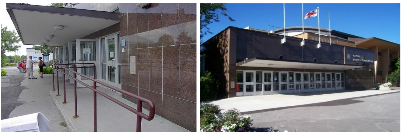
Image 2 – L'entrée principale du centre Pierre-Charbonneau rénovée dans l'esprit du design universel : toutes les portes sont accessibles à tous, simultanément.
