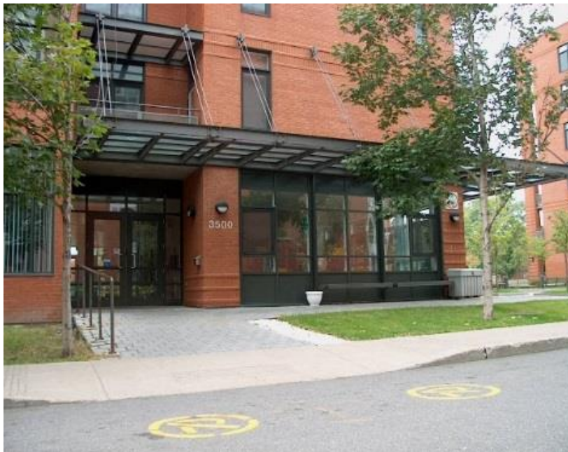
Image 4– Entrée de plain-pied et parcours piéton accessible et sécuritaire vers un débarcadère
