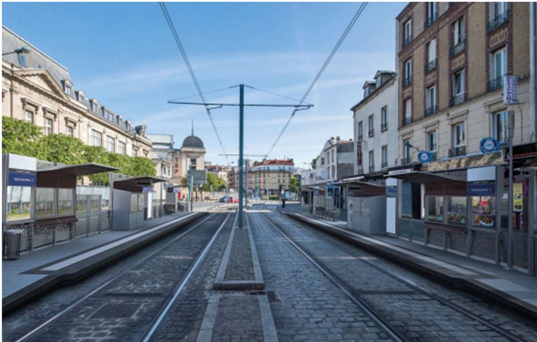
Figure 4- La station Théâtre Gérard Philipe rénovée sur la ligne T1 en Île-de-France, avec le nouveau mobilier et les nouvelles infrastructures. Source : RATP
