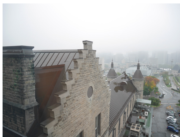
Point haut de la toiture du Pavillon L, 2019 (Source: ERA Architects)
