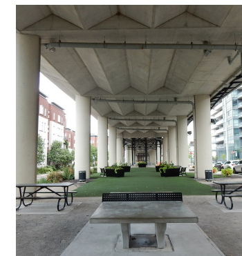
Fig.57.Mise à profit des espaces résiduels, Espace Faubourg Québec, Ville-Marie, Montréal Source: Ville de Montréal
