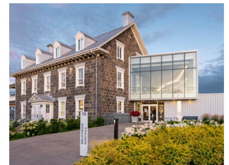
Fig.64._Conversion d'une maison patrimoniale en bibliothèque et extension contemporaine, Montmagny
