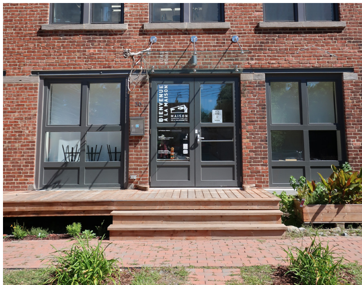
B_5 MIAM : absence de rampe pour accéder à l'entrée principale
