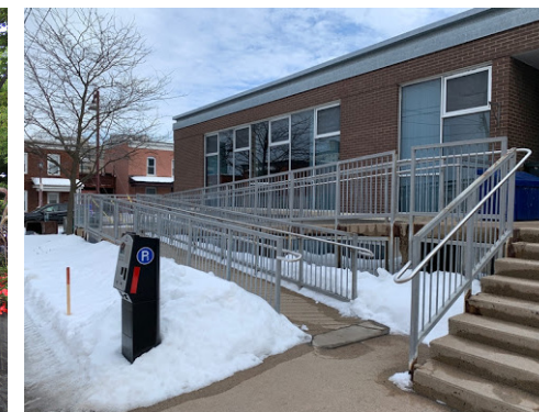
Fig.36. Rampe d'accès, Centre culturel Jacques-Auger Espace René-Provost, Gatineau
