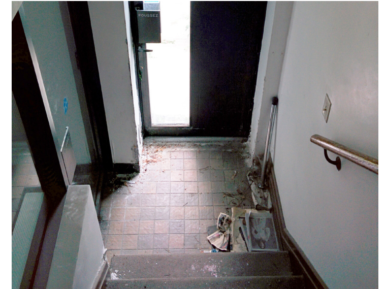
B_4 1311 Saint-Viateur: vestibule de l'entrée principale
