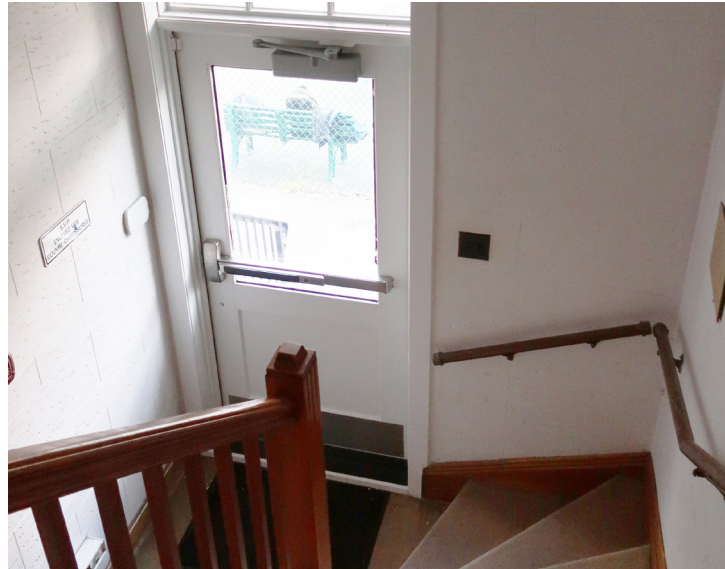
B_1 Maison des jeunes / logement : escalier menant au logement de l'étage
