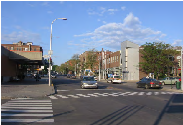
Traverses piétonnières à l'intersection Wiseman / Van Horne (face au métro Outremont)
