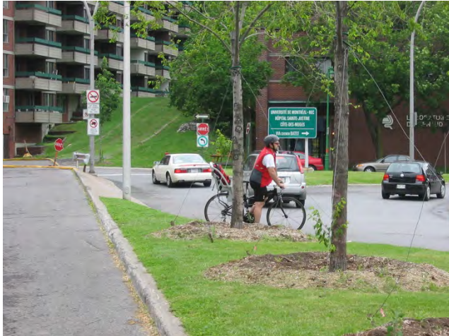
Photo 7 : Traversée d'un cycliste sur l'avenue du Manoir vers le trottoir du viaduc
