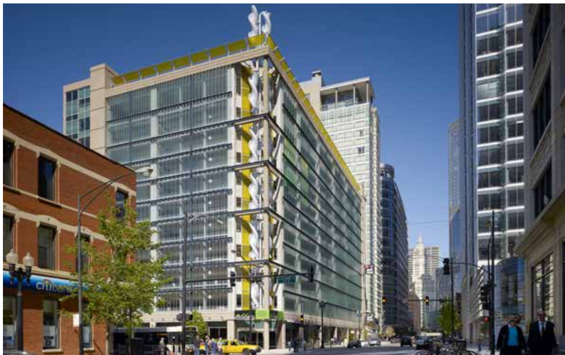
Crédit : Walker Parking Consultants
