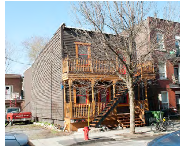
Maison villageoise à toit plat 514 rue St-Philippe
