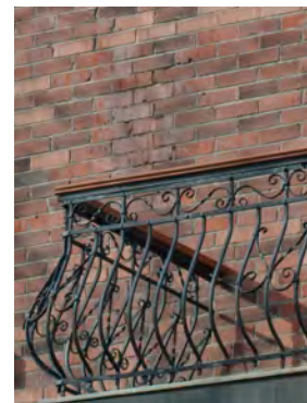
Détail de balcon en métal ornemental
