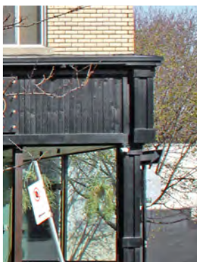
Entablement d'un rez-de-chaussée commercial rue Notre-Dame ouest.
