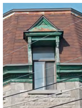
Détail de corniche et toiture à fausse mansarde
