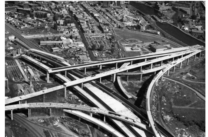
Construction de l'échangeur Turcot (1966) source : Archives de Montréal - VM94-B029-001
