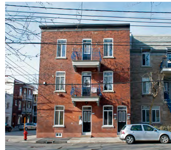
Triplex avec escalier intérieur 200 rue St-Ferdinand
