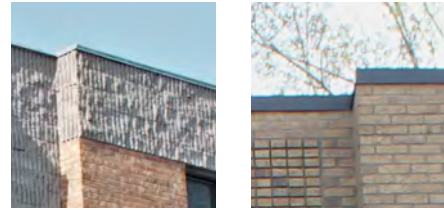
Un petit parapet de maçonnerie qui se termine par un mince solin de métal compose le couronnement
