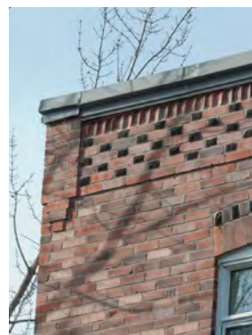
Détail de corniche avec appareillage de maçonnerie
