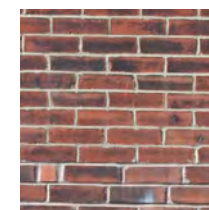
Corps avec parement de brique d'argile de couleur variable avec joint de mortier de couleur similaire et assez épais (6mm). Occasionnellement, certains bâtiments ont un corps avec parement de pierre.
