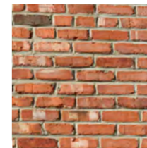
Corps avec parement de brique d'argile de couleur variable avec joint de mortier de couleur similaire et assez épais (6mm). Occasionnellement, certains bâtiments ont un corps avec parement de pierre.
