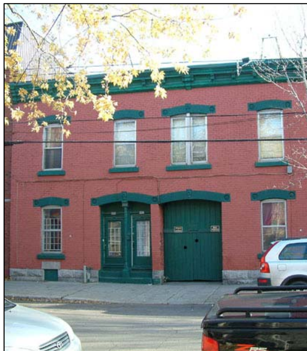
Fig. 2.1.4 : Variante 2 : Duplex jumelé avec porte cochère centrale, situé au 2628-2636, rue Saint-Charles, entre les rues Charlevoix et D'Argenson. SO2497.
