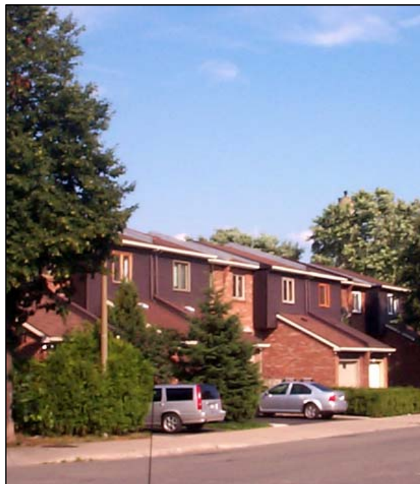
Fig. 1.5.2 : Maisons de ville situées sur la rue Vinet, entre l'avenue Lionel-Groulx et la rue Workman. SO0227.
