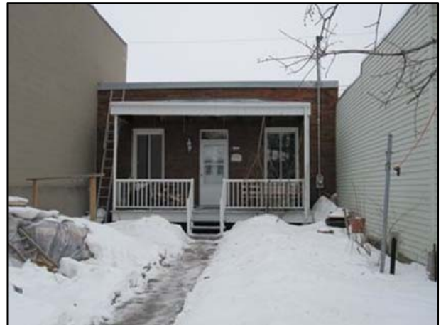
Maison implantée en fond de parcelle et bénéficiant d'une cour avant profonde. UP3.16_Dumas_6599
