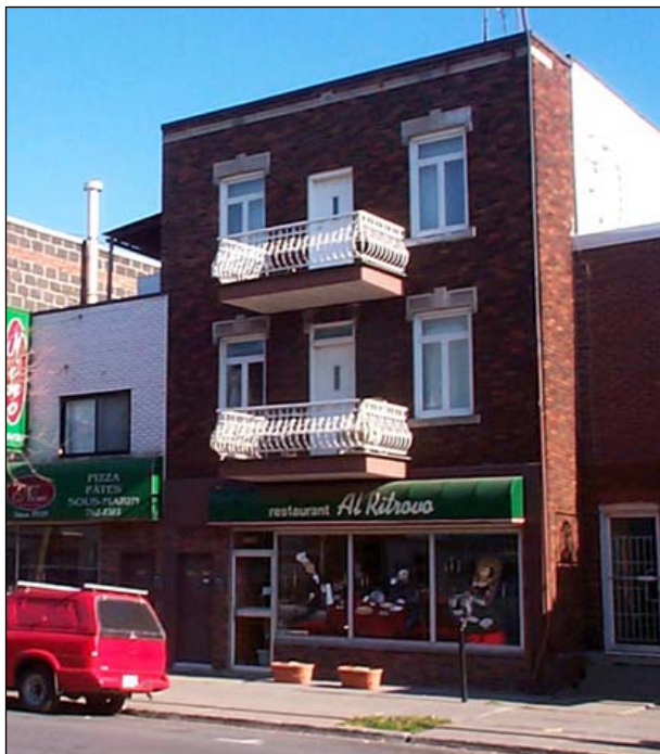
Figure 4.1.3 : Immeuble à vocation mixte situé sur le boulevard Monk, entre les rues Allard et Springland. SO 3631.
