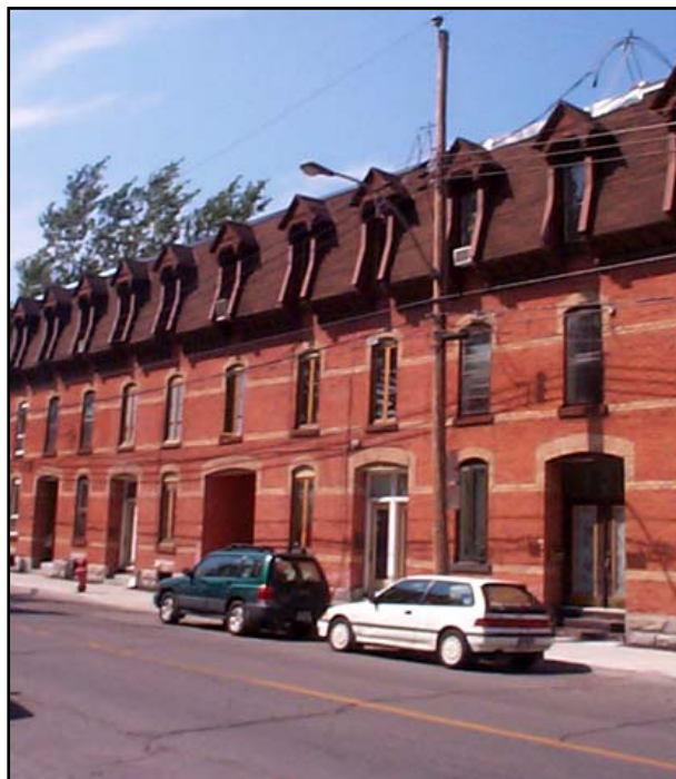
Fig. 2.4.6 : Variante 1, duplex de trois étages avec porte cochère et construits en série, situés sur la rue de la Montagne, entre les rues Ottawa et Wellington. SO0095.
