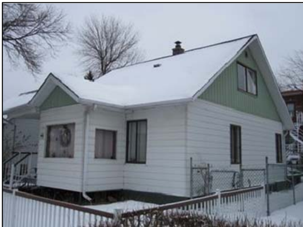
Le pignon est souligné par une couleur différente. UP3.7_Jolicoeur_1466.
