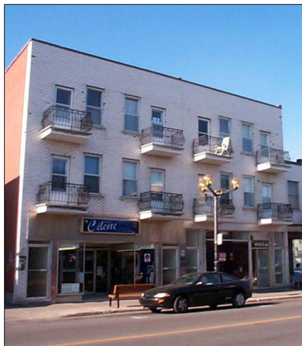
Figure 4.1.4 : Immeuble à vocation mixte situé sur le boulevard Monk, entre les rues Springland et Jolicoeur. SO 3637.
