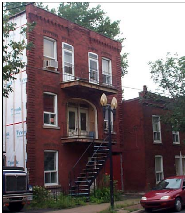
Fig. 2.7.3 : Multiplex avec porche en alcôve au premier étage, situé sur la rue Soulanges, entre les rues du Centre et Grand Trunk. SO0175.
