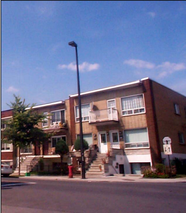
Fig. 2.3.1 : Duplex surélevé avec portes centrales, situé sur la rue Allard, à l'intersection de la rue Lacroix. SO0342.
