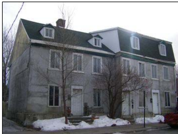
Maison villageoise à 2.5 étages sans galerie avant. Le toit à deux versants est percé par deux lucarnes. UP4.1_Ste-Émilie_3936.
