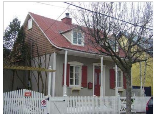
La maison Clermont érigée vers 1870 présente des façades recouvertes de planche et de bardeau de bois ainsi qu'un toit revêtu de tôle. UP4.1_St-Augustin_110.
