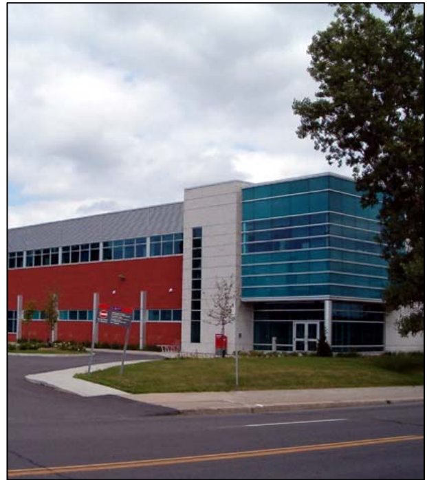
Fig. 6.1.2 : Édifice de Postes Canada, 225, rue Bridge. SO1606.
