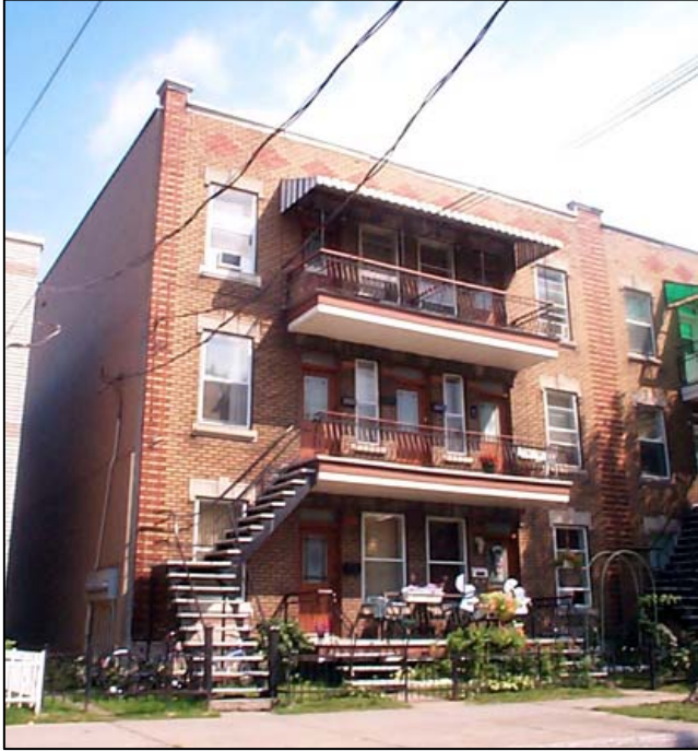
Fig. 9 : Multiplex 6114-6116, rue Hamilton. SO3584.
