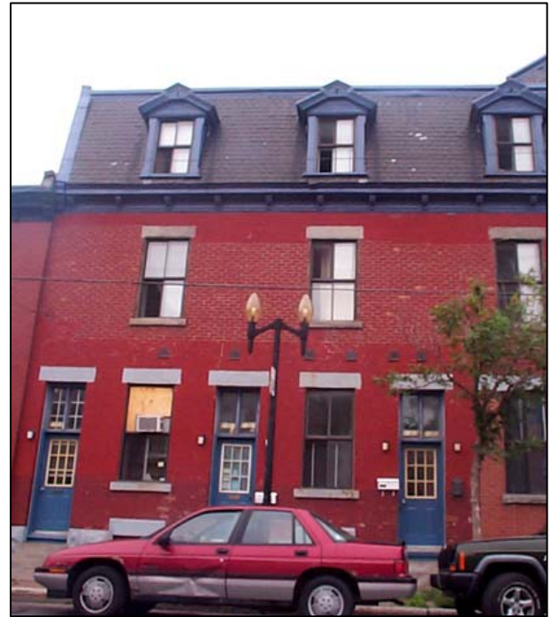
Fig. 2.4.8 : Variante 2, triplex avec toit en fausse mansarde et portes séparées, situé sur la rue Mullins, à l'intersection de la rue Richmond. SO0178.
