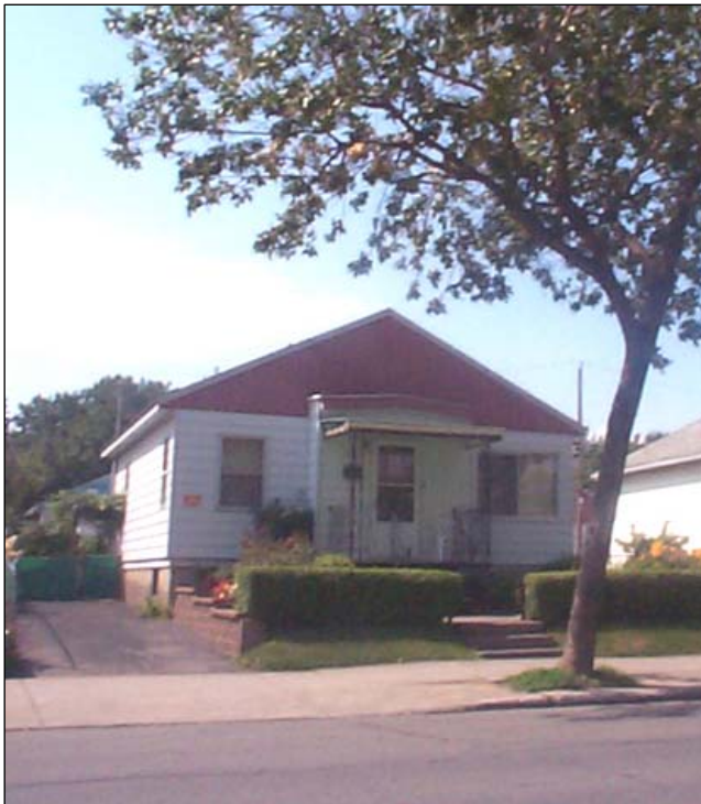
Fig. 12 : Maison de vétérans situé sur le boulevard Monk, entre les rues Raudot et Allard. SO3556.
