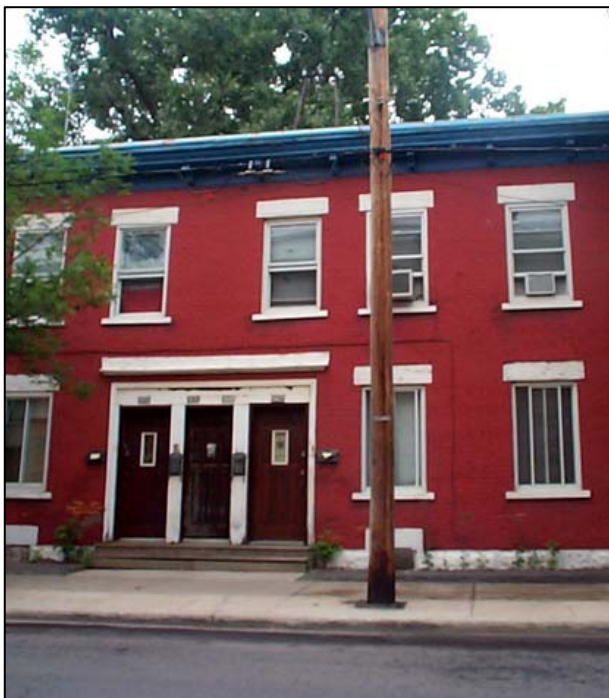
Fig. 2.1.3 : Variante 1 : Duplex avec escalier intérieur de 4 logements dont la façade possède trois portes jumelées. Il est à noter qu'une seule porte donne accès aux deux logements de l'étage. Situé entre les rues Knox et Ryde. SO0191.
