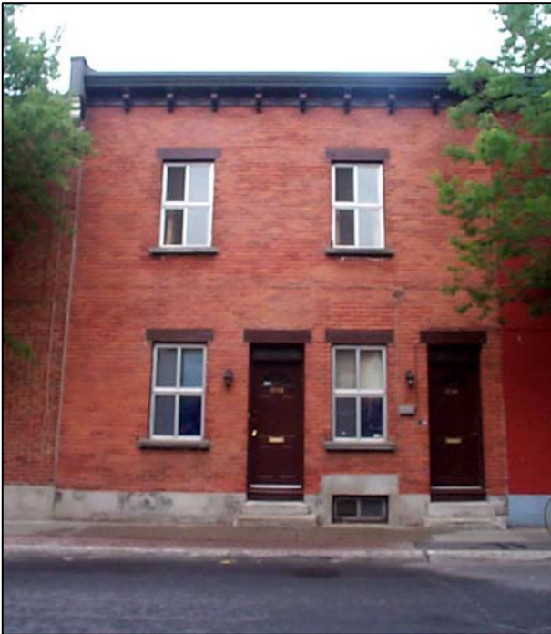
Fig. 2.1.1 : Duplex sans marge de recul, situé sur la rue Grand Trunk, entre les rues Richmond et Shearer. SO0182.
