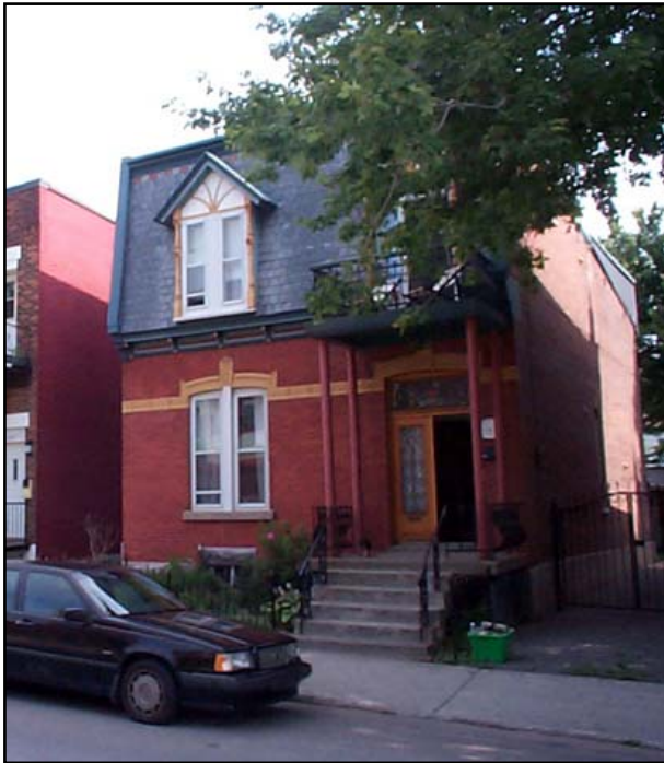
Fig. 1.2.4 : Variante isolée de la maison urbaine, avec balcon, située sur la rue du Couvent entre les rues Saint-Antoine Ouest et Saint-Jacques. SO0010.
