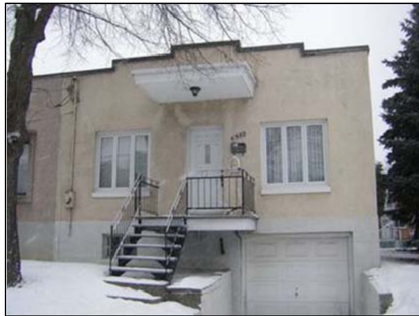
Maison surélevée avec garage au sous-sol. UP3.13_Lamont_6980.
