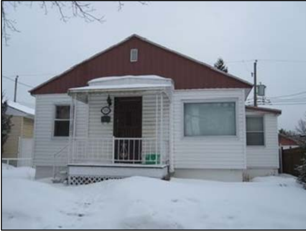
Maison de vétérans typique, au 7034, rue Beaulieu. UP3.10_Beaulieu_7034.
