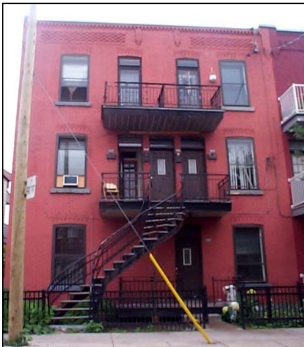
Fig. 2.7.2 : Multiplex situé sur la rue de Rozel, entre les rues Butler et Charlevoix. SO0204.
