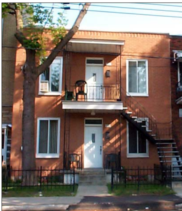
Fig. 8 : Duplex avec escalier extérieur, 1903-1905, rue Springland. SO0266.
