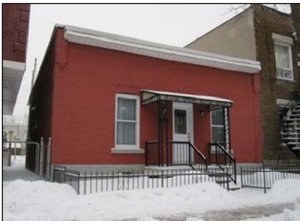
Maison « boomtown » typique située au 5975, rue Hamilton. UP3.12_Hamilton_5975.
