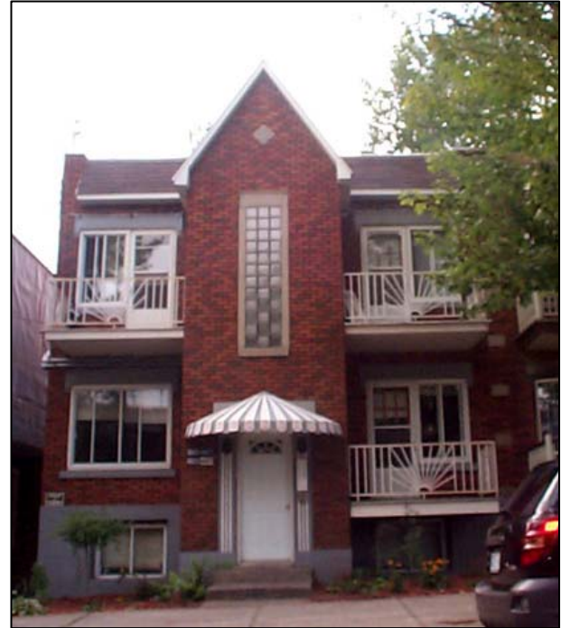
Fig. 3.1.3 : Maison d'appartements avec saillie couronnée d'un pignon, située du côté ouest de la rue Beaulieu, entre les rues Raudot et Allard. SO0374.
