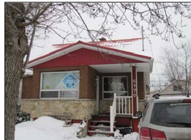
Cette maison présente plusieurs matériaux de parement sur une même façade : brique, tôle et pierre artificielle. UP3.7_Angers_6170.
