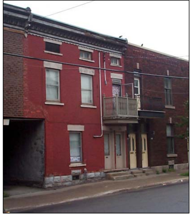
Fig. 3 : Duplex avec escalier intérieur situé sur la rue de Châteauguay, à l'intersection de la rue Roper. SO0148.
