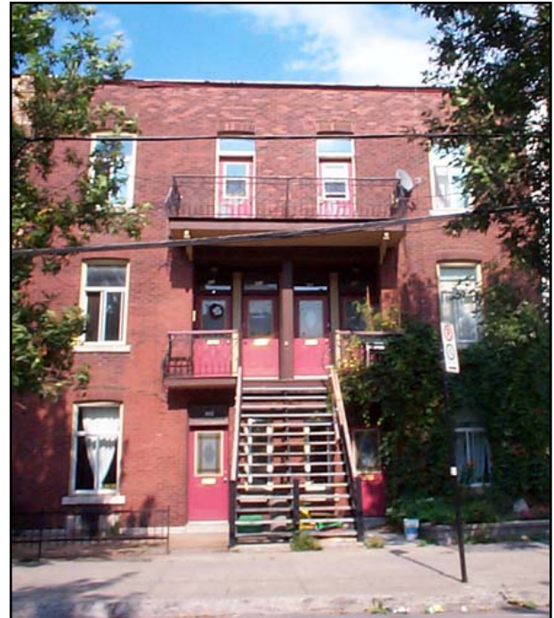
Fig. 2.6.5 : Triplex avec escalier extérieur jumelé, situé du côté est de la rue Desnoyers, à l'intersection de la rue Cazalais. SO0409.
