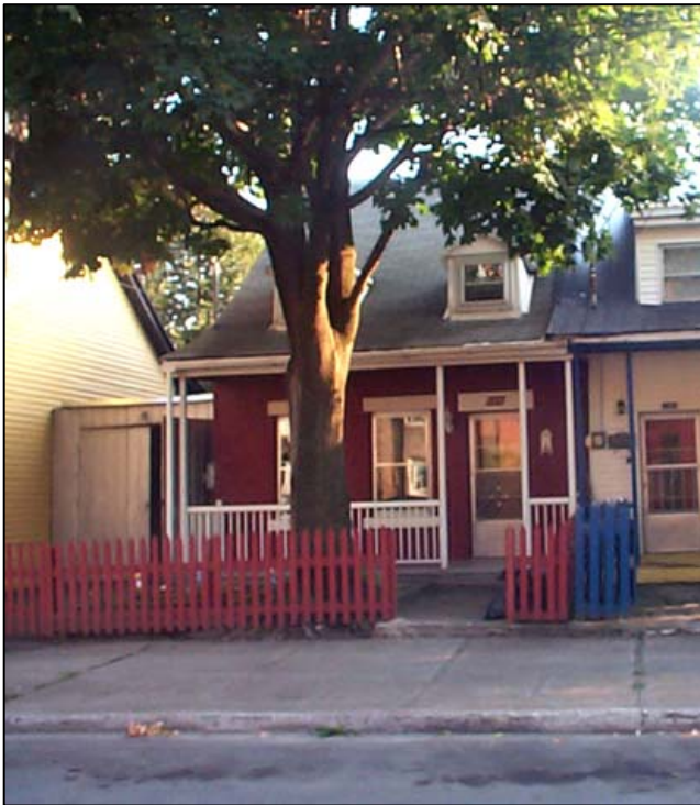
Fig. 4 : Maison villageoise à pignon, située du côté ouest de la rue Turgeon, entre les rues Sainte-Émilie et Saint-Ambroise. SO0129.
