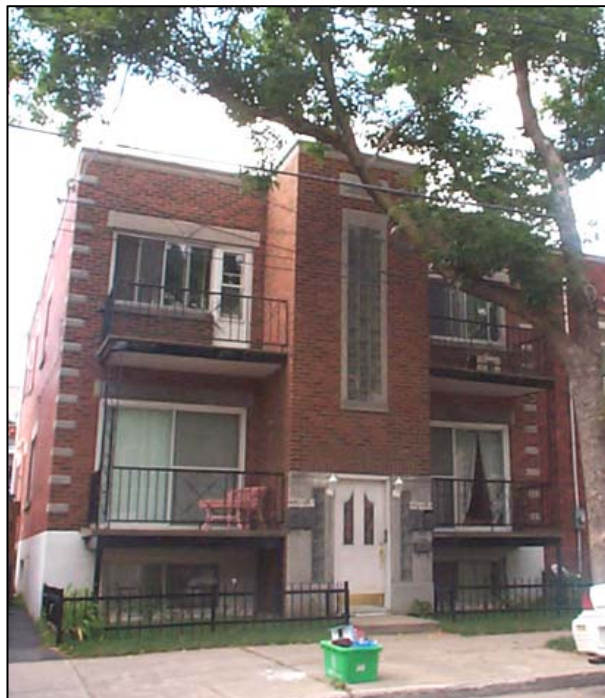
Fig. 3.1.1 : Maison d'appartements située au 6661-6667, rue Hurteau. SO0321.
