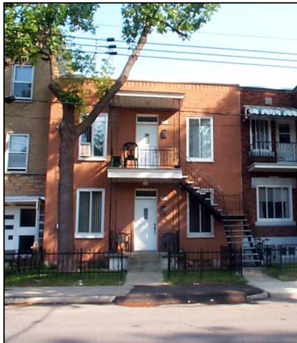
Fig. 2.2.1 : Duplex avec escalier extérieur, 1903-1905, rue Springland. SO0266.
