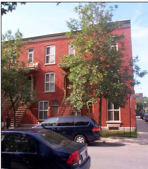
Fig. 2.6.1 : Triplex avec escalier extérieur, situé au 872-880, rue Agnès. SO0003.
