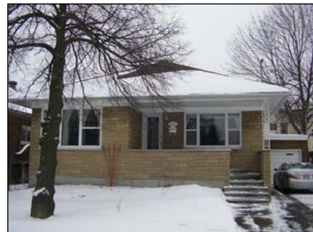
La forme de la maison de vétérans a évolué vers celle du bungalow. UP3.8_Hadley_6945.
