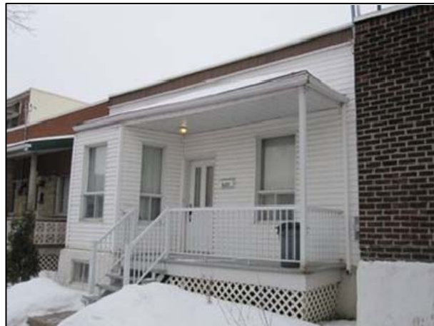
Maison recouverte de vinyle sur la rue Mazarin. UP3.16_Mazarin_6231.
