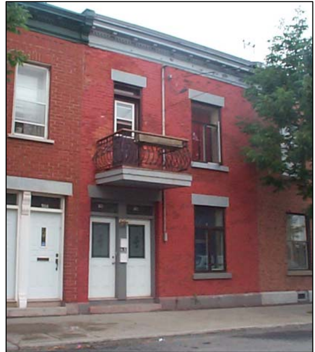
Fig. 2.1.2 : Duplex sans marge de recul, situé sur la rue de Liverpool, entre les rues de Paris et de Coleraine. SO0216.
