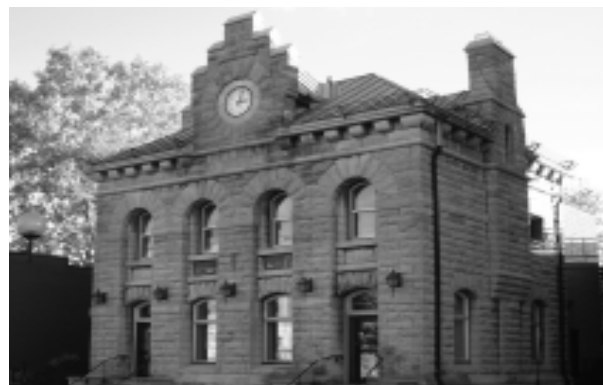
22.1.9 Le bureau de poste. Photographie : Denys Tremblay
