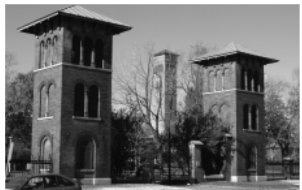
22.E.9 L'aqueduc de Montréal. Photographie : Denys Tremblay
