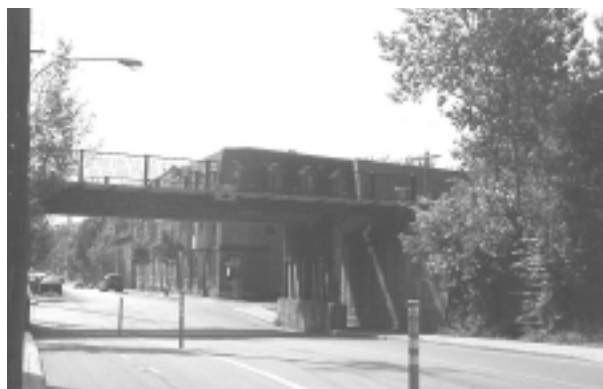
22.I.21 Pont ferroviaire, rue Charlevoix
