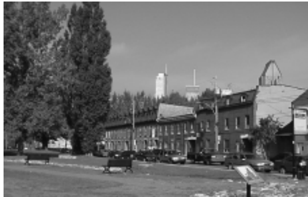
22.E.2 Les fondations de l'église Sainte-Anne dans le square du même nom, face à l'ensemble de bâtiments résidentiels de la rue de la Montagne. Photographie : Denys Tremblay
