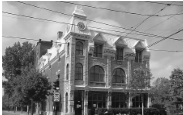
22.E.11 Le poste d'incendie n° 23 sur la rue Hibernia
