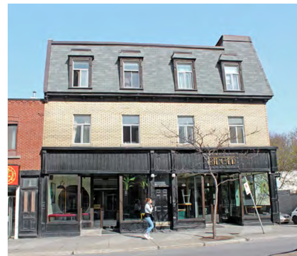
Triplex mixte avec rez-de-chaussée commercial 4003 rue Notre-Dame Ouest
