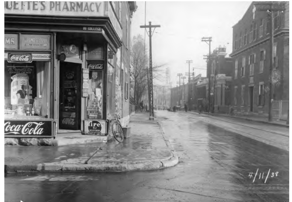
Rue St-Antoine et du Collège (1938) source : archives de la Ville de Montréal VM166-R3082-2-2344-4566O
