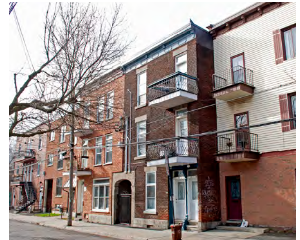
Triplex avec porte cochère 316 rue St-Ferdinand
