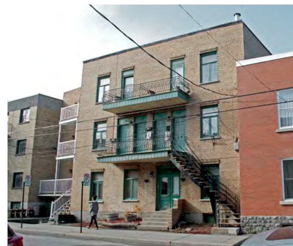
Multiplex 110 rue St-Philippe
