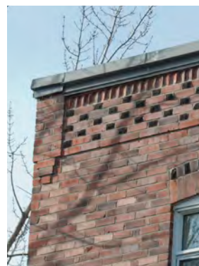
Détail de corniche avec appareillage de maçonnerie
