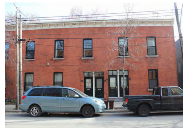
Duplex avec escalier intérieur 101 rue Turgeon
