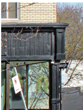
Entablement d'un rez-de-chaussée commercial rue Notre-Dame ouest.
