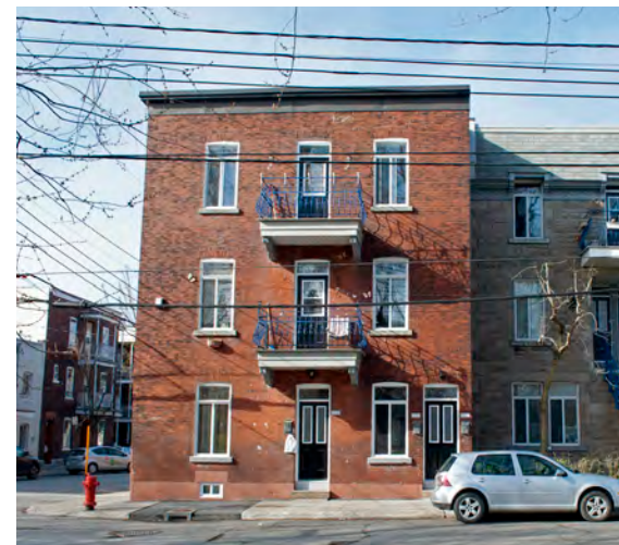
Triplex avec escalier intérieur 200 rue St-Ferdinand
