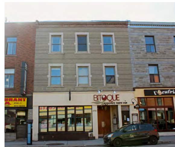
Triplex mixte avec rez-de-chaussée commercial 3706 rue Notre-Dame
