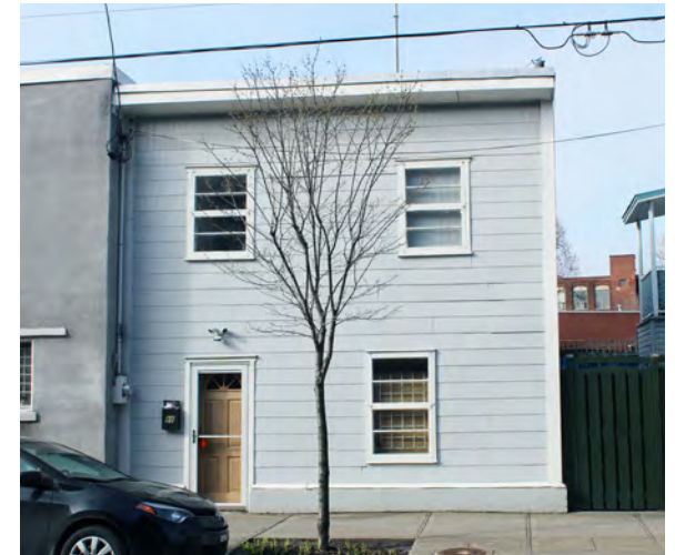
Maison villageoise à toit plat 88 rue St-Augustin
