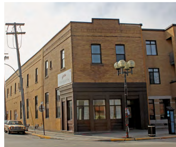
Duplex mixte avec rez-de-chaussée commercial 3900 rue Notre-Dame Ouest
