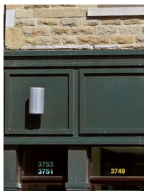
Entablement d'un rez-de-chaussée commercial
