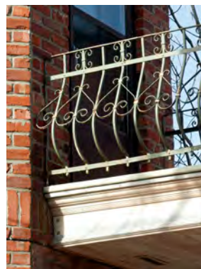
Garde-corps en acier et détails de fascia en bois avec plusieurs moulures.
