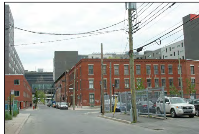
375-399, rue de la Montagne et 1288-1290, rue Barré Mai 2013
