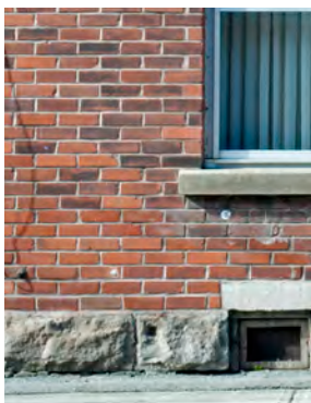
Socle en pierres à bossage avec soupiraux pour la ventilation du vide sanitaire
