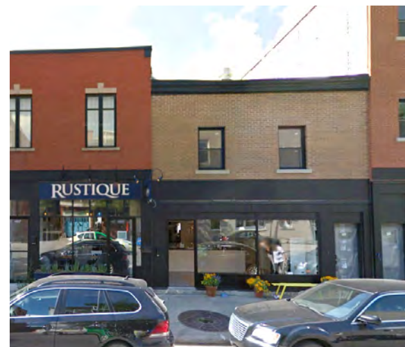
Duplex mixte avec rez-de-chaussée commercial 4615 rue Notre-Dame Ouest
