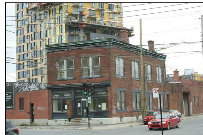
Ancienne Oka Sand and Gravel, 248, rue de la Montagne Mai 2013
