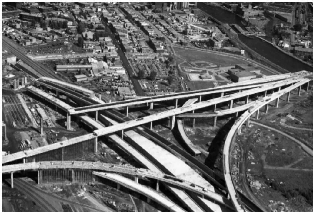
Figure 11: Construction de l'échangeur Turcot. 1967. © BAnQ
