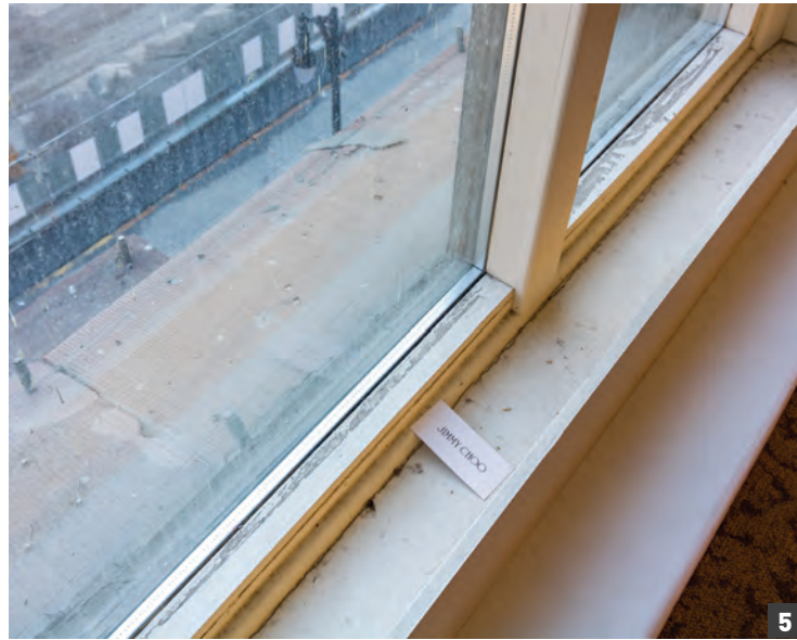
Détail de joint de la fenêtre (verre original remplacé par un thermos)
