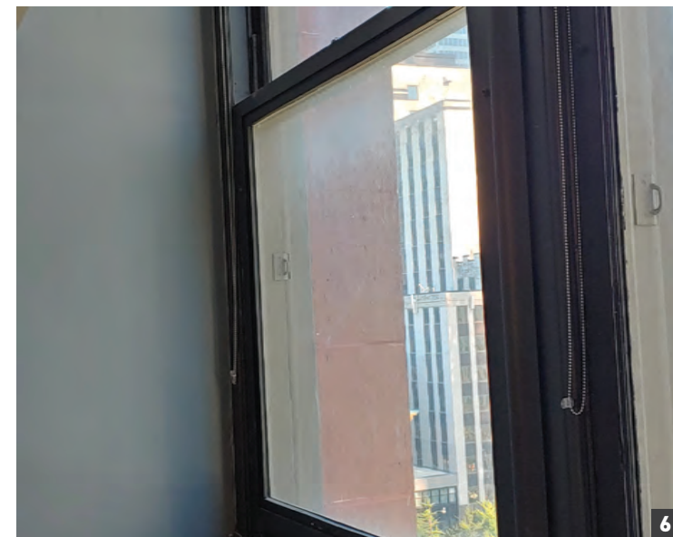
Détails de fenêtres
