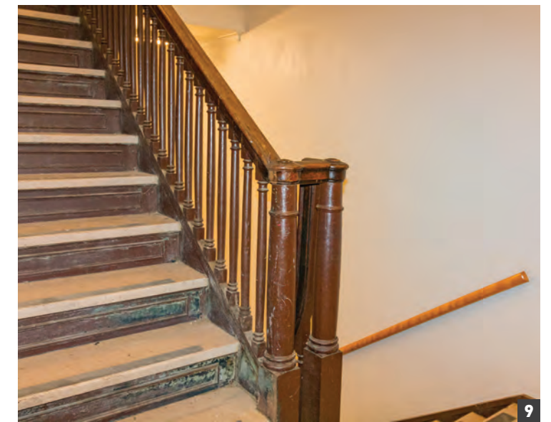
Détail d'escalier en bois
