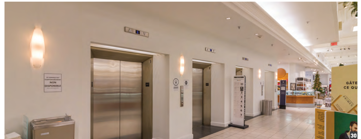
Ascenseurs du RDC
