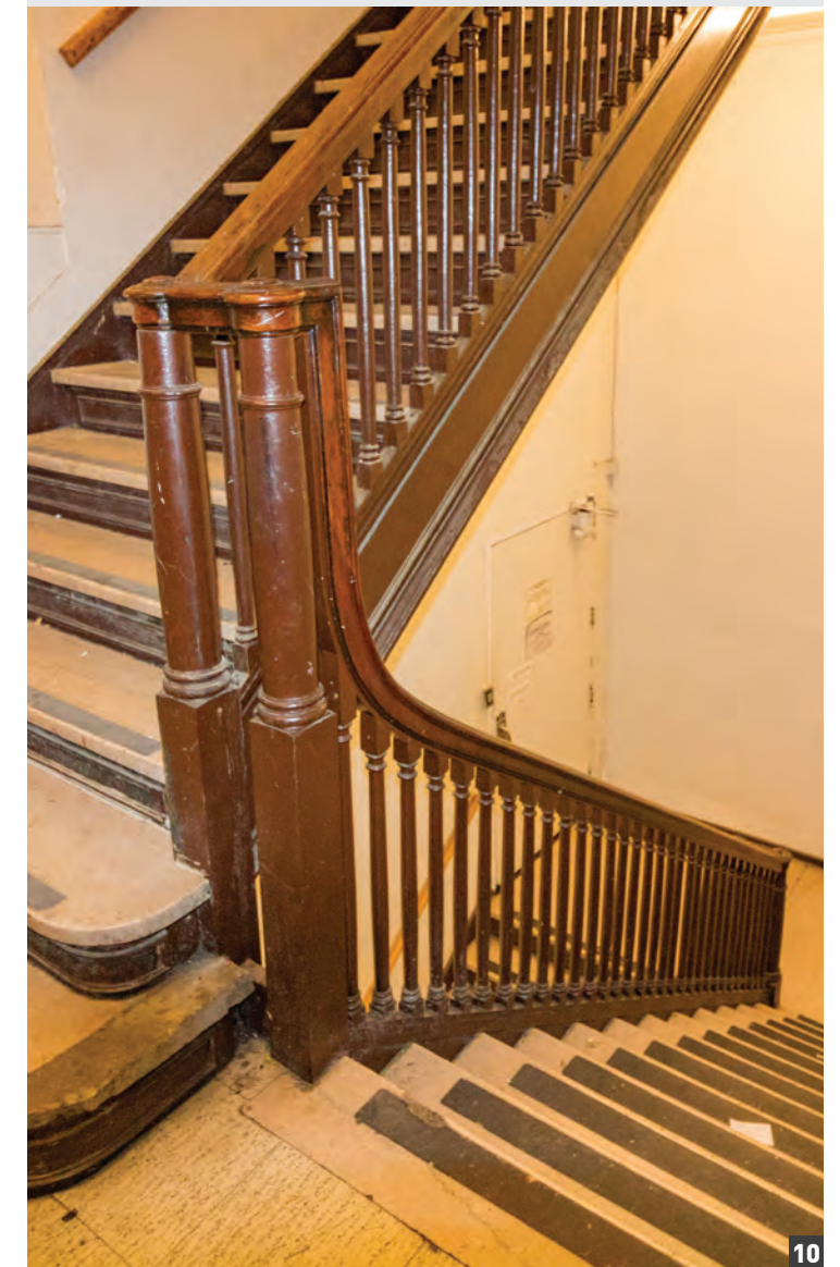
Détail d'escalier en bois
