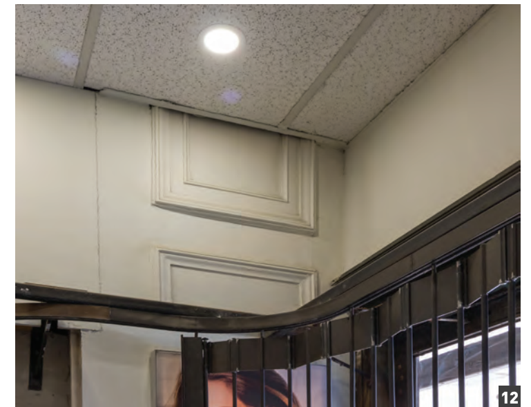
Détail de moulure dans le vestibule d'entrée principale
