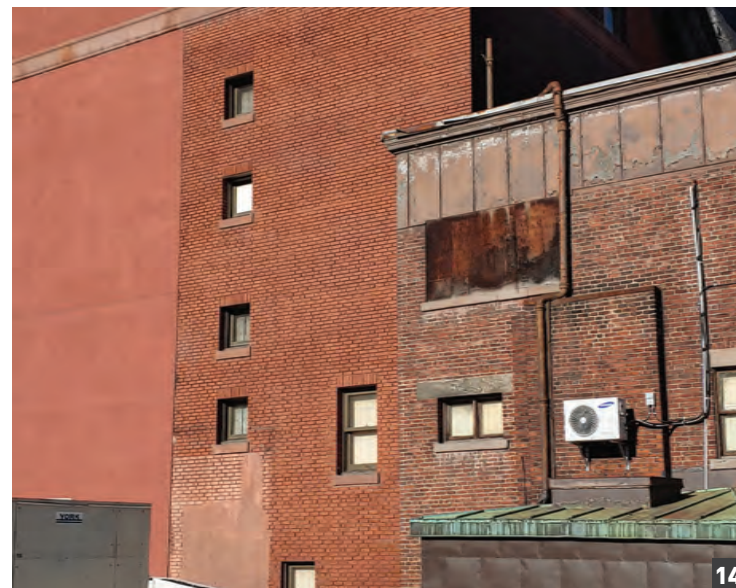
Mur extérieur de la parcelle B2
