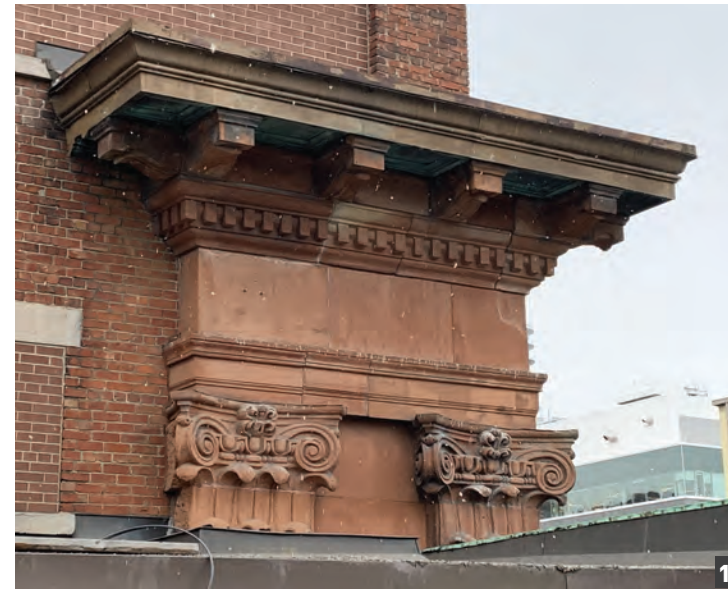
Détail du couronnement des pillastres et de la corniche
