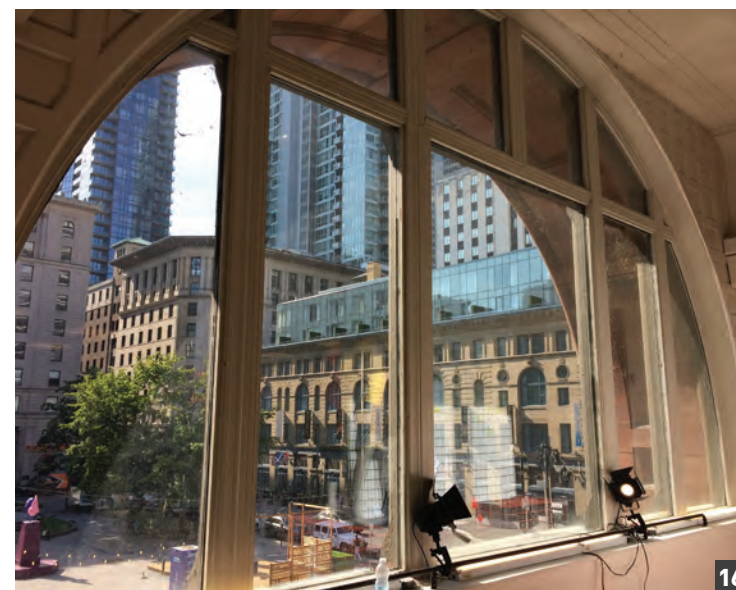
Fenêtre en arc centrale du Colonial House
