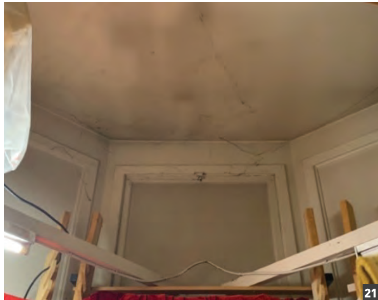
Vue intérieure de la voute se projetant sur le toit du Colonial House
