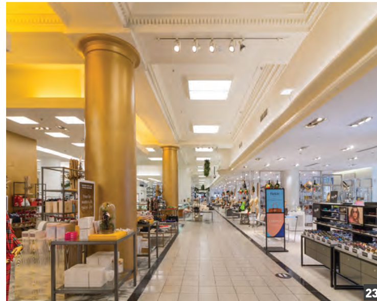
Détail de colonne et de mouluration au plafond - retombée de plafond côté Union
