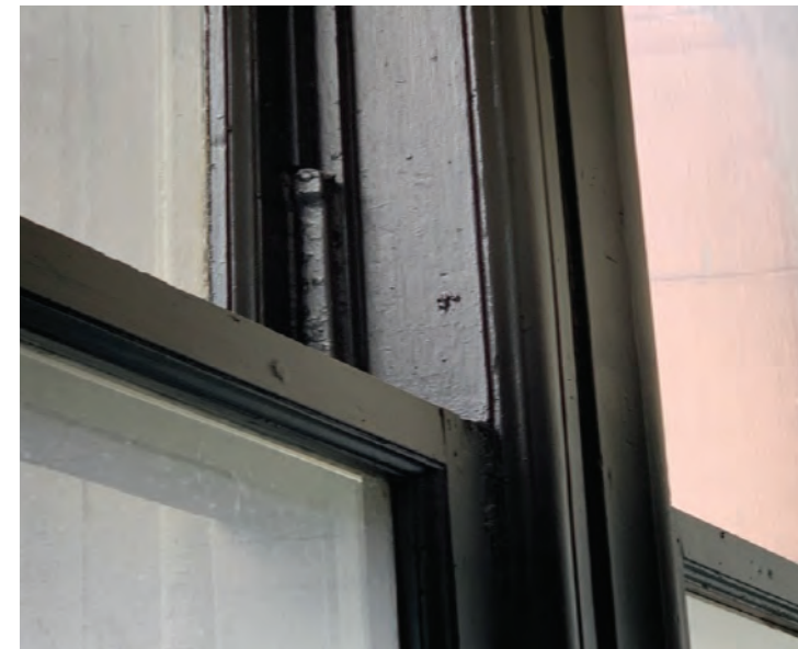
Détails de fenêtres
