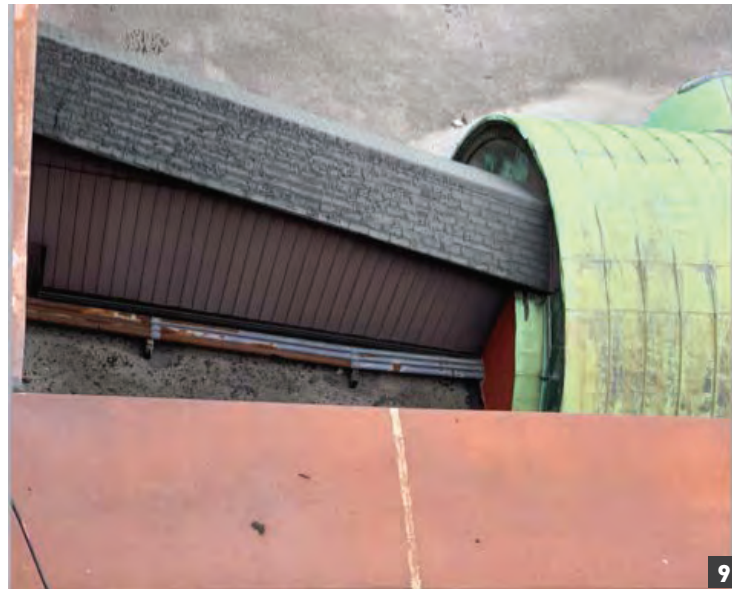
Passerelle d'accès vers l'ancienne galerie d'art
