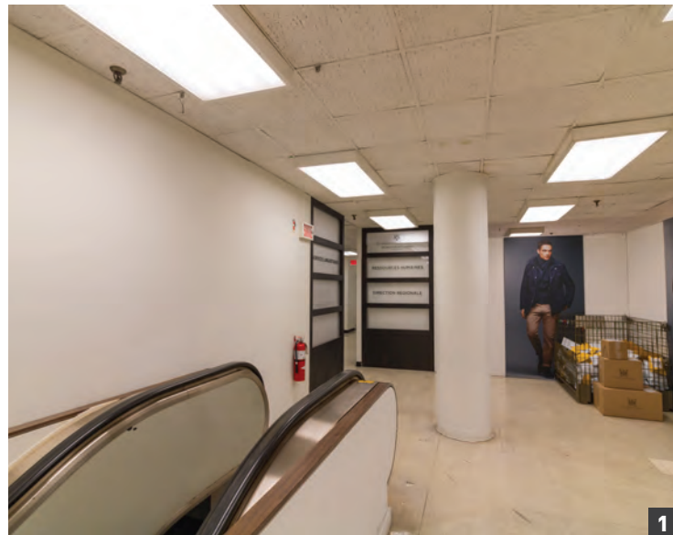
Accès au 8e étage depuis l'escalier mobile
