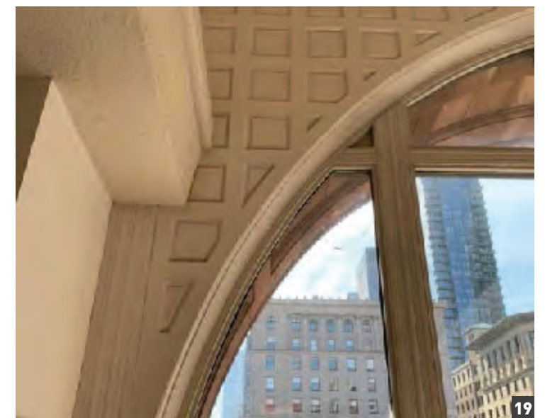
Détail de mouluration de la fenêtre en arc centrale
