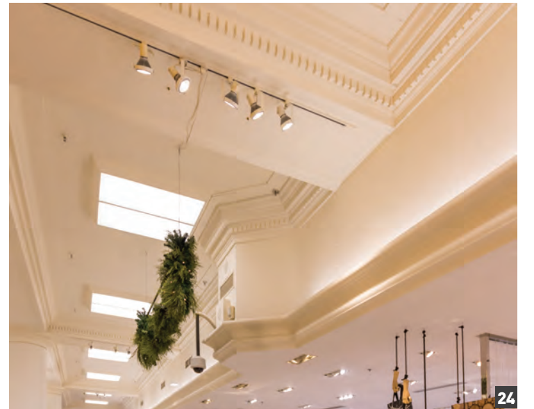
Détail de mouluration
