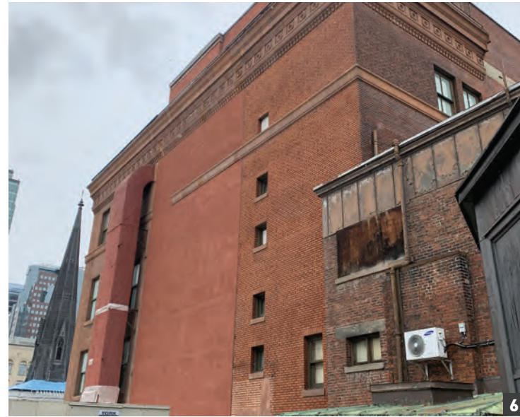
Mur extérieur de la parcelle B2
