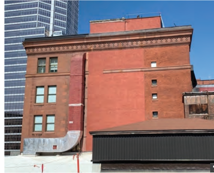
Mur extérieur de la parcelle B2
