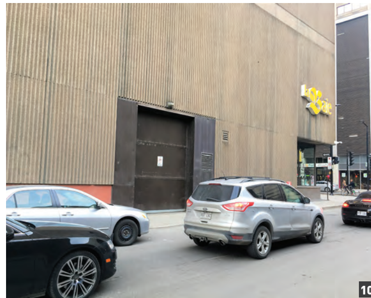
Porte d'accès au garage
