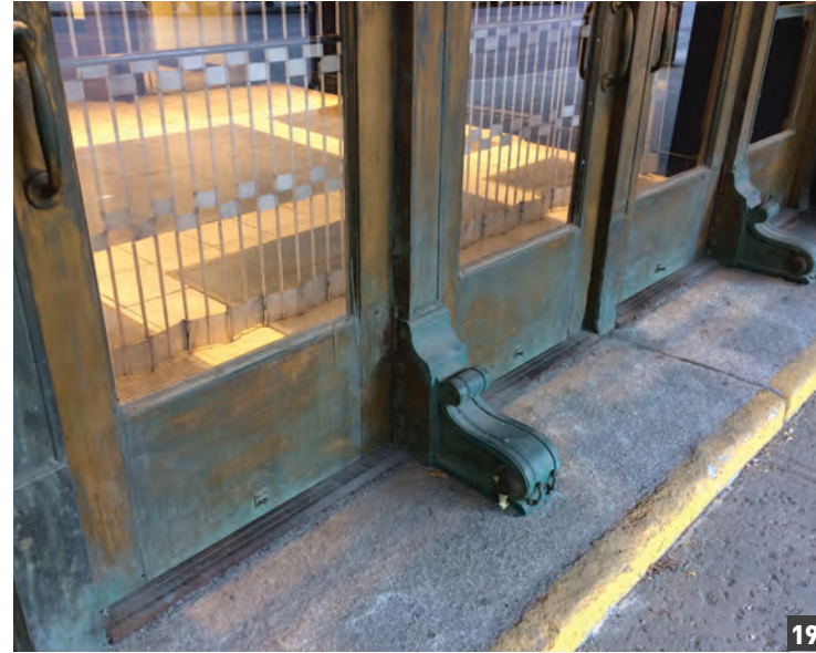
Détail de porte de l'entrée du Colonial House, avenue Union
