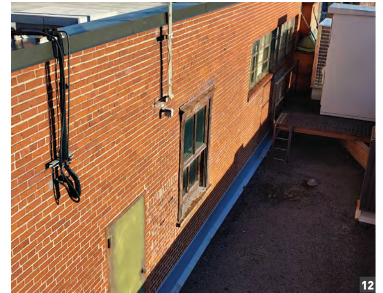
Accès au toit depuis la parcelle B2
