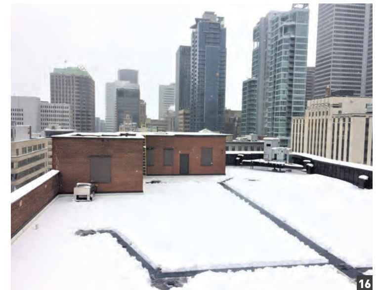
Accès au toit depuis la parcelle B2
