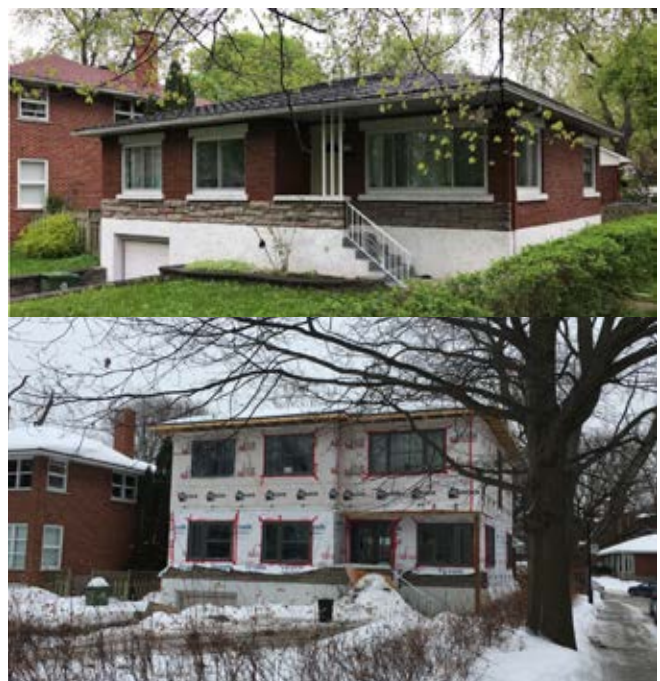
Le bungalow situé au 1354, boulevard Gouin Est a fait l'objet d'un projet d'agrandissement avec l'ajout d'un étage.
