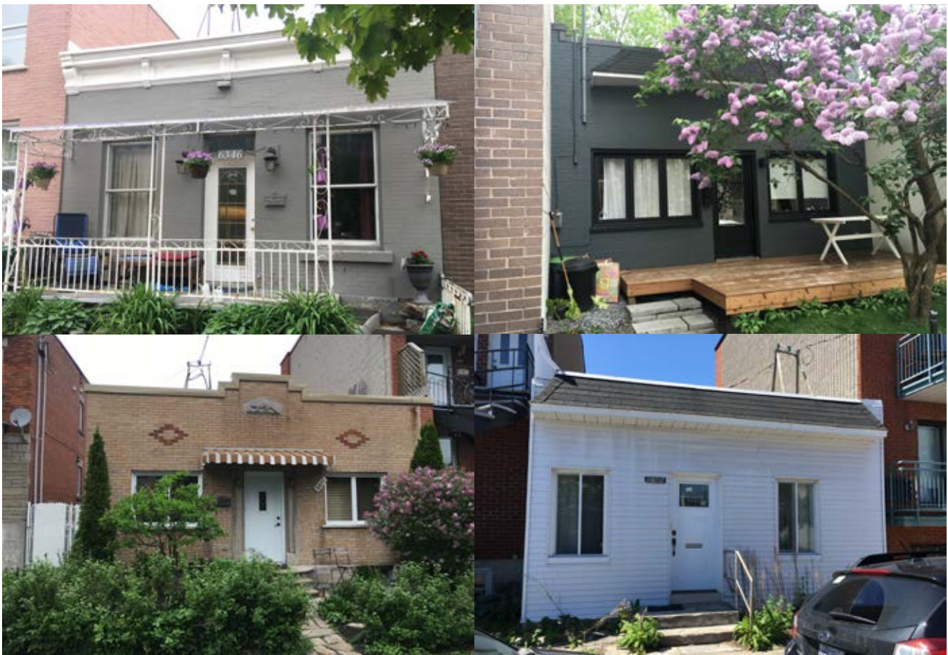
Les maisons de type « shoebox » se caractérisent par leur étage unique et leur toit plat. Certaines présentent en façade un jeu de maçonnerie ou encore une corniche ornementée en bois ou en brique.
