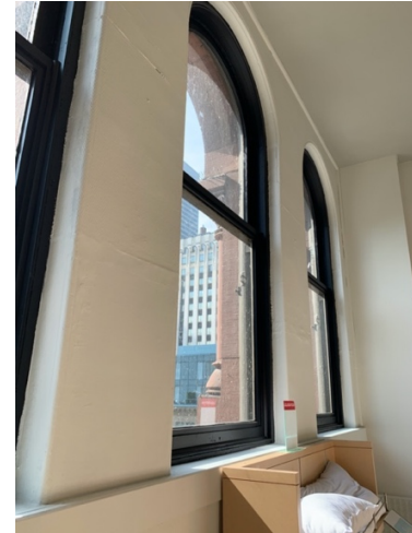
Les cinq ouvertures au centre de la façade principale au 4 e étage. Les cadrages ont en bois et semblent d'origine.
