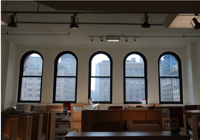
Les cinq ouvertures au centre de la façade principale au 4 e étage. Les cadrages ont en bois et semblent d'origine.
