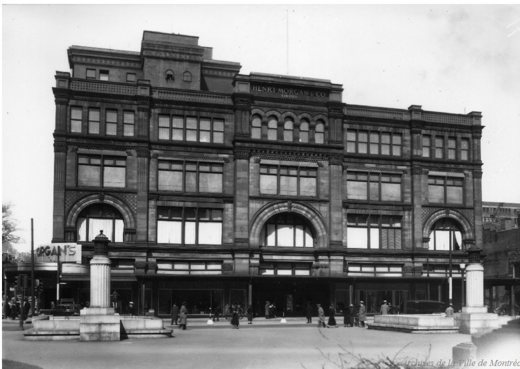
Photo du 30 mars 1936 intitulée : «Édifice Henry Morgan rue Sainte-Catherine Ouest.» Source : AVM, cote : CA M001 VM094-Y-1-17-D0065.
