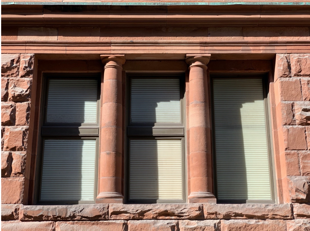
Détail de la façade Est.
