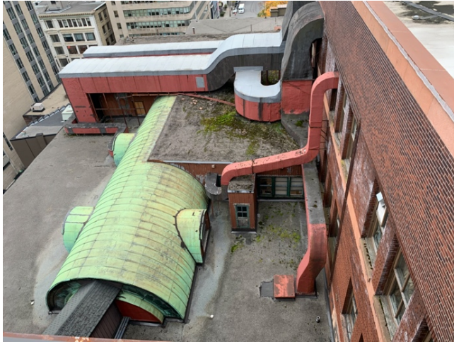
La couverture en cuivre de la voûte sur le toit du 5 e étage de l'agrandissement de 1902 qui couvrait la galerie.
