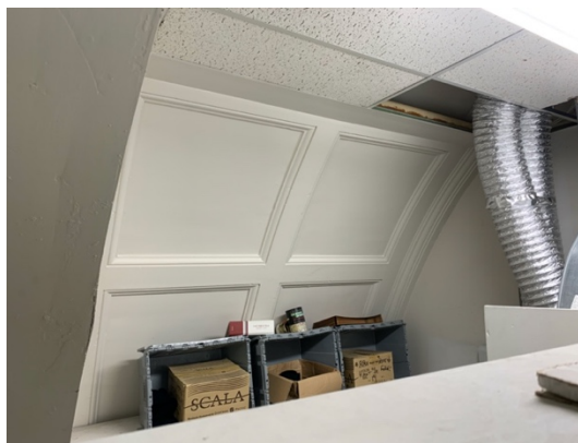
Une partie de l'intrados de la voûte.
