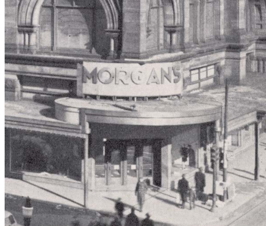
Deuxième génération des vitrines agrandies avec l'entrée à l'intersection. Détail d'une photo datée de 1950. Source : HBC Heritage Corporate Collection.
