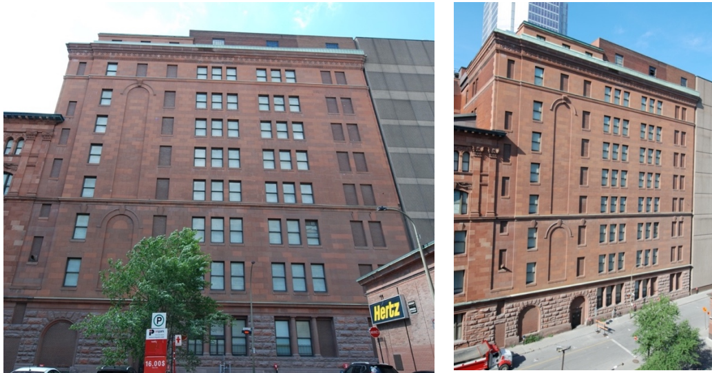
Façade de la rue Aylmer de l'agrandissement de 1923
