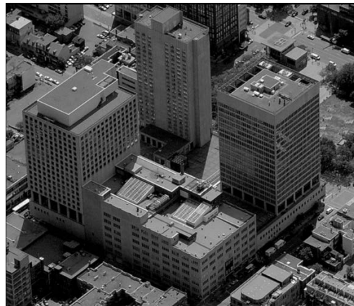
La Place Dupuis, un complexe multi fonctionnel achevé en 1974 qui a éliminé la rue Saint-Christophe et intégré le magasin Dupuis Frères. Source : © www.thedepartmentstoremuseum.org/2011/03/
