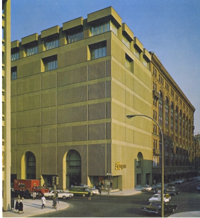
L'édifice construit en 1964-1966. Source : HBC Corporate Collection.
