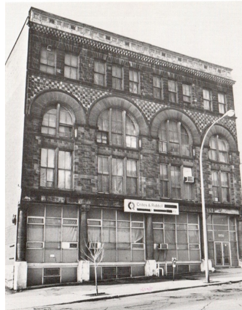
L'édifice Wells & Richardson 1050, rue de la Montagne vers 1985. Source : CUM (1985), p. 241.
