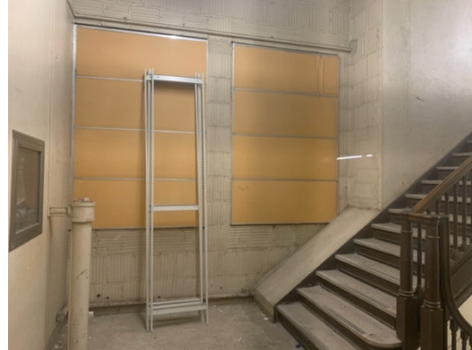
Fenêtres obturées de l'intérieur.
