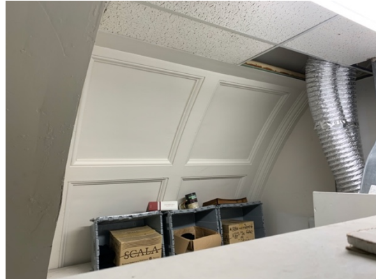
Une partie de l'intrados de la voûte.
