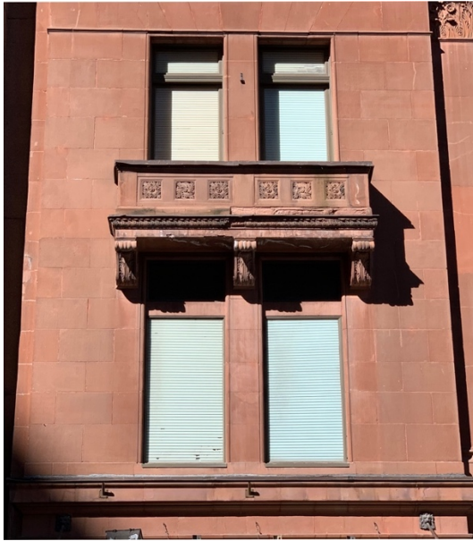
Traitement des balconnets.
