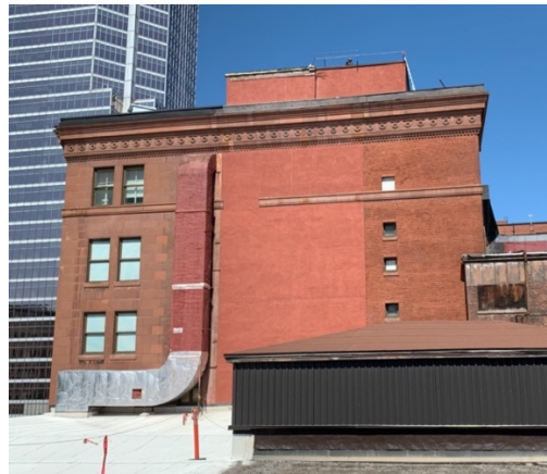
La façade sud de l'agrandissement de 1923.
