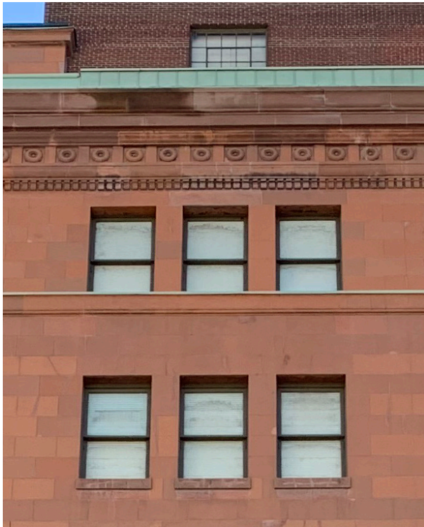
Traitement de la corniche.
