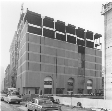
L'agrandissement de 1964 en construction, 16 août 1965. Source : HBC Corporate Collection. À noter, la construction du garage étagé est aussi en cours.
