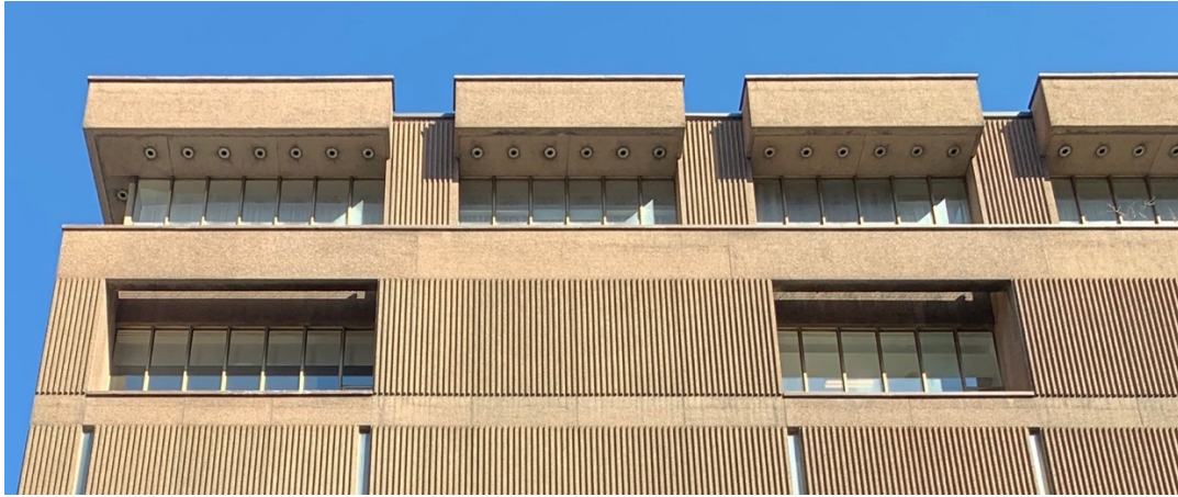
Détail du traitement du couronnement de l'agrandissement de 1964.
