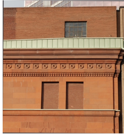
Ouvertures remplacées par de la brique et ajout d'un appentis.
