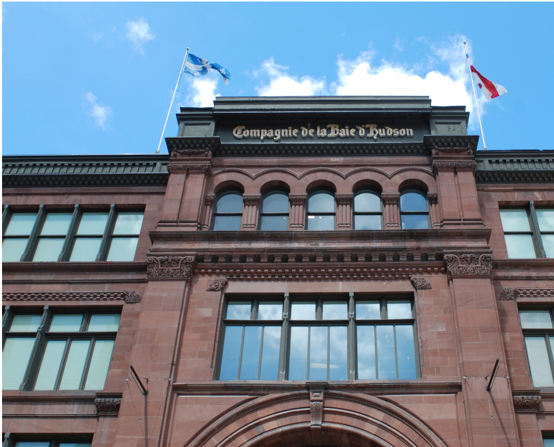
Détail de la façade Ouest.
