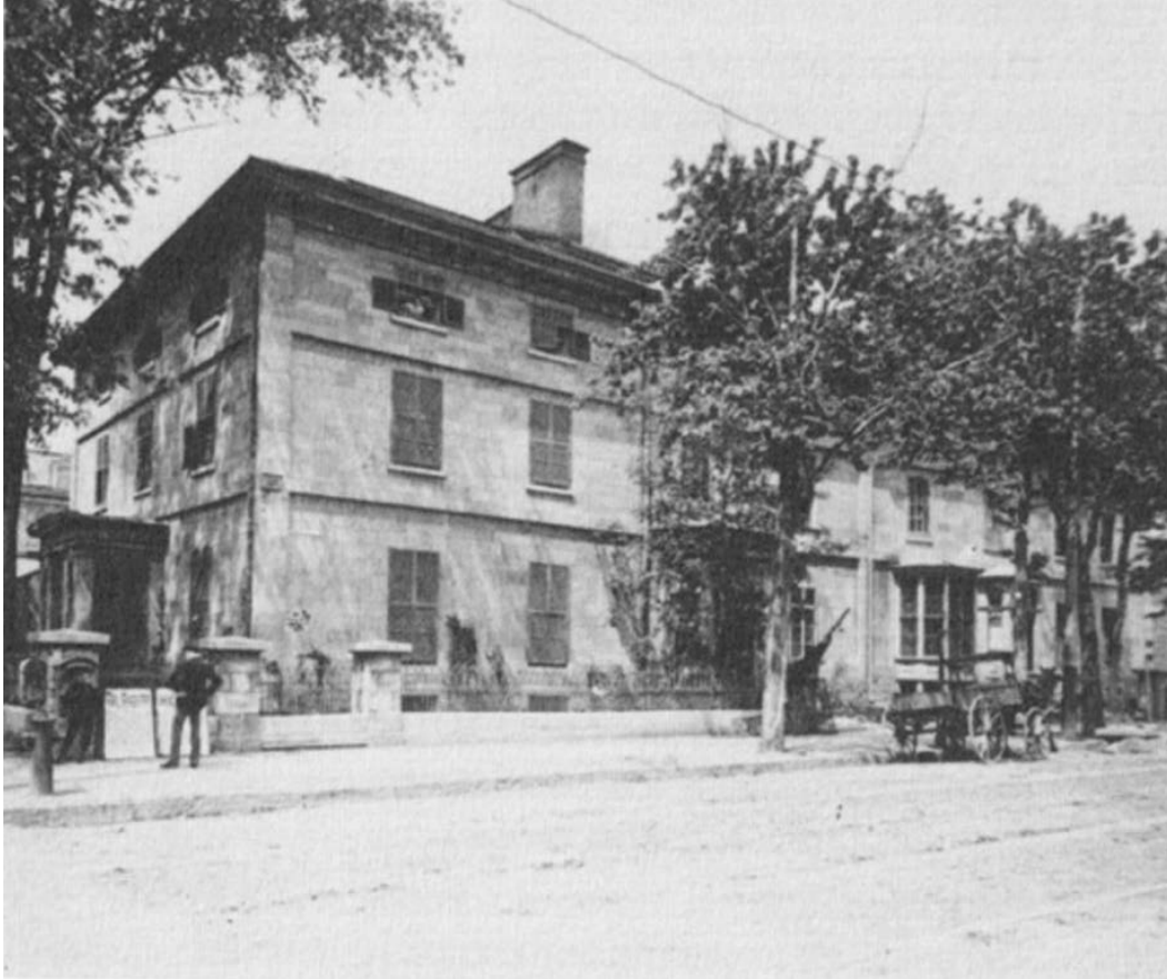
Le coin nord-est de l'intersection de la rue Sainte-Catherine et de l'avenue Union est occupé par la résidence contiguë orientée vers Union (bâtiment à gauche). À droite, les bâtiments visibles correspondent à deux des trois terraced houses (Linden Place), c.1890. Source : Morgan, 1992, p.68.
