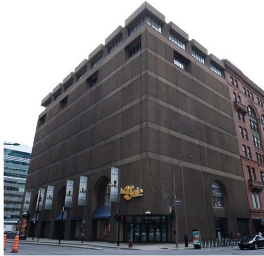
Façades De Maisonneuve et Union.
