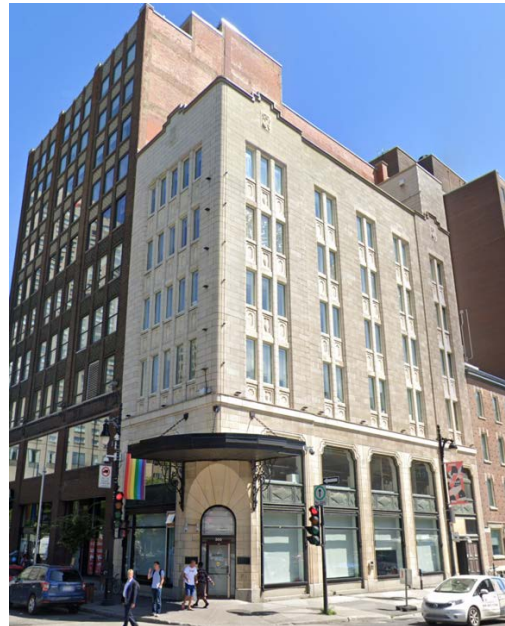
Ancien magasin Archambault, 510, rue Sainte-Catherine Est, Montréal. Source : Google Earth, août 2019.
