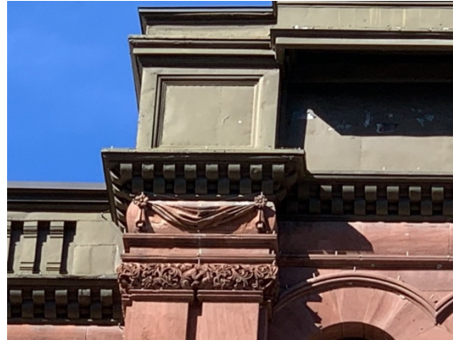
Détail de l'avancée avec les pilastres engagés doublés, la guirlande, les rangées de billettes et le couronnement métallique.
