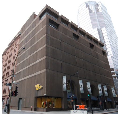
Illustration de l'édifice bâti en 1964-1966.
