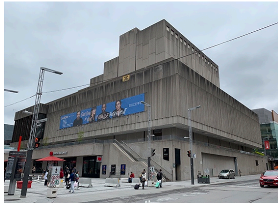
Édifice des Théâtres de la Place des Arts. Source : © Brodeur consultants 2019.
