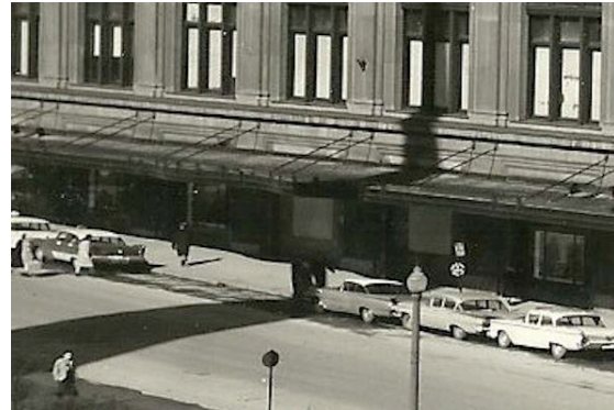
Détail d'une photo vers 1960 qui montre les deux inflexions de la marquise devant les anciennes entrées. Source : Associated Commercial Photographs Ltd. \ Montreal Gazette.
