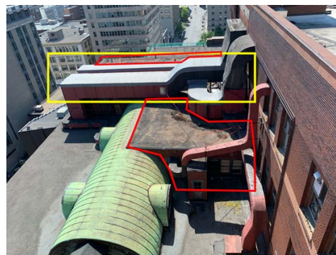
La voûte est chevauchée par des gaines de ventilation (en jaune) et est arrimée avec la construction probable de 1905 (en rouge).
