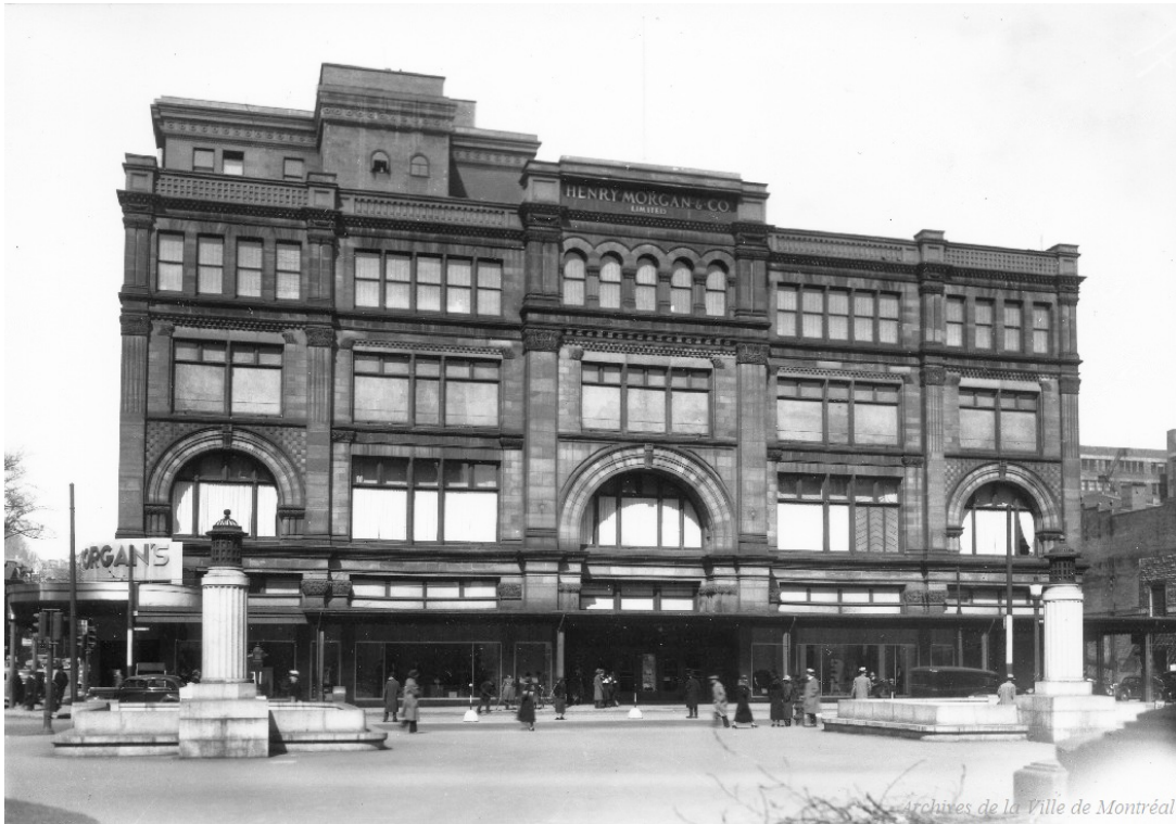
Sur cette photo de 1936, la marquise est modifiée et les vitrines ont été renouvelées. Nous posons l'hypothèse que la porte de coin est aménagée. Source : AVM, cote CA M001 VM094-Y-1-17-D0065.
