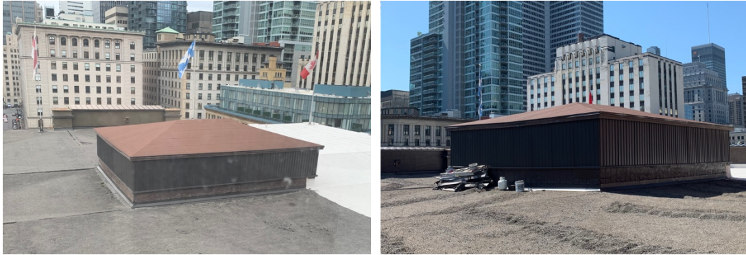
L'ancien lanterneau aujourd'hui aveuglé qui éclairait le puits au centre du plan du Colonial House.
