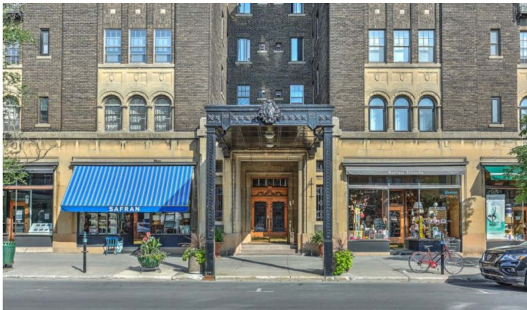
Les Appartements Royal York, 1120, avenue Bernard, Outremont. Source : © Engel & Völkers Montréal Québec.
