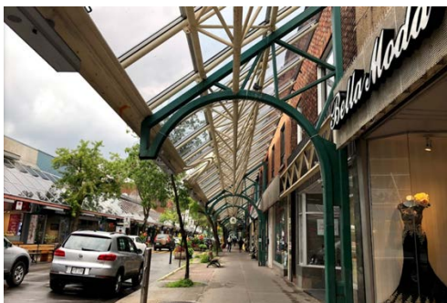
La marquise de la rue Saint-Hubert récemment démantelée. Photo : © Adama Diop, août 2018.
