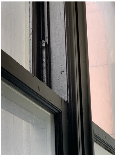
Fenêtre du 6 e étage avec son mécanisme d'ouverture d'origine.
