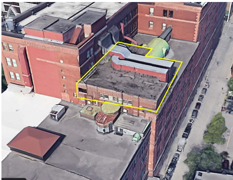
Partie d'étage ajoutée. Source : Google Earth.
