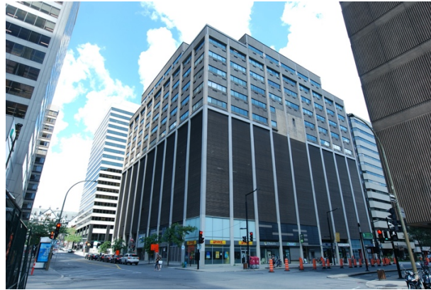
Le Parkade a été substantiellement modifié avec l'installation d'un nouveau revêtement pour les niveaux stationnement et l'ajout de 6 étages utilisés à des fins de bureaux en 1976.
