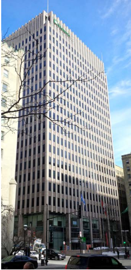
Édifice Standard Life , 1245, rue Sherbrooke Ouest, Montréal Durnford, Bolton, Chadwick & Ellwood (1960-1962). Source : © Brodeur consultants, 2018.
