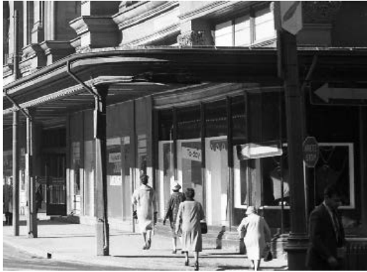
Détail d'une photo du 1 er octobre 1964. Source : AVM, cote VM94-A0107-020.
