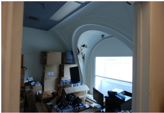
Une lunette du côté ouest de la voûte.
