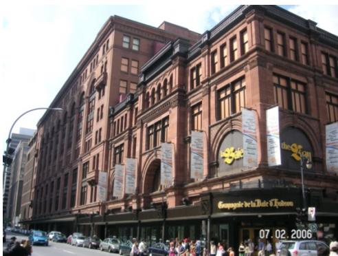
L'état de la marquise en 2006. Source : © Brodeur Consultants, 2006.
