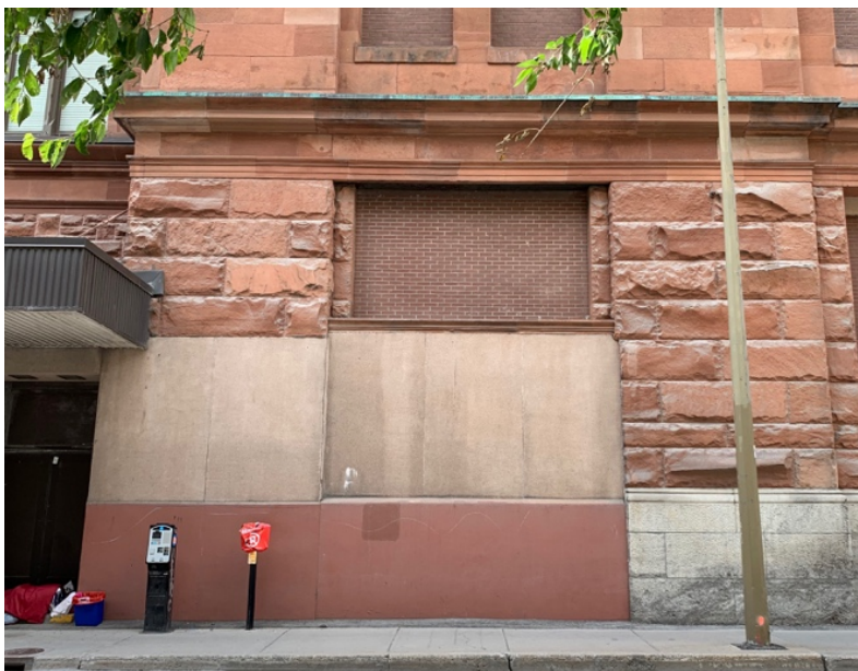
Nouveau traitement de la première travée au niveau du rez-de-chaussée.
