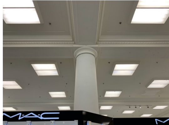
Détails du plafond au rez-de-chaussée du Colonial House.
